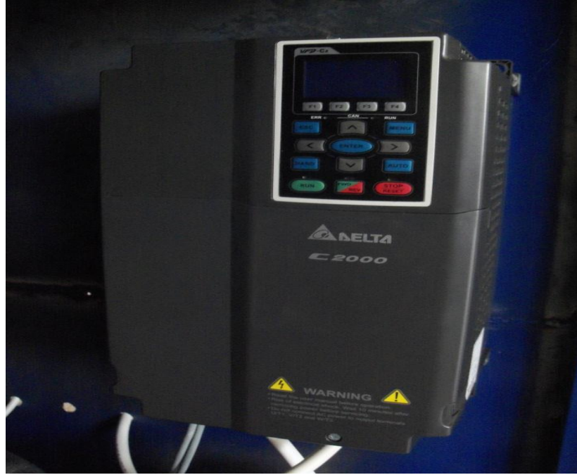
Şekil 3.8. Elektronik devir ayarlayıcı (invertör)
