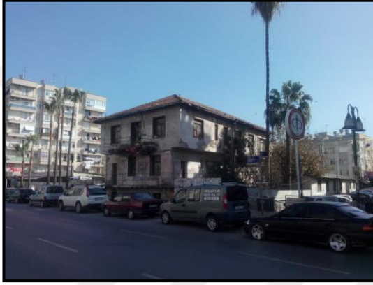
İki Katlı Harabe Yapı
