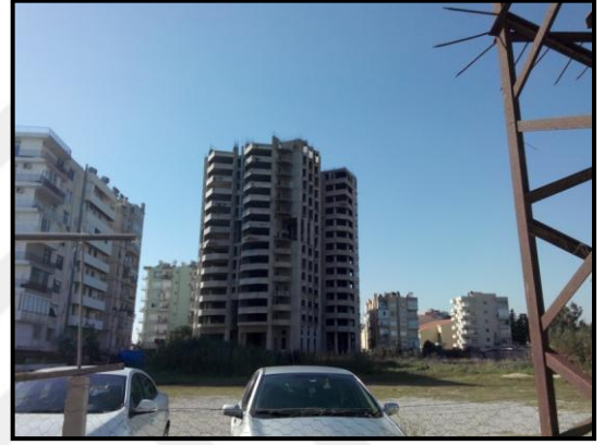
İnşaat Halindeki Yüksek Katlı Yapı
