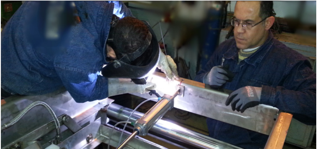
Şekil 4.35. Piston bağlantı noktalarının nihai yerleşimlerinin yapılması
