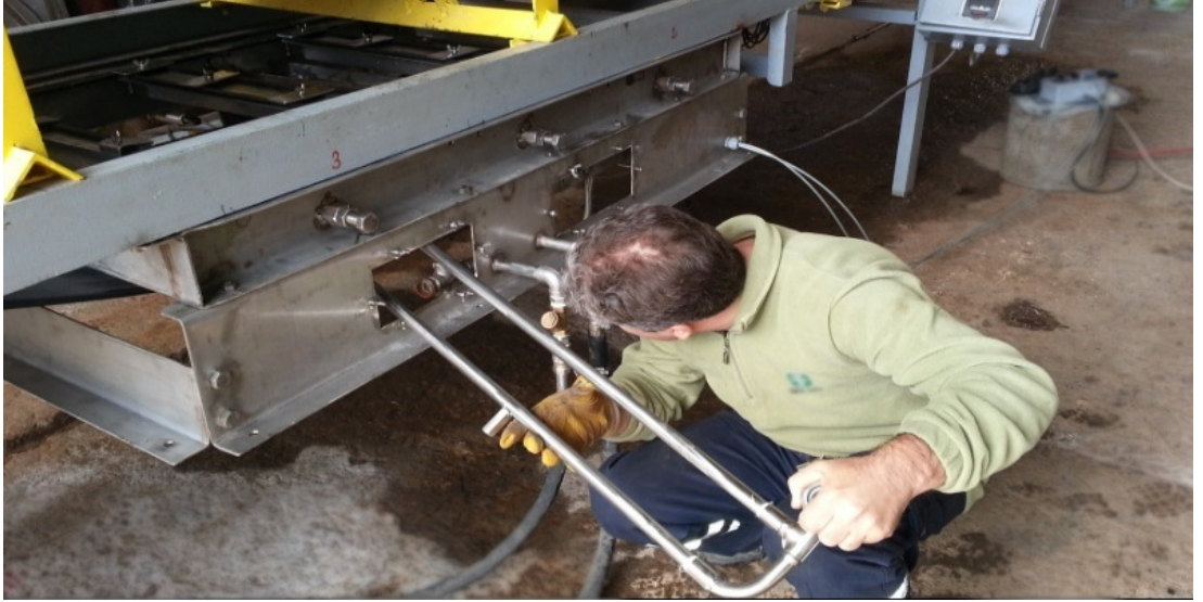
Şekil 4.43. Hava tesisatının montajı
