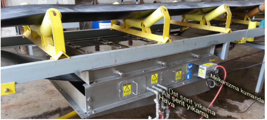
Şekil 4.57. Yıkama sisteminin son düzenlemeler kapsamında fotoğrafı
