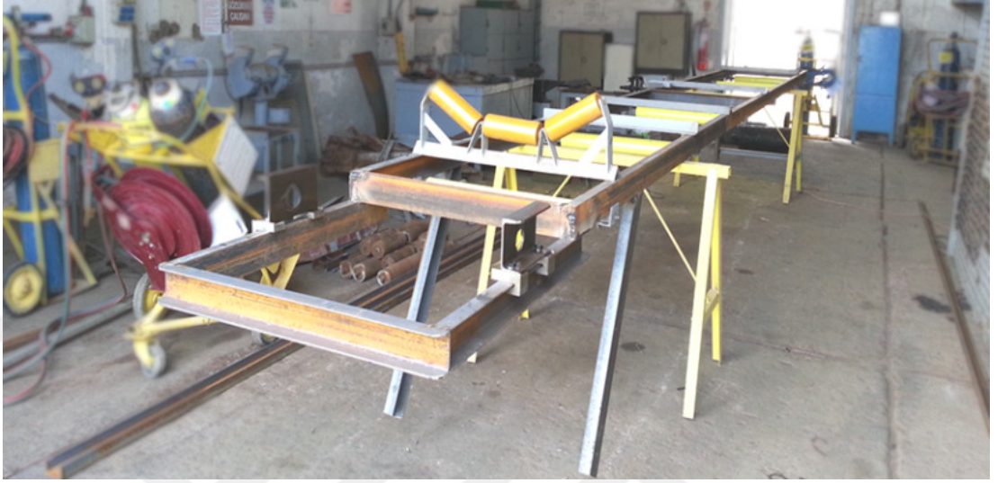
Şekil 3.22. Banlı konveyör çelik şasi imalatından bir görünüm
