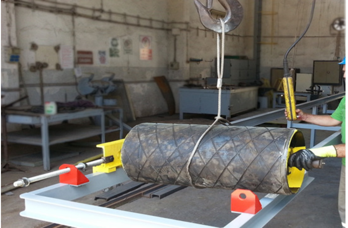
Şekil 3.23. Banlı konveyör şasisine tambur montajı
