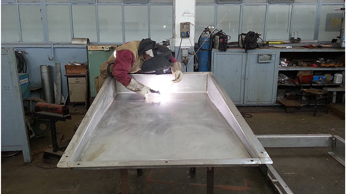
Şekil 4.31. Alt hazne (Poz-21_7A) kaynaklı imalatından bir görünüm
