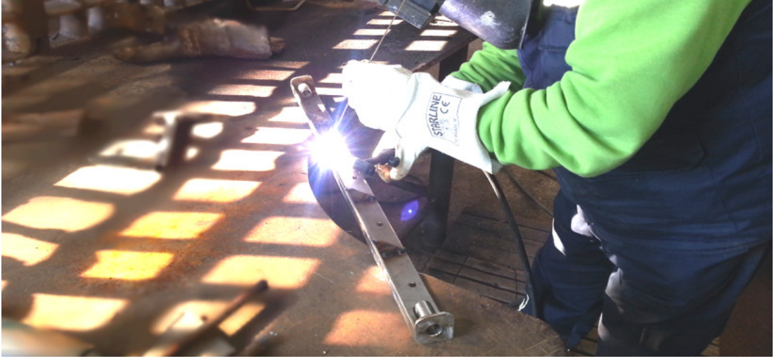
Şekil 4.10. Alt sıyrıcı destek parçası kaynaklı güçlendirme imalatından bir görünüm
