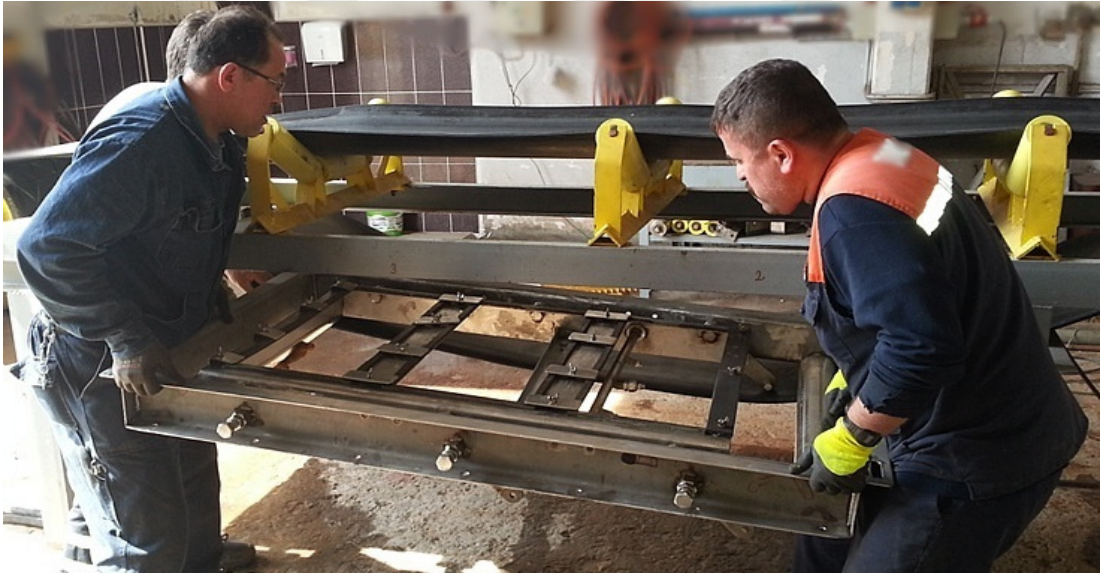
Şekil 4.39. Gergisi alınan bant arasına yıkama sistemi üst grup yerleştirilmesi
