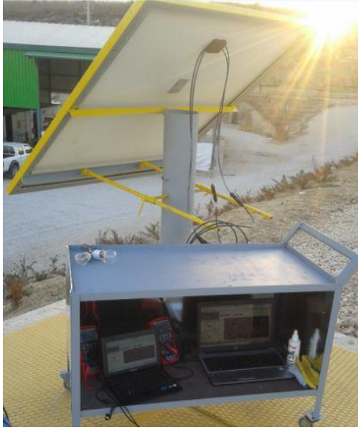
Şekil 3.4. Güneş paneli ve veri kayıt sistemi genel görünümü
