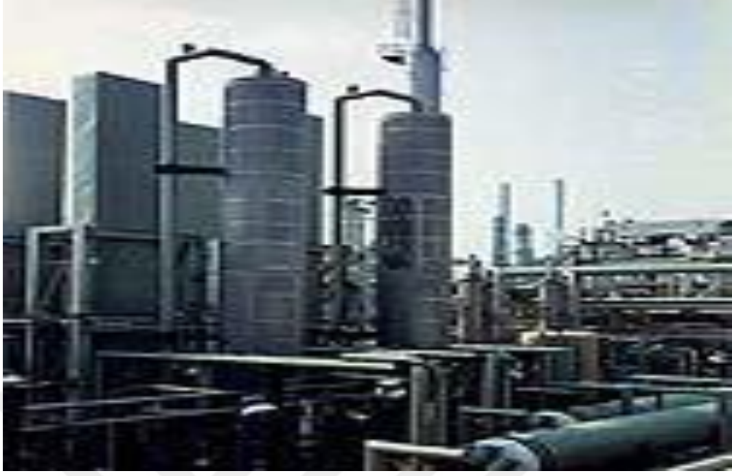
Şekil 2.4. Endüstriyel ıslak hava oksidasyonu sistemi-Texas Amerika [Gizir vd., 2006].
