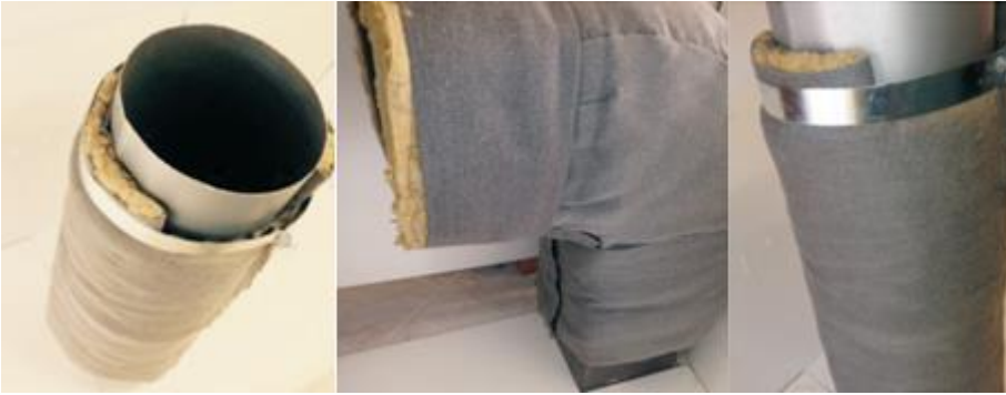
Şekil 3. 2. Disipatif yalıtım uygulamaları
