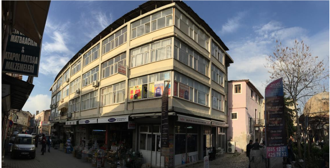
Şekil 5.5. Kantar Ağa Hanı yerine inşa edilen iş hanı binası
