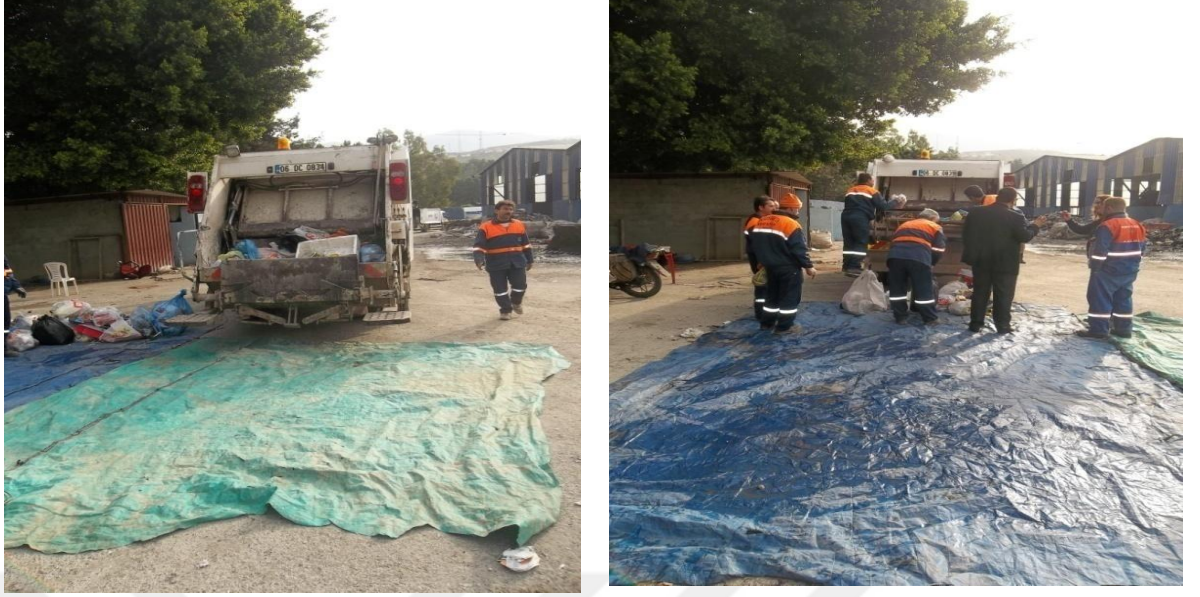
Şekil 3.2. Atıkların sahaya getirilmesi
