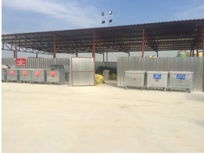
Şekil 3. 2. Mersin Entegre Sağlık Kampüsü Atık Depolama Alanı
