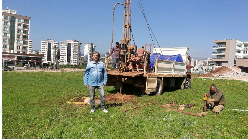
Şekil 4.33. SD-5 Sondaj çalışması (Çiftlikköy Mahallesi, Yenişehir)
