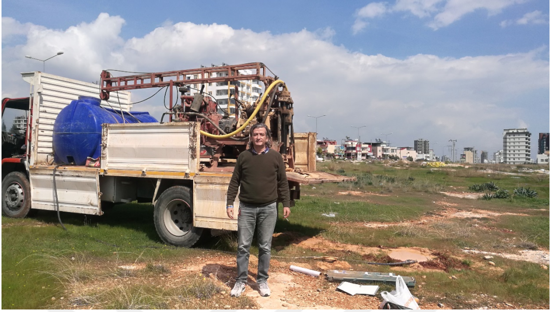
Şekil 4.22. SD-1 Sondaj çalışması genel görünüm (50. Yıl Mahallesi, Yenişehir)
