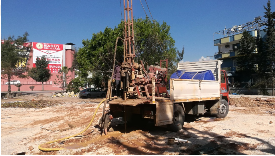
Şekil 4.27. SD-3 Sondaj çalışması (Zeki Ayan Mahallesi, Toroslar)
