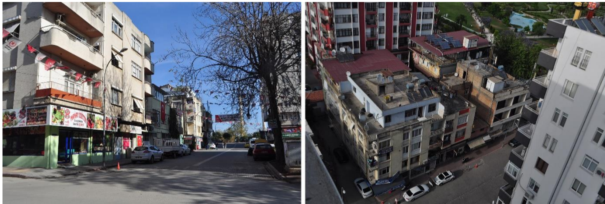
Şekil 4.21. 1463 numaralı adanın konut bölgesinden iki görünüm, günümüz (Kaynak: Yazar).
