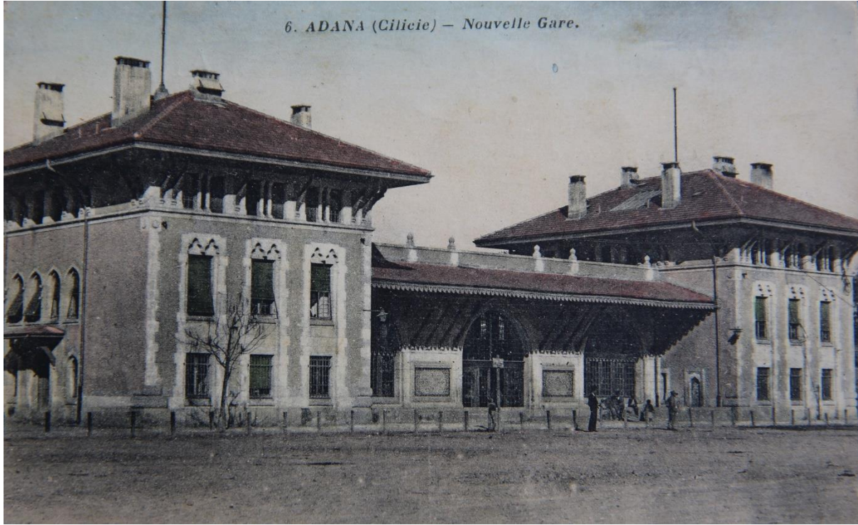
Şekil 3.3. Adana'da inşa edilen istasyon binası, 1911 ( ABTÜ Kütüphane Arşivi, 2019).
