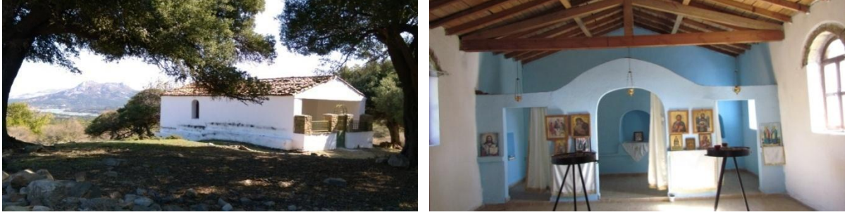
Şekil 4. 133-134. Tepeköy Dam Yapı Kalıntıları ve Onarılarak Kullanılan Şapel (Kaynak: Kişisel arşiv)
