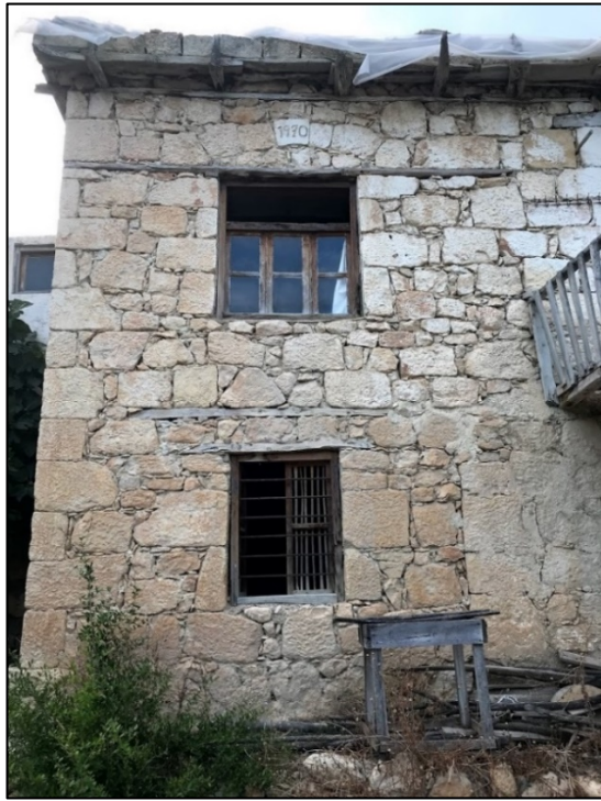
Şekil 4.43 Binadaki yassı kemer üzerinde bulunan kitabe
