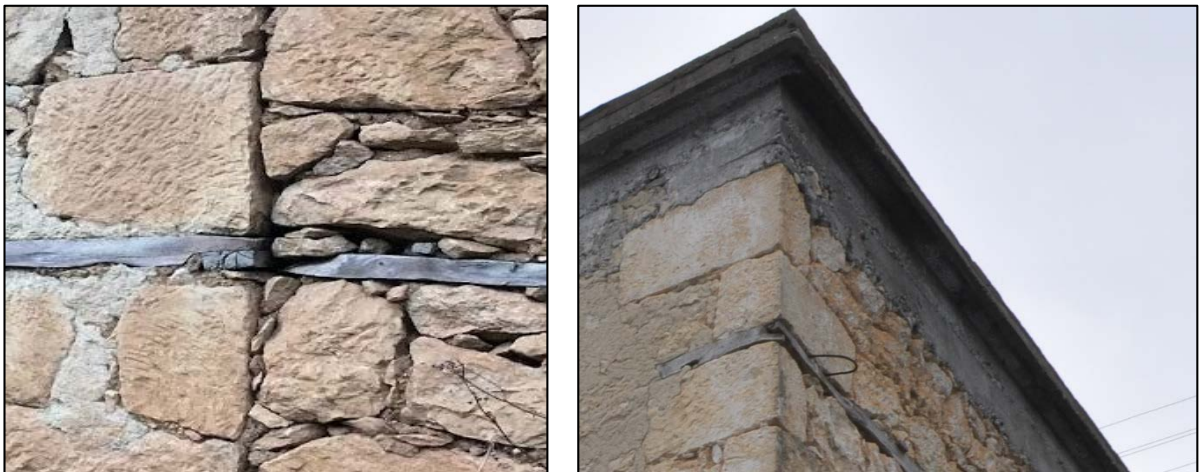
Şekil 4.29 Hatıl birleşim detayları
