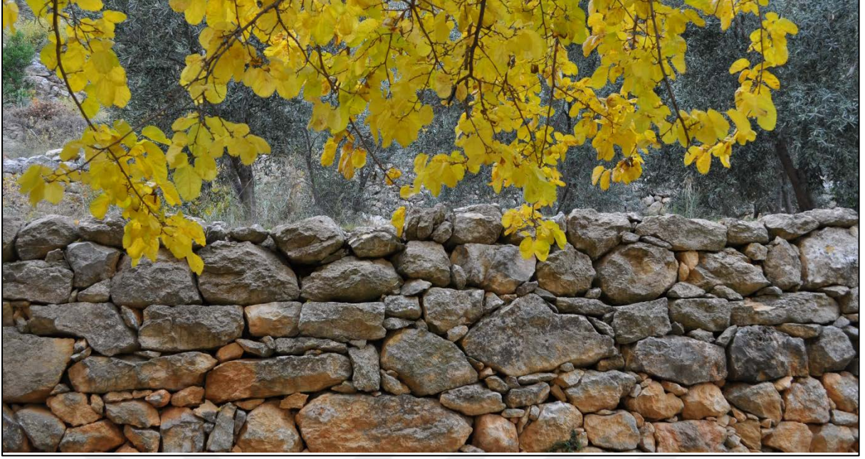
Şekil 4.18 Eski yerleşimin güney bölgesinde bulunan cami önündeki istinat duvarı
