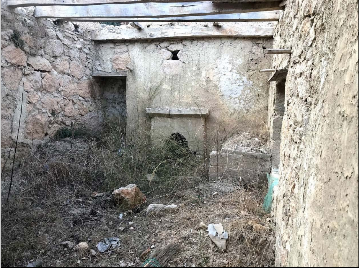
Şekil 4.40 348 numaralı parselde bulunan yapıya ait fotoğraflar
