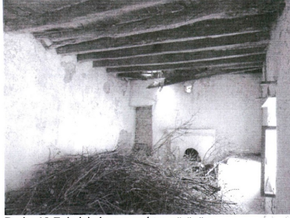
Resim 19-Evin içinden ve ocaktan görünüm.
