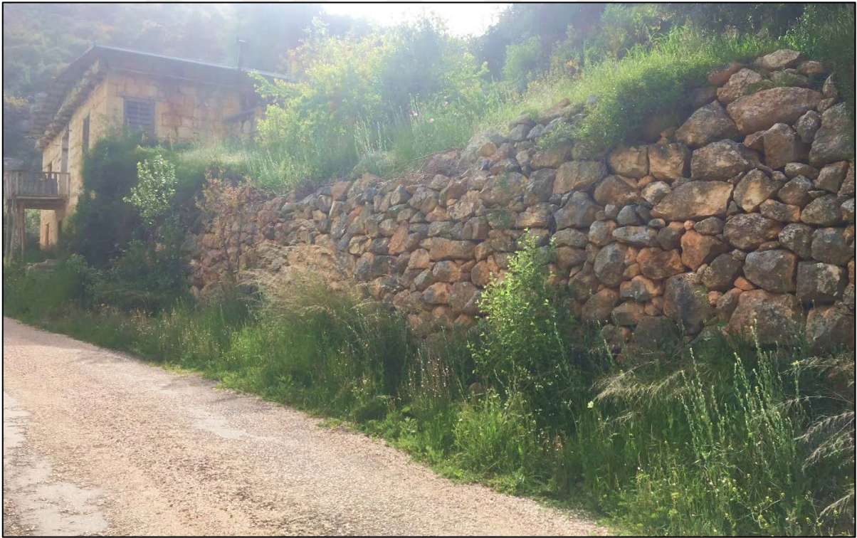
Şekil 4.17 Eski yerleşim yerine ait istinat duvarı örgüsünden örnek
