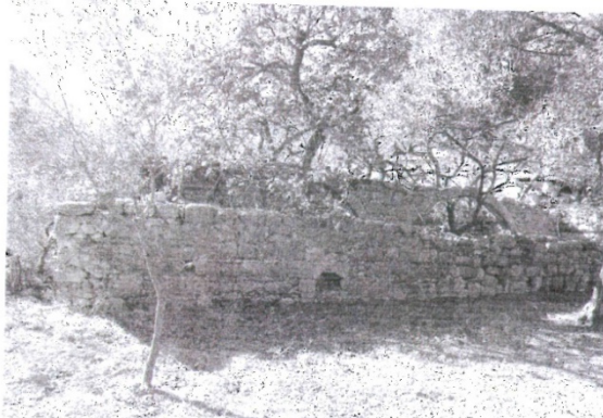
Resim 25-364 ve 366 parseller üzerinde yer alan eski yıkık Camiden görünüm.
