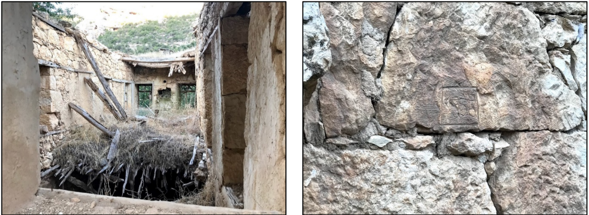
Şekil 4.70 377-378 numaralı parselde bulunan yapıya ait fotoğraflar
