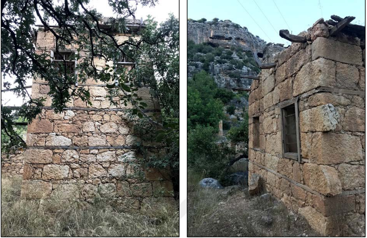
Şekil 4.69 377-378 numaralı parselde bulunan yapıya ait fotoğraflar
