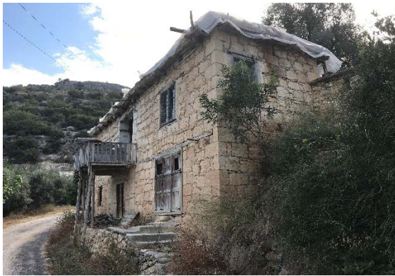
Şekil 4.31 352nolu parseldeki yapının çatı durumu
