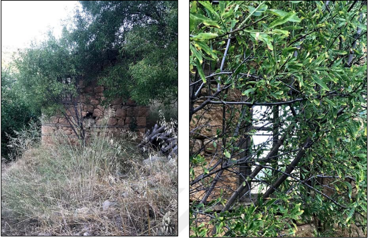
Şekil 4.46 357 numaralı parselde bulunan yapı kalıntısı
