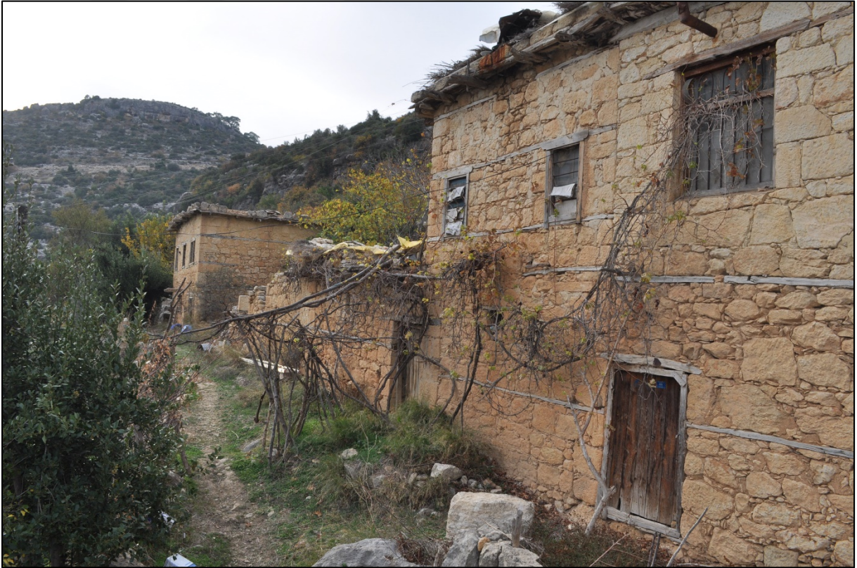
Şekil 4.59 363 Numaralı Parselde Bulunan İki Katlı Bina
