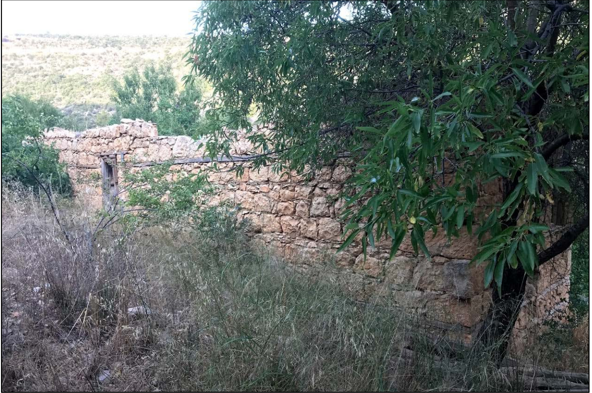
Şekil 4.45 357 numaralı parselde bulunan yapı kalıntısı
