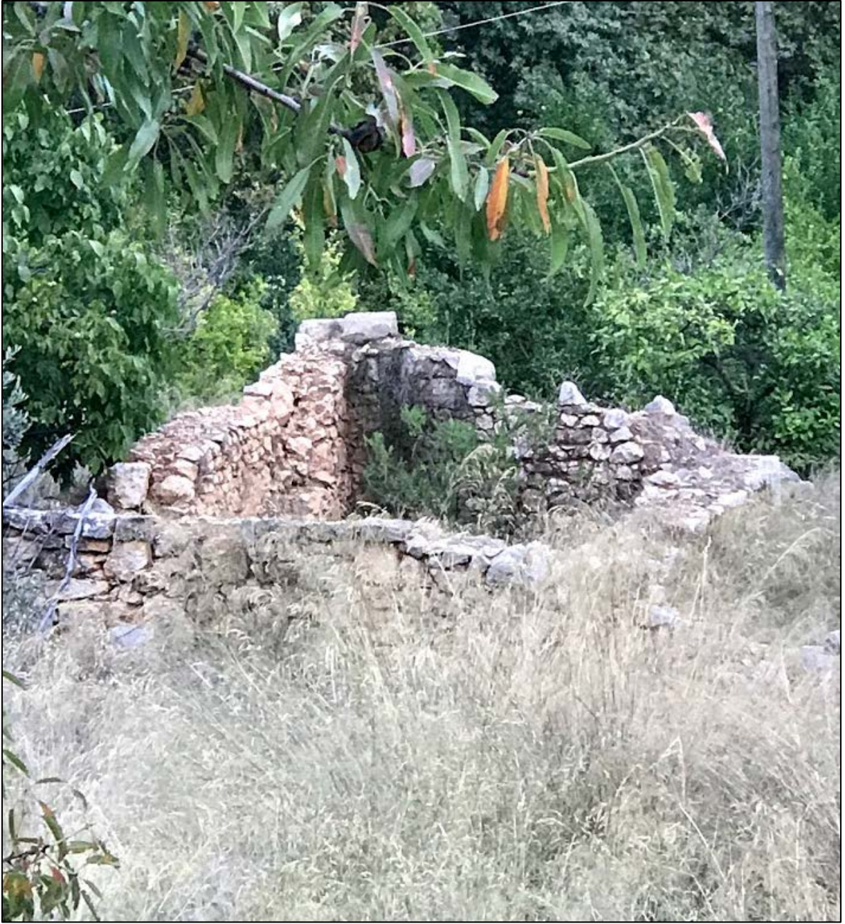
Şekil 4.77 382 numaralı parselde bulunan yapı kalıntısı
