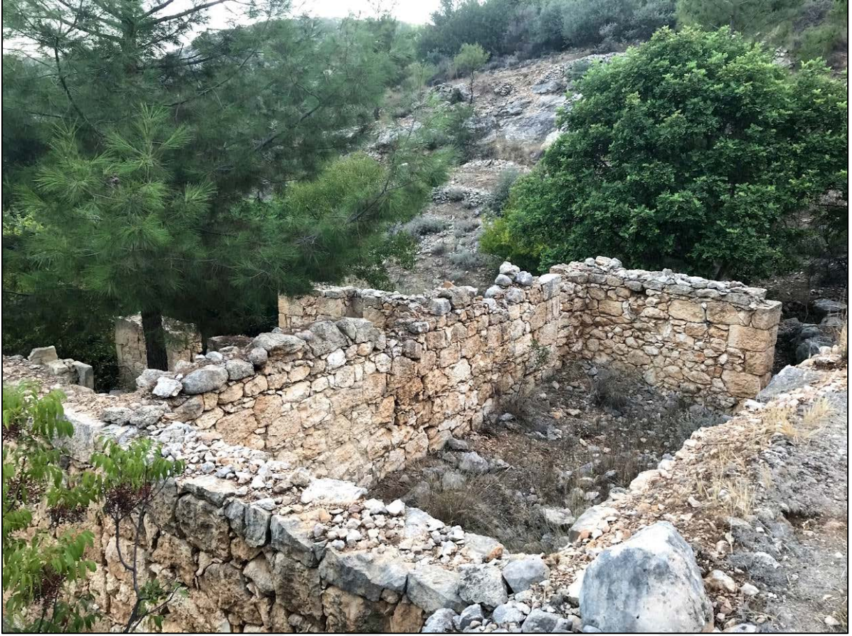
Şekil 4.75 381 numaralı parselde bulunan yapı kalıntısı
