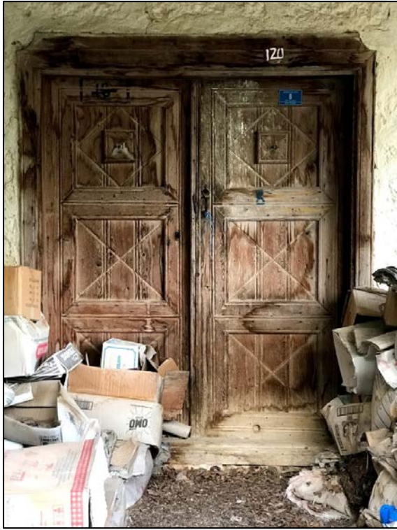
Şekil 4.51 Yapıya ait dış kapı detayı
