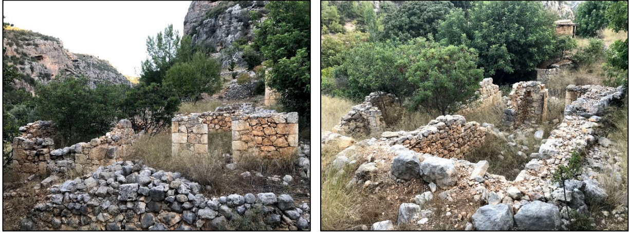
Şekil 4.72 377-378 numaralı parselde bulunan yapıya ait fotoğraflar
