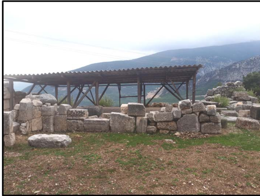
Fotoğraf 24. Geç Dönem Kilisesi Güney Beden Duvarı
