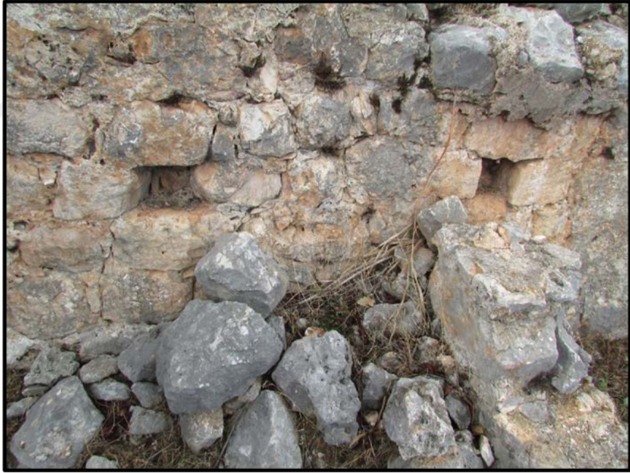
Fotoğraf 120. Sura Geç Dönem Kilisesi Kuzey İç Duvar Detay
