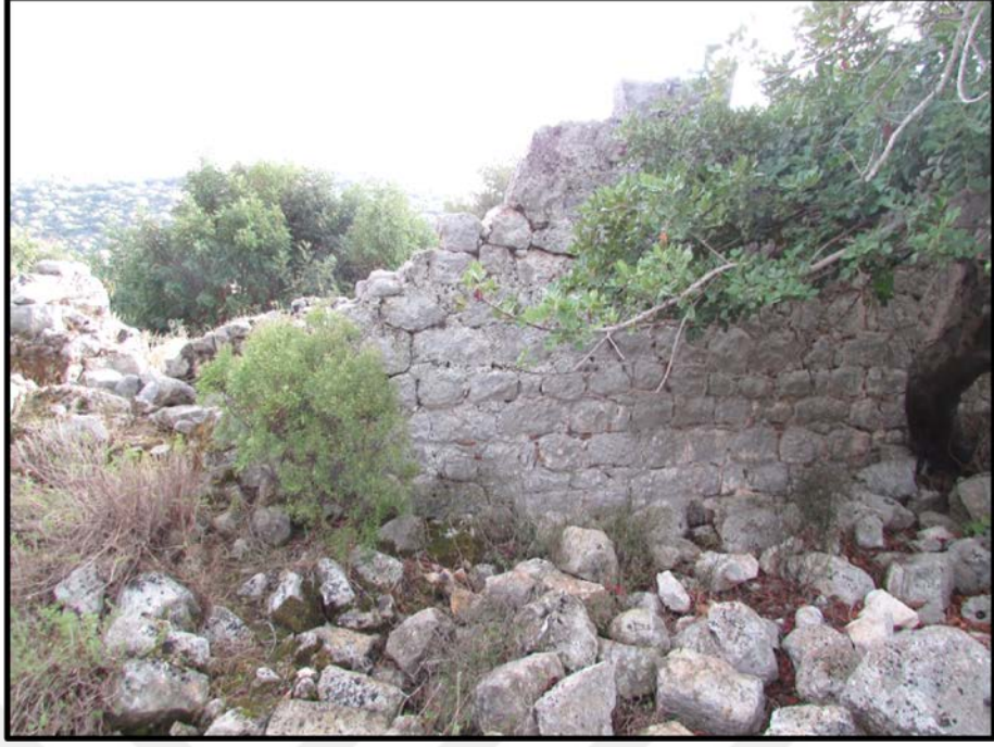
Fotoğraf 131. Sura Geç Dönem Kilisesi Kuzey Beden Duvarı
