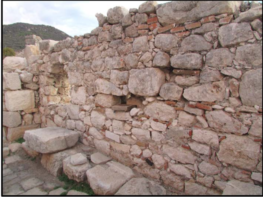
Fotoğraf 94. Şapel Güney Beden Duvarı İçten Görünüm
