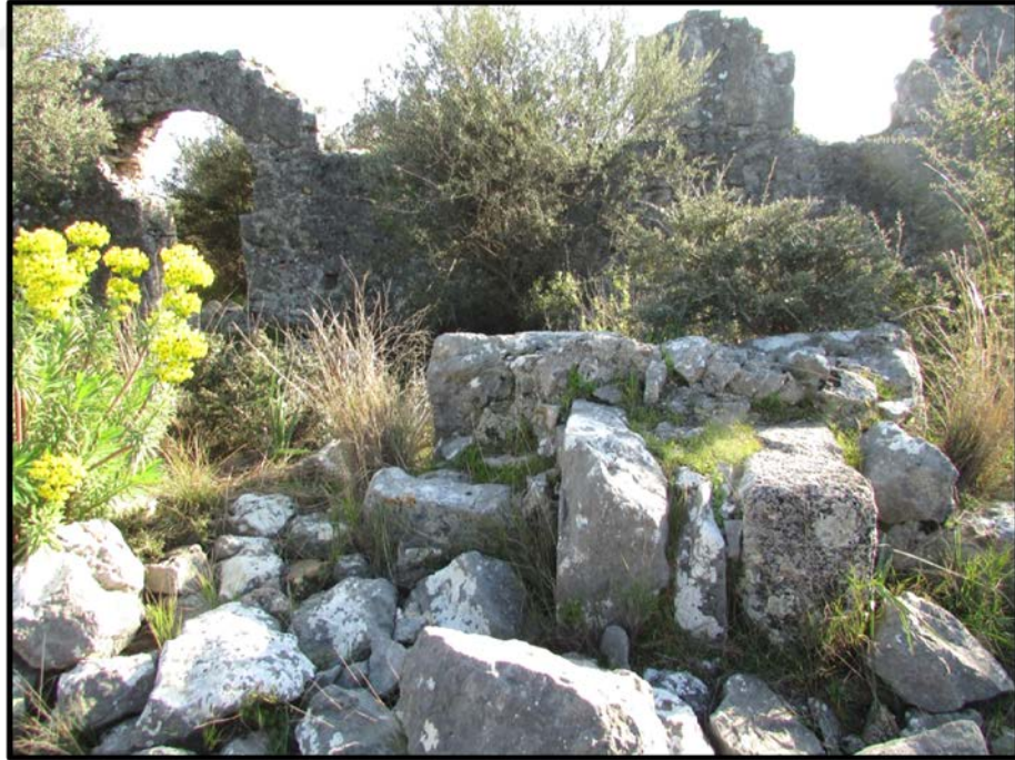
Fotoğraf 144. Xanthos Geç Dönem Kilisesi Kuzey Duvar Kalıntıları
