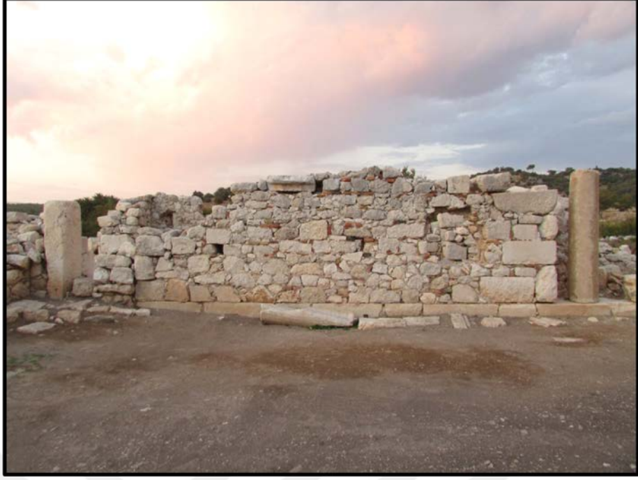
Fotoğraf 69. Patara Kent Bazilikası Şapel Güney Beden Duvarı
