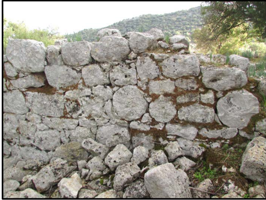
Fotoğraf 136. Sura Erken Dönem Bazilikası Güney Beden Duvarı Devşirme Malzemesi
