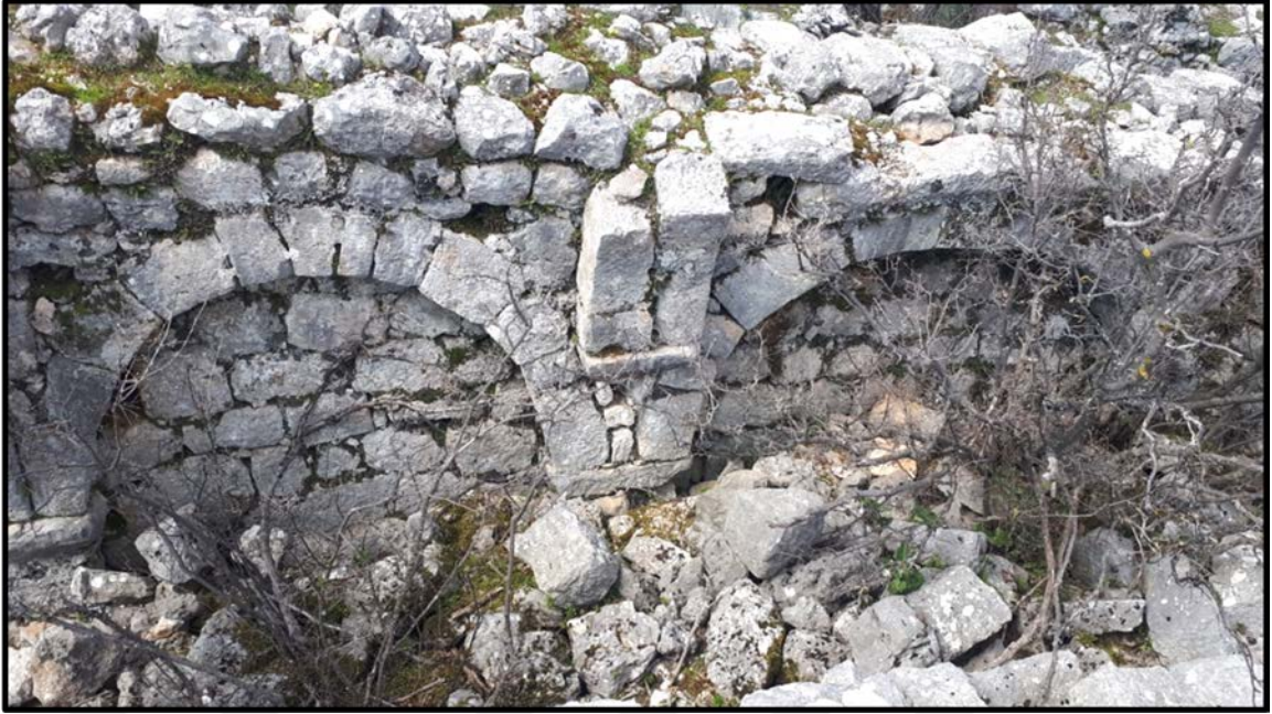
Fotoğraf 37. Kyaneai B Bazilikası Narteks Bölümü Batı Duvarı Kör Kemerler ve Kemer İzi
