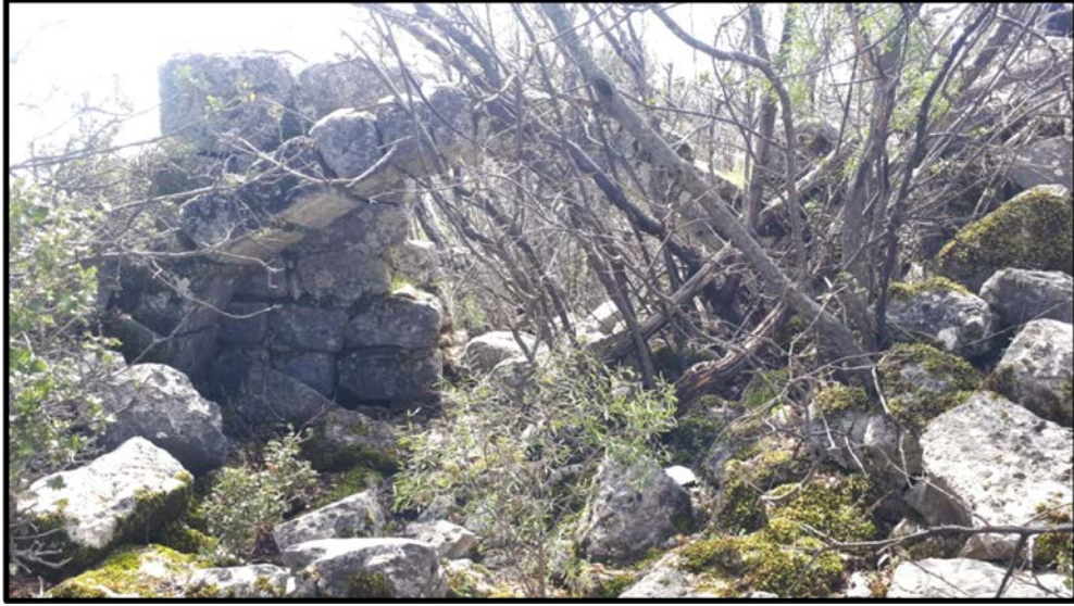
Fotoğraf 51. İkinci Kilise Güney Duvar İzi ve Kemer
