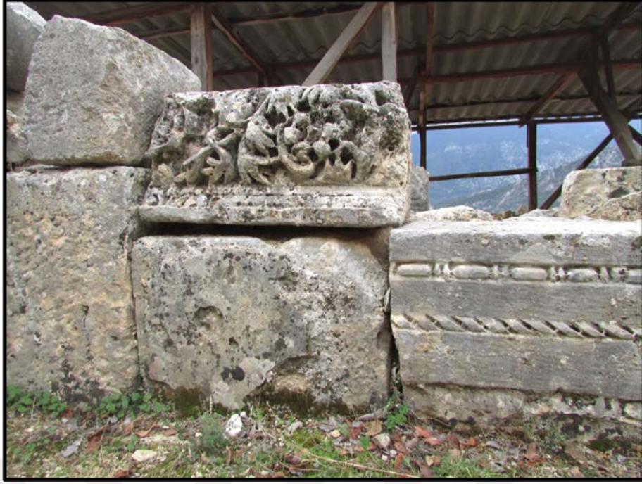
Fotoğraf 25. Geç Dönem Kilisesi Kuzey Beden Duvarında Kullanılan Devşirme Malzemeler
