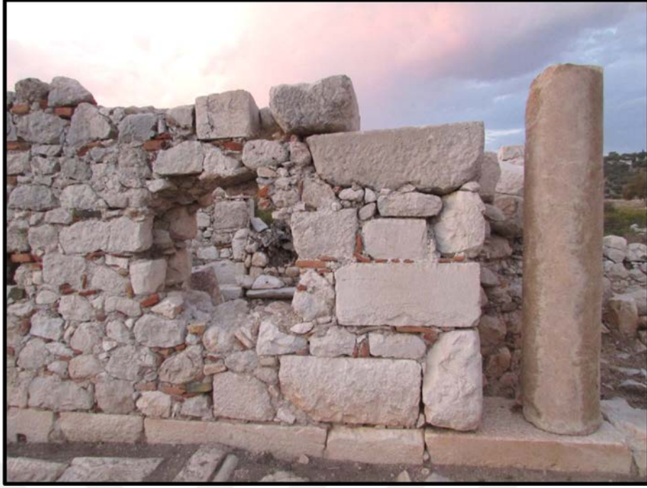
Fotoğraf 71. Patara Kent Bazilikası Şapeli Güney Beden Duvarı ve Erken Kilise Kuzey Stylobatı Detay
