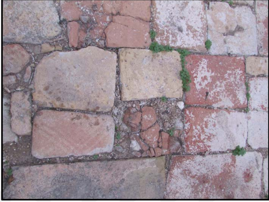
Fotoğraf 91. Şapel Tuğla Zemin Döşemesi
