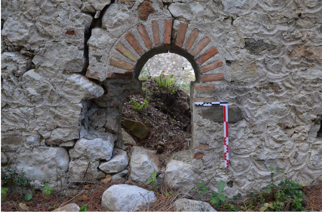
a) Piskoposluk Kilisesi rölik şapeli güney pencere.
