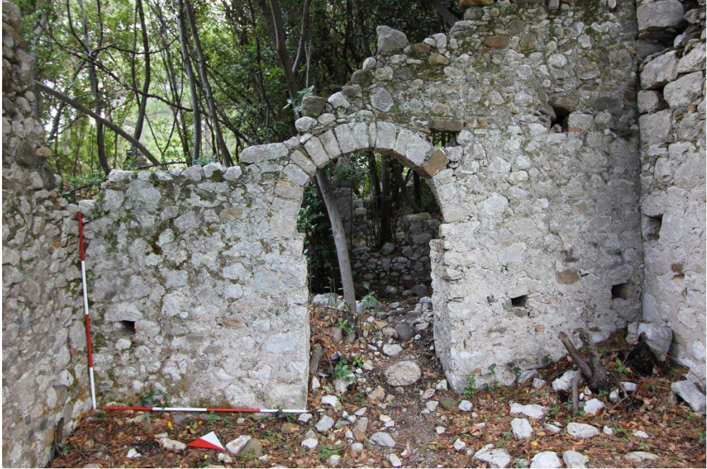
b) Piskoposluk Kilisesi güney ek mekan batı duvardaki kapı açıklığı.
