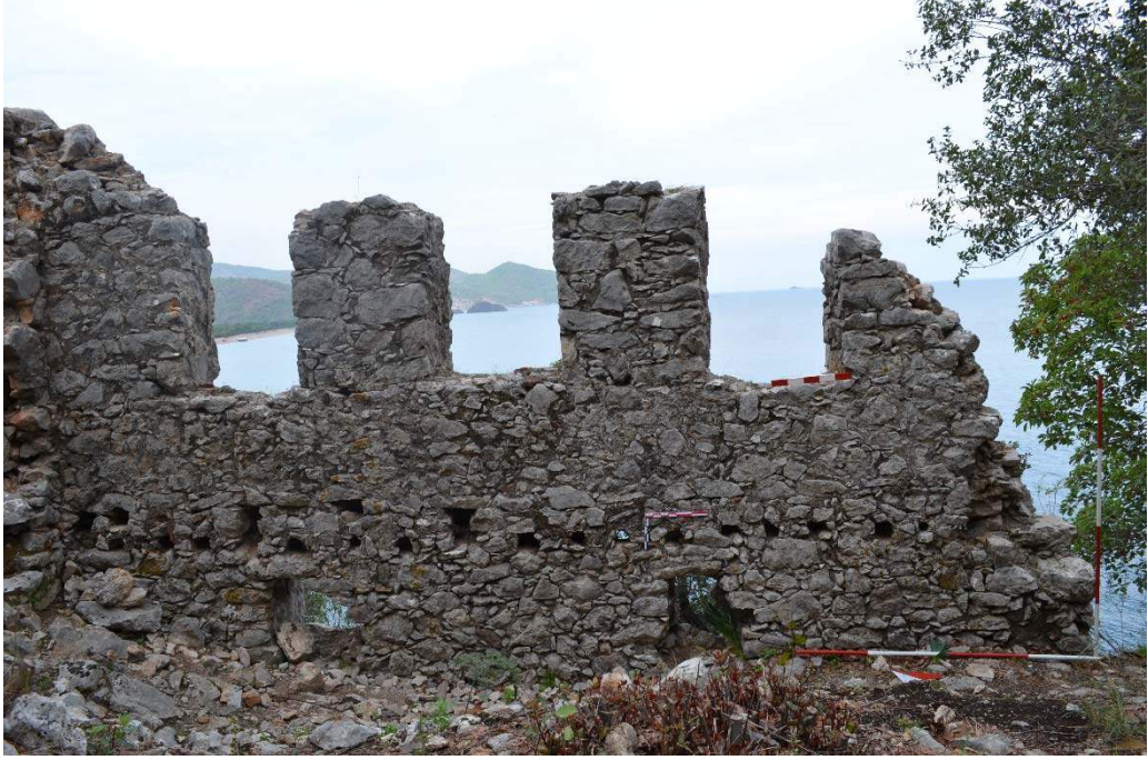
a) Yamaç Yerleşimi Yukarı Kilise kuzey duvar iç cephe.
