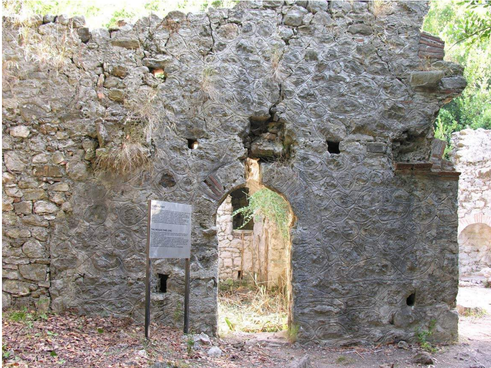
b) Mozaikli Yapı güney duvar dış cephe, dalgalı çizgili derz harcı.
