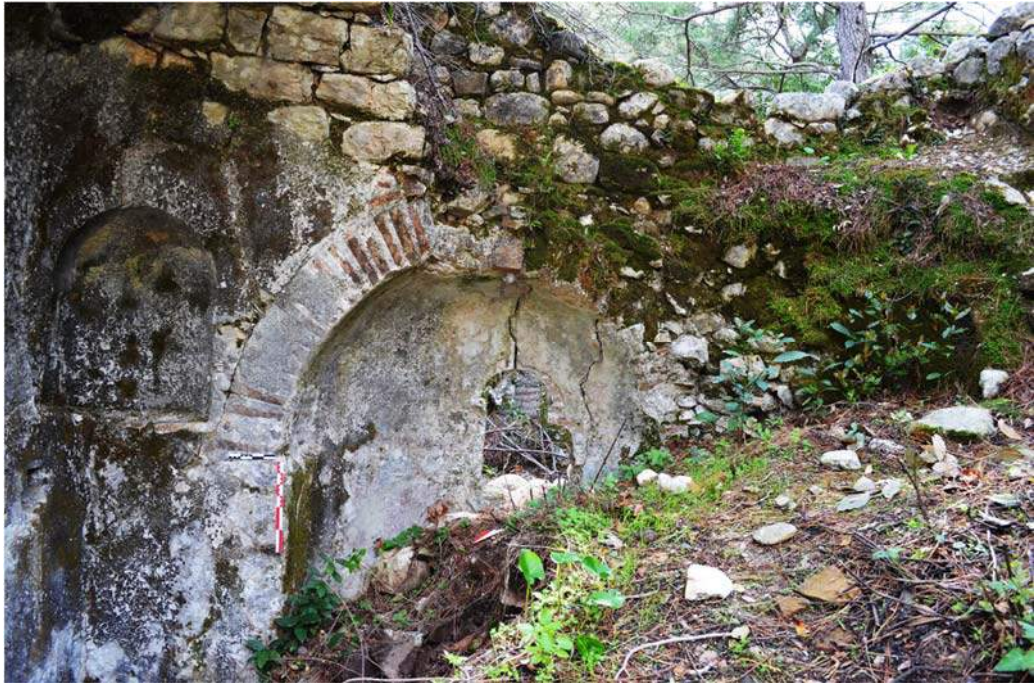
b) Piskoposluk Kilisesi rölik şapeli güney eksedra kemeri.
