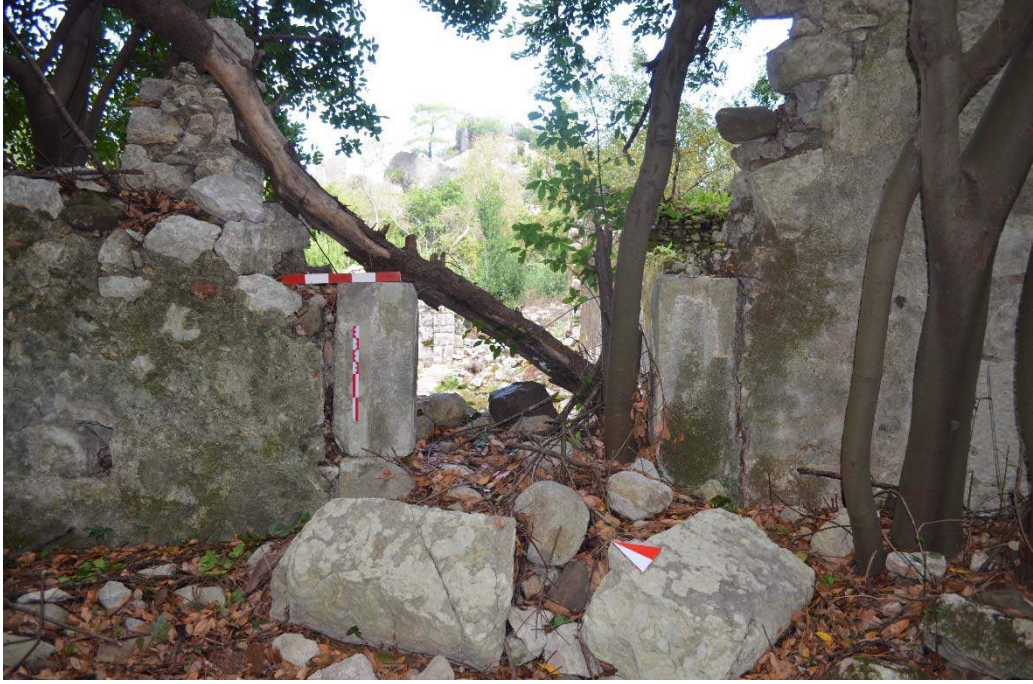
a) Piskoposluk Kilisesi güney nef kapı açıklığı.
