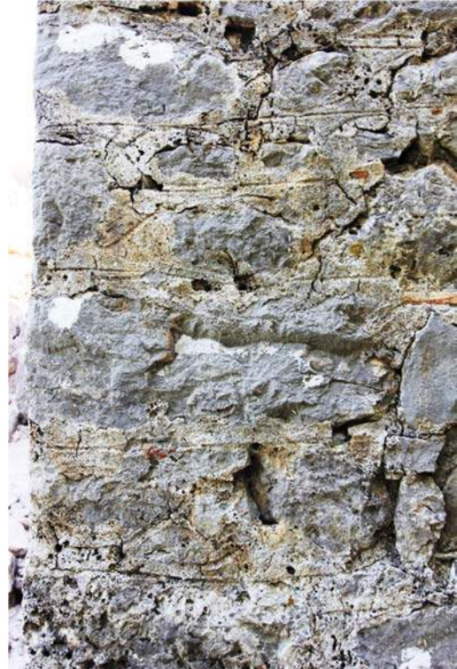
c) Yamaç Yerleşimi Yukarı Kilise batı duvar dalgalı çizgili derz harcı.
