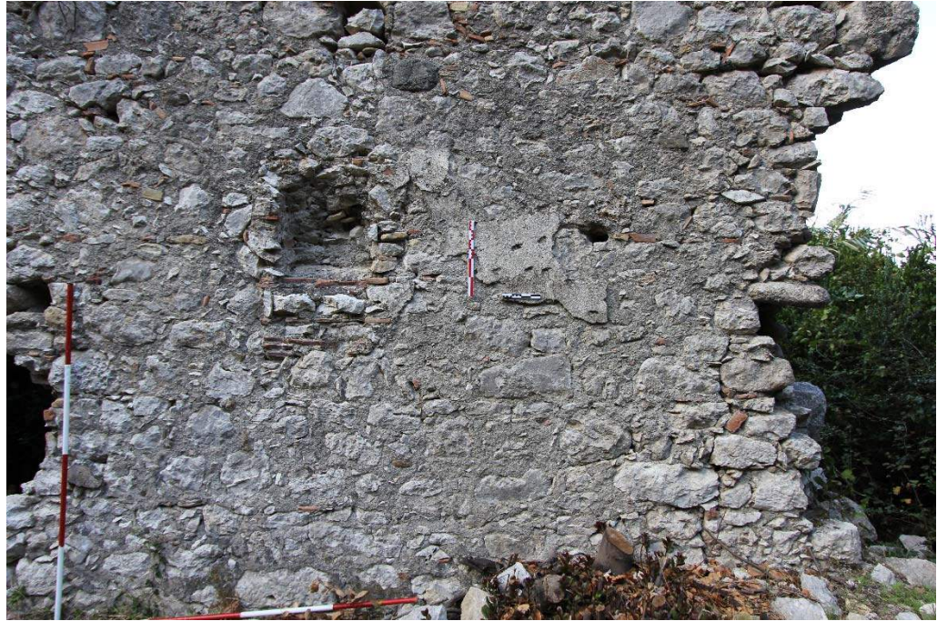
b) Liman Bazilikası kuzey duvar iç cephe, detay.
