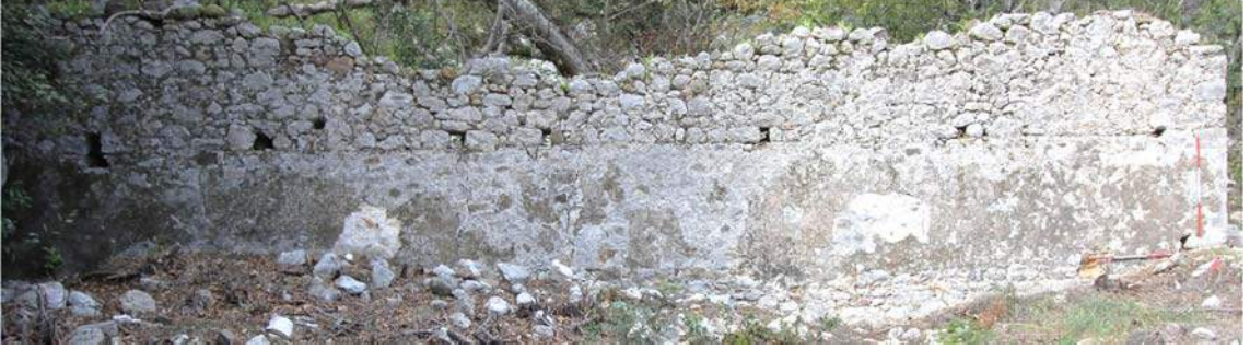
a) Piskoposluk Kilisesi kuzey nef duvarı.
