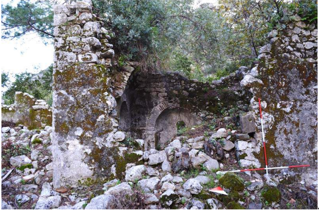
b) Piskoposluk Kilisesi rölük şapeli kapı açıklığı
