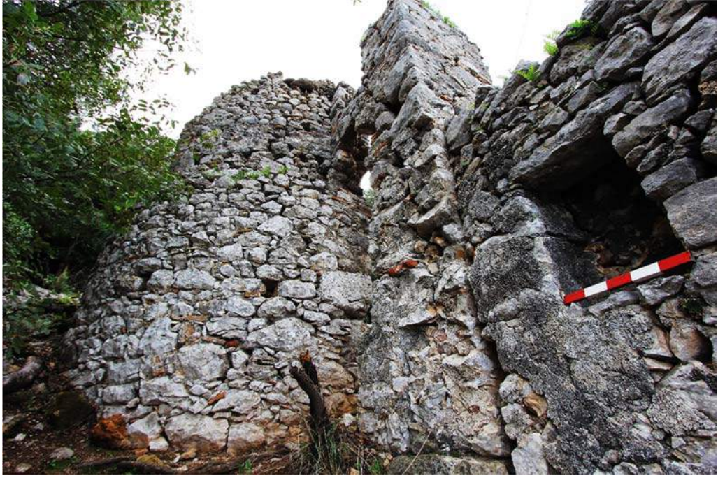
a) Yamaç Yerleşimi Yukarı Kilise kuzey-doğu köşe dilatasyon derzi
