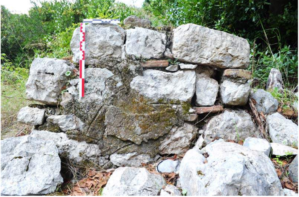
a) Liman Bazilikası kuzey ek mekan güney duvar, dalgalı çizgili derz harcı ve sıva tabakası.
