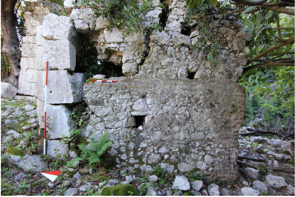
a) Liman Bazilikası güney nef dođu duvar.
