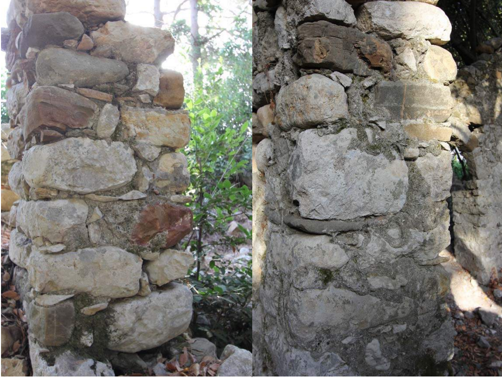
a) Piskoposluk Kilisesi güney ek mekan güney pencere örgüsü.
