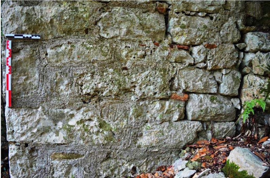
b) Yamaç Yerleşimi Aşağı Kilise dış cephe derz harcı üzerinde kesme taş imitasyonu.
