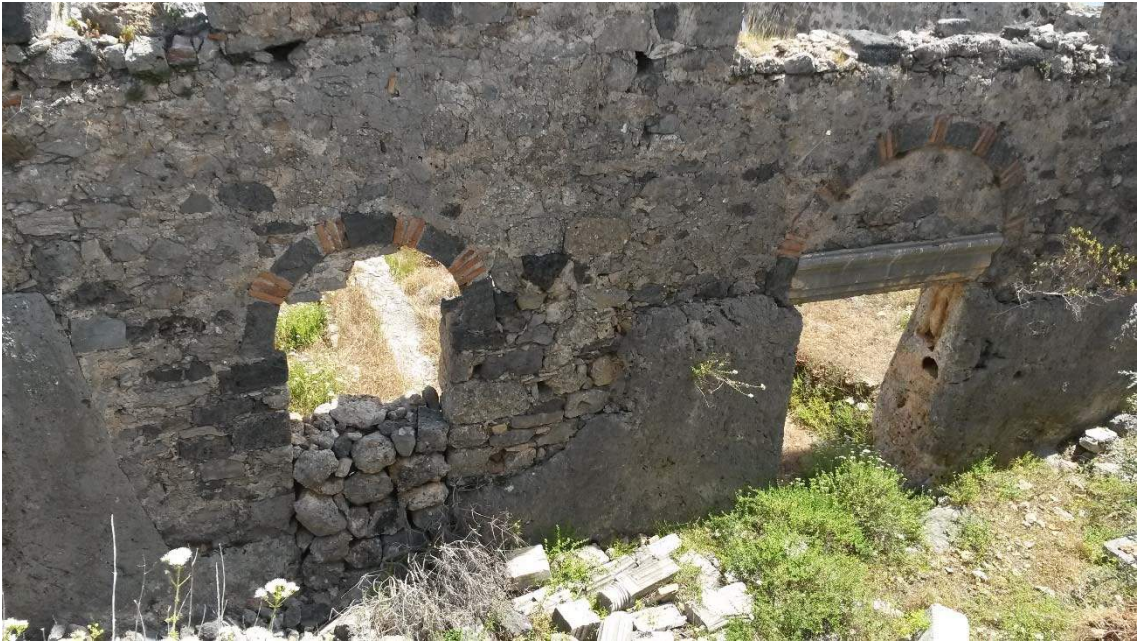
b) Gemiler Ada III no'lu Kilise naos batı duvar, dış cephe.
