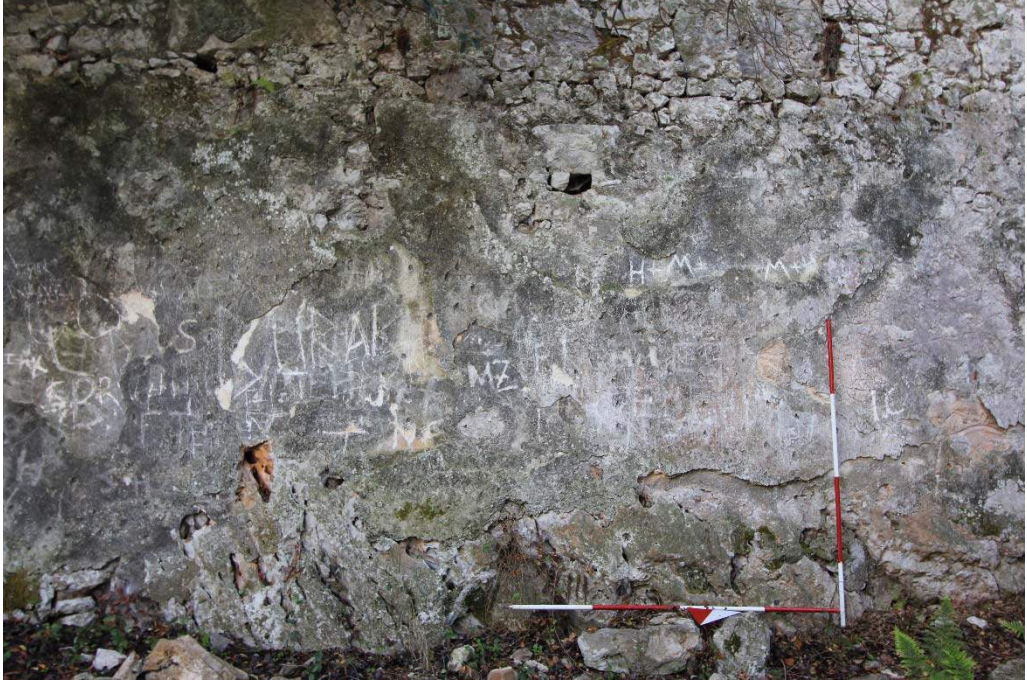
a)Yamaç Yerleşimi Aşağı Kilise güney duvar iç cephe.
