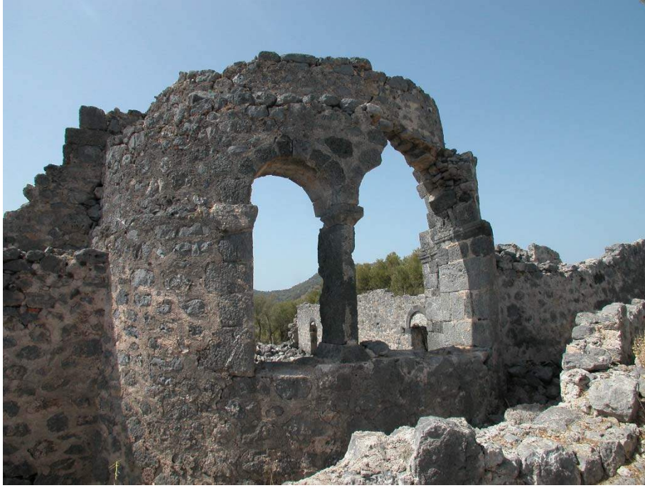
a) Karacaören Ada Bazilikası apsis duvarı dış cephe, dalgalı çizgili derz harcı.
