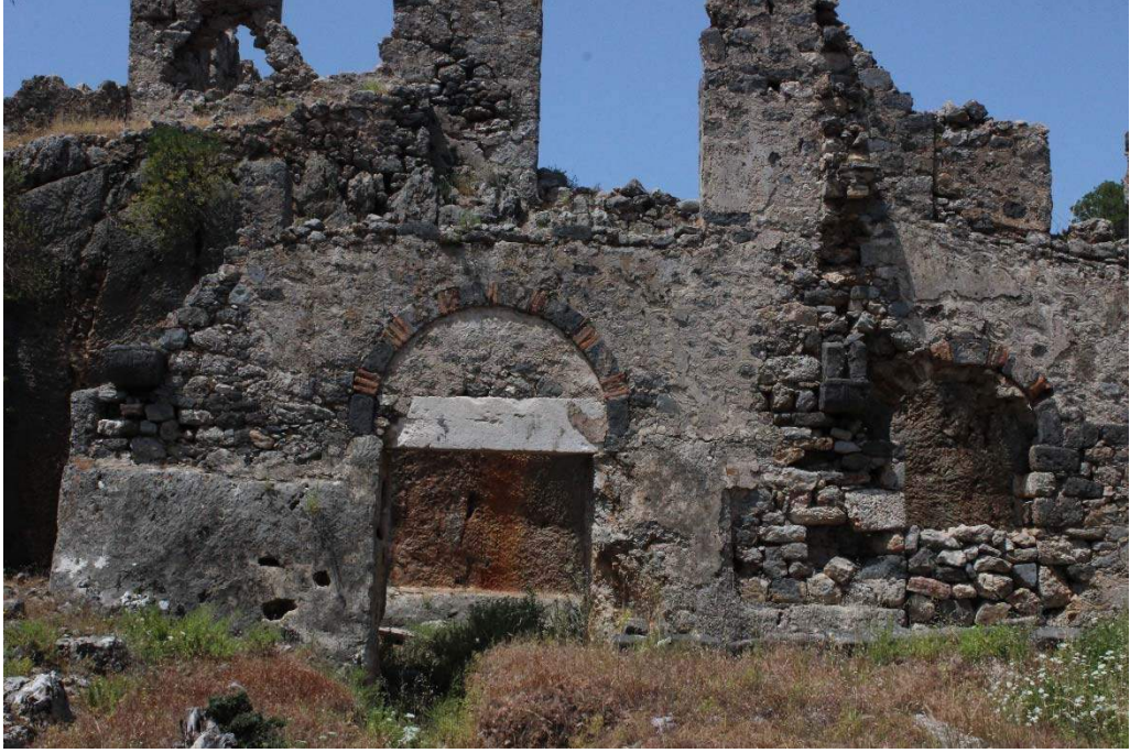
a) Gemiler Ada III no'lu Kilise naos batı duvar, iç cephe, dalgalı çizgili derz harcı.
