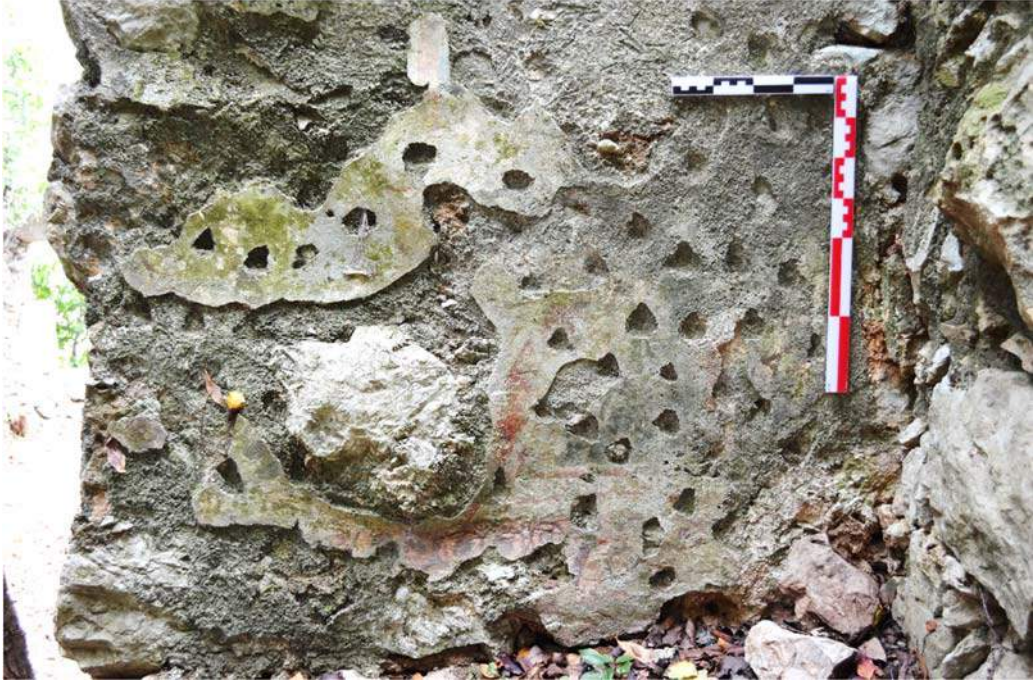
a) Yamaç Yerleşimi Aşağı Kilise güney ek mekan kuzey cephe duvar resmi üzerindeki murç izleri.
