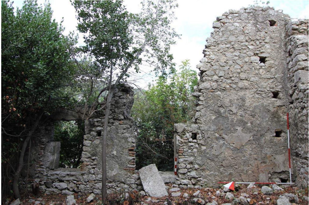
b)Yamaç Yerleşimi Aşağı Kilise kuzey duvar iç cephe.
