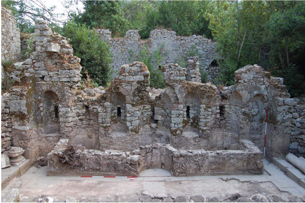
b) Episkopeion, Peristyl çeşme duvarı batıya bakış.
