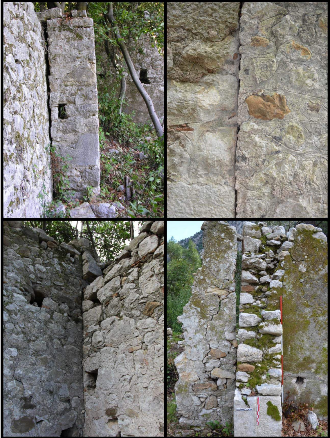
a) Piskoposluk Kilisesi dilatasyon derzi uygulaması.
