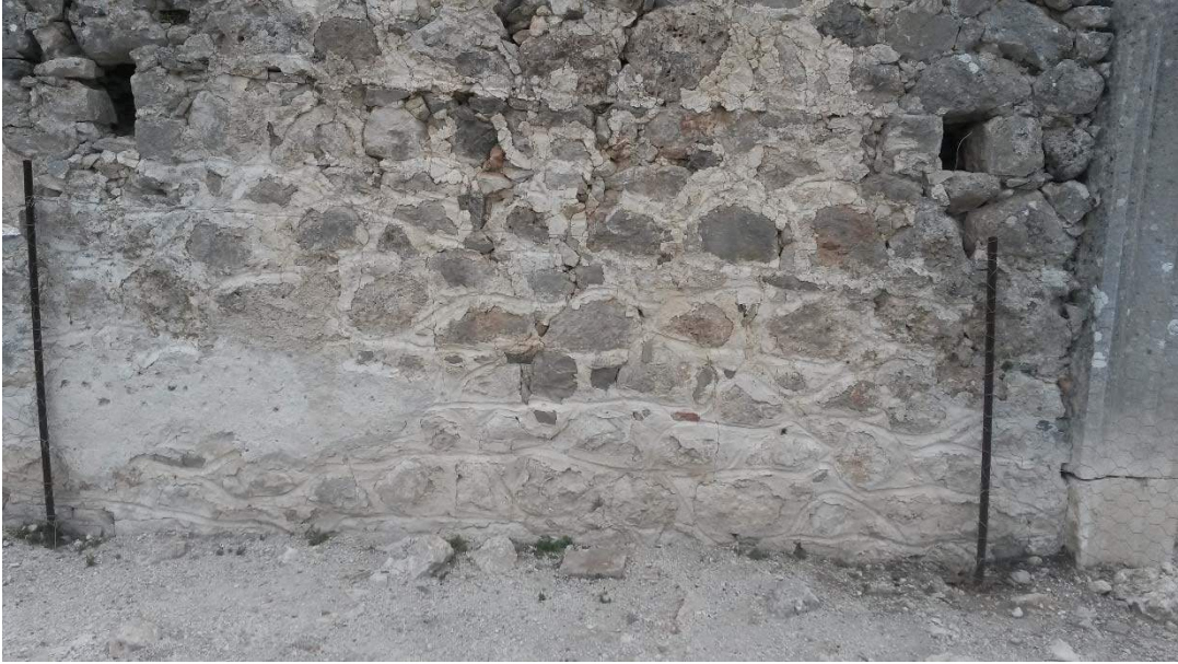
b) Tlos Kent Bazilikası, dalgalı çizgili derz harcı.
