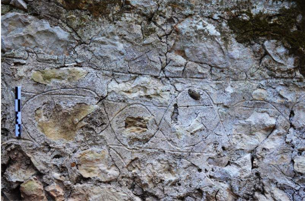
b) Vaftizhane dalgalı çizgili derz harcı detayı.
