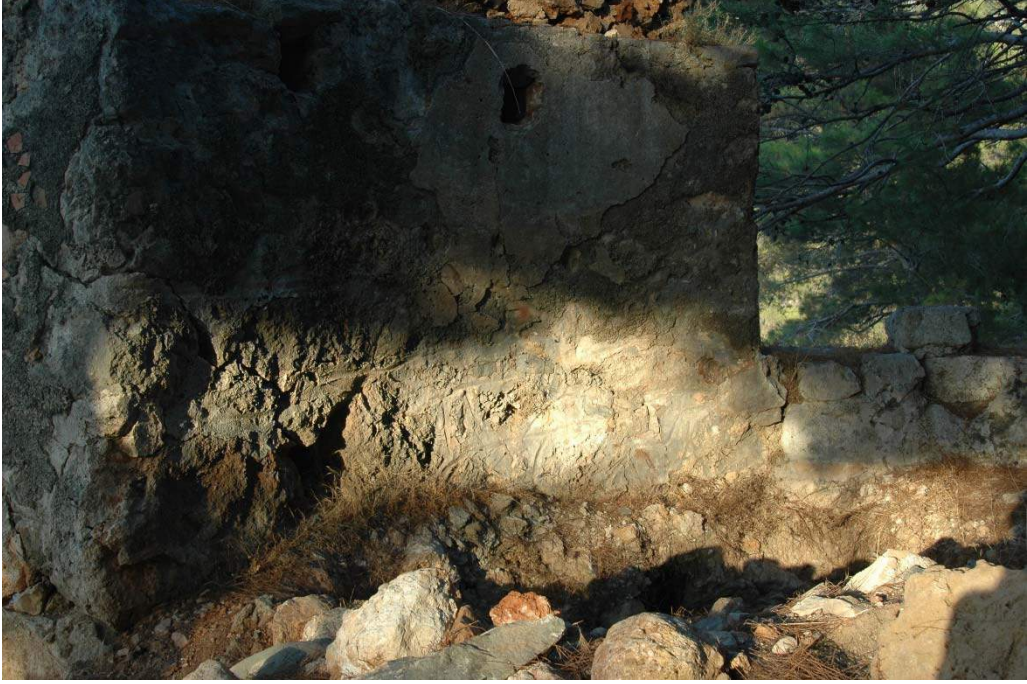
a) Melanippe Sahil Kilisesi apsis duvarı, iç cephe dalgalı çizgili derz harcı.
