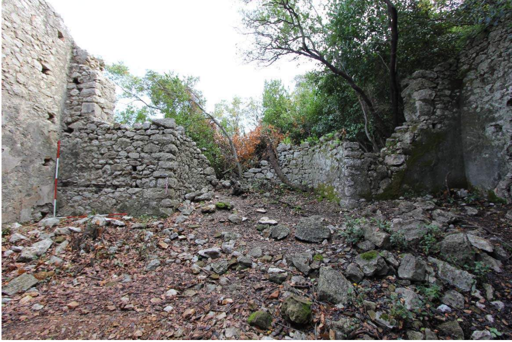
a) Yamaç Yerleşimi Aşağı Kilise apsis cephesi.
