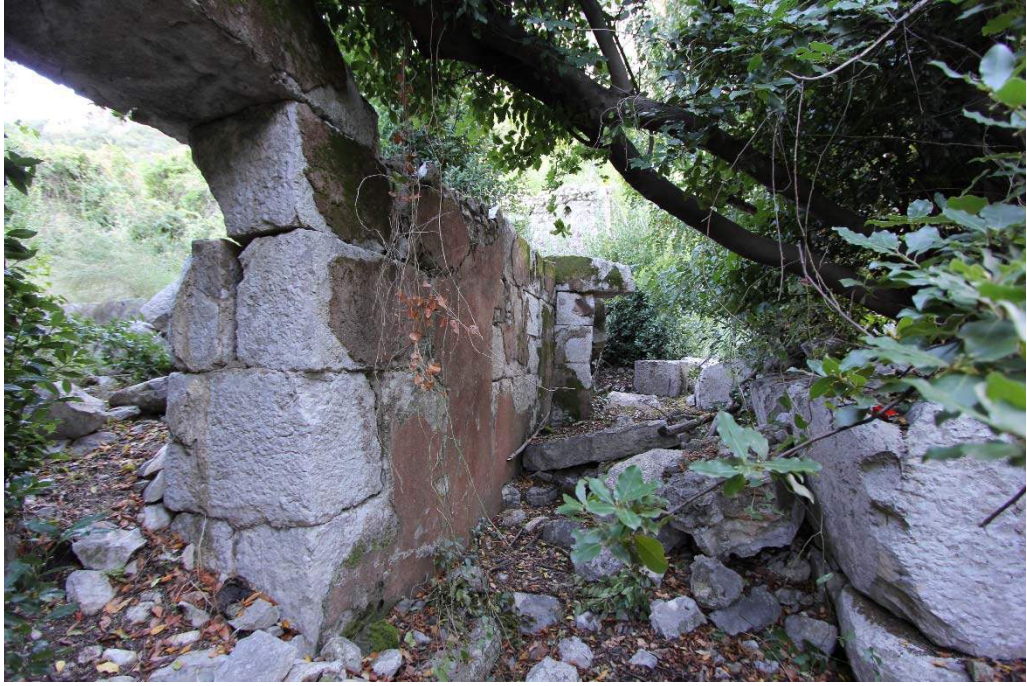
a) Olympos Güney Kent, Liman Hamamı batı duvar, dış cephe, güneye bakış.
