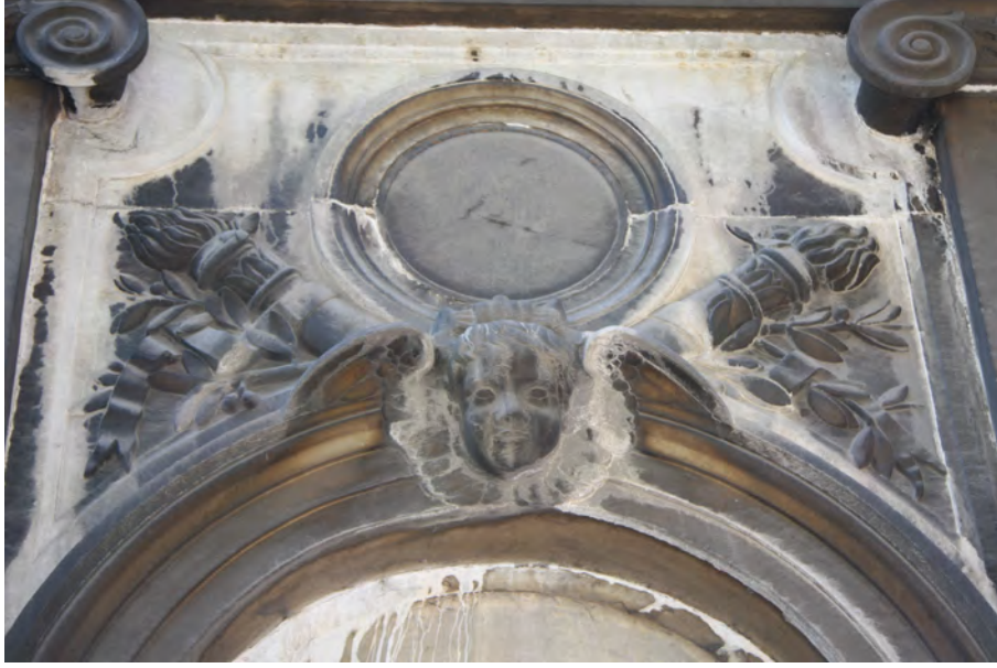
Resim 595. Corpi Ailesi Mezar Şapeli (Kat.170) melek kabartmaları
