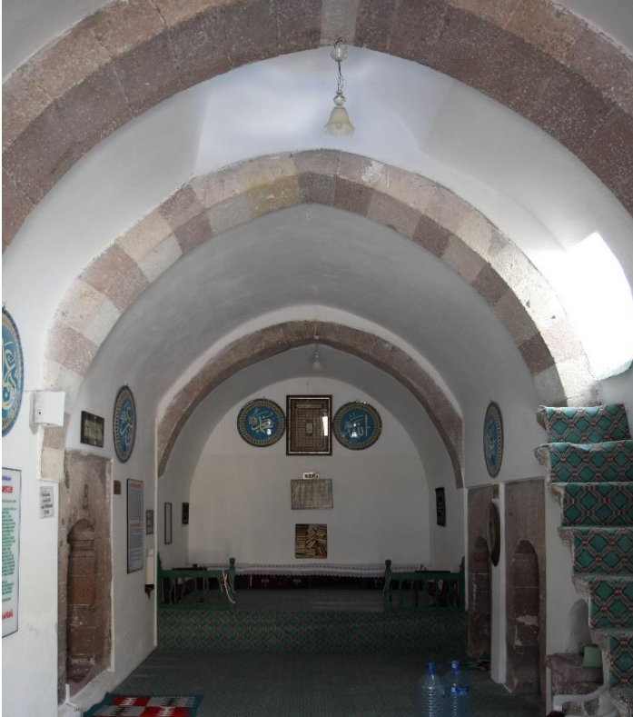
Resim 69. Şeyh Turesan Zaviyesi Sofa Tonozu Ve Takviye Kemerleri
