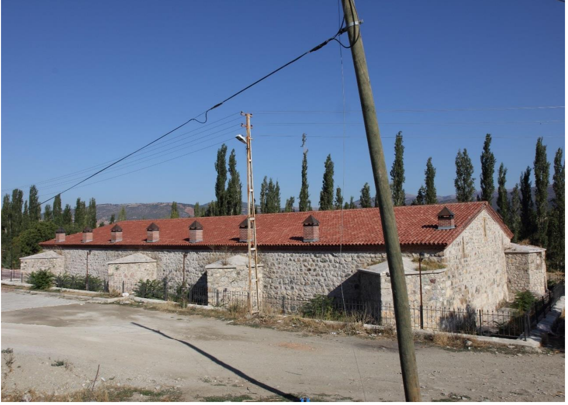
Resim 94. Ezinepazar Hanı Kuzey Cephe
