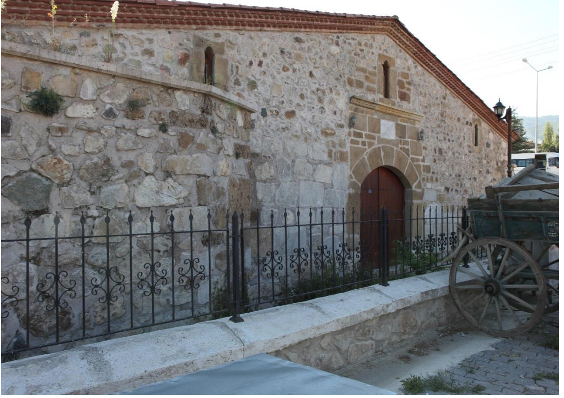
Resim 92. Ezinepazar Hanı Doğu Giriş Cephesi
