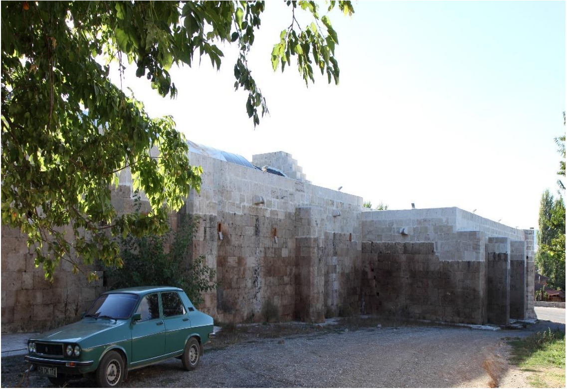
Resim 82. Mahperi Hatun Hanı Kuzeydoğu Cephe Ve Payandaları
