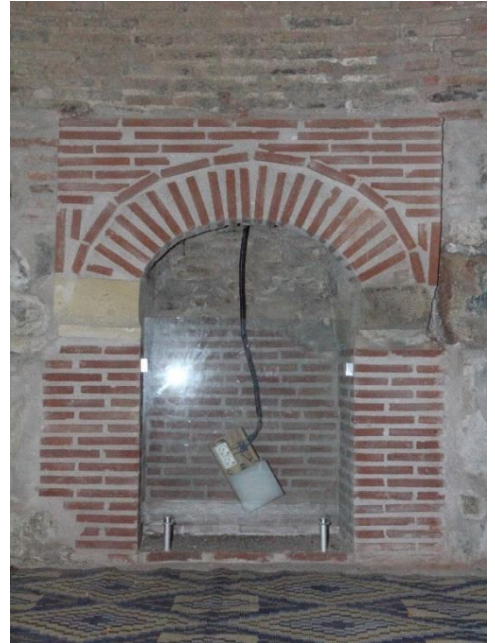
Resim 100. Ezinepazar Hanı Kuzey Duvarı Ocak Nişi Detayı
