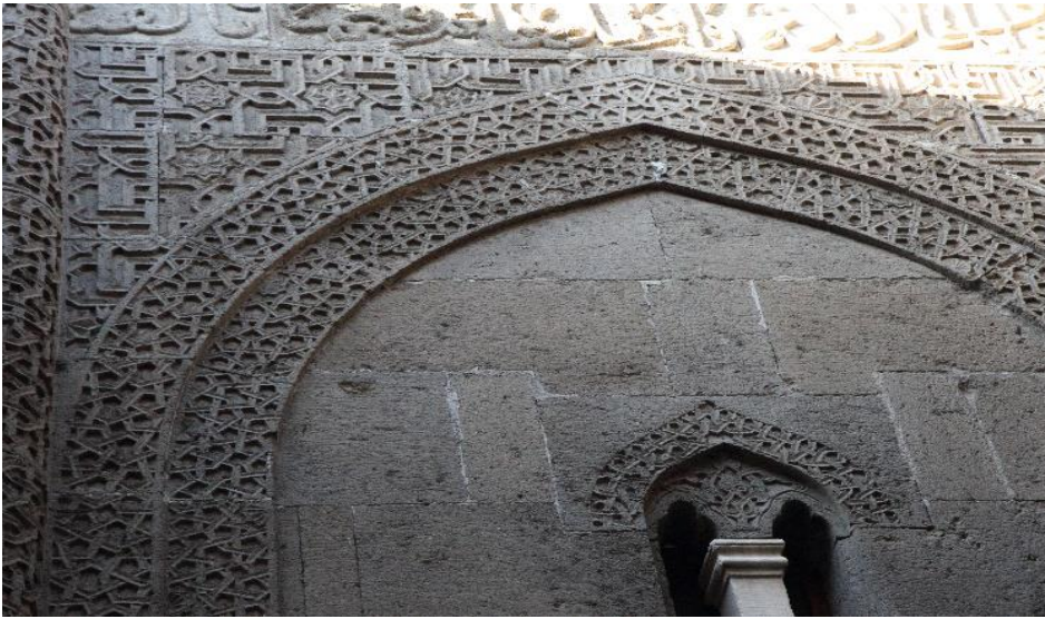
Resim 40. Mahperi Huand Hatun Türbesi Kuzeydođu Cephe Üst Kısım
