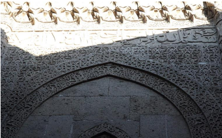
Resim 37. Mahperi Huand Hatun Türbesi Güneydoğu Cephe Üst Kısım
