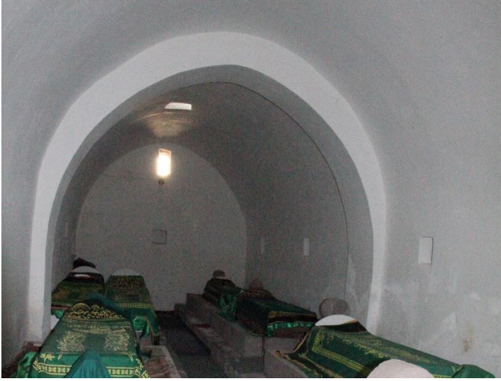
Resim 71. Şeyh Turesan Zaviyesi Türbe (Han) Mekanı Tonozu Ve Takviye Kemerleri
