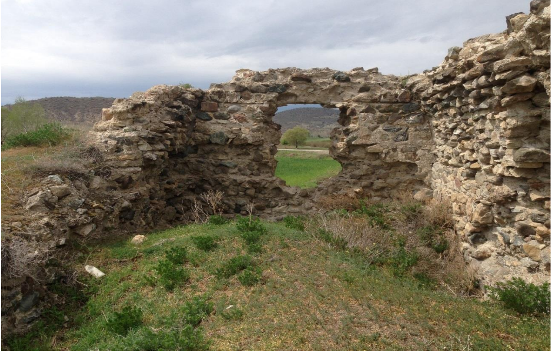
Resim 114. Çekereksu Hanı İç Mekan Duvar Kalıntıları Ve Tonoz Başlangıcı
