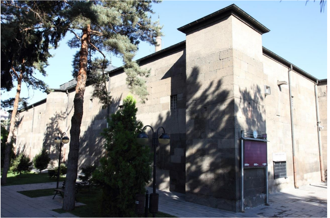
Resim 18. Mahperi Huand Hatun Camii Güneydoğu Köşe Payandası
