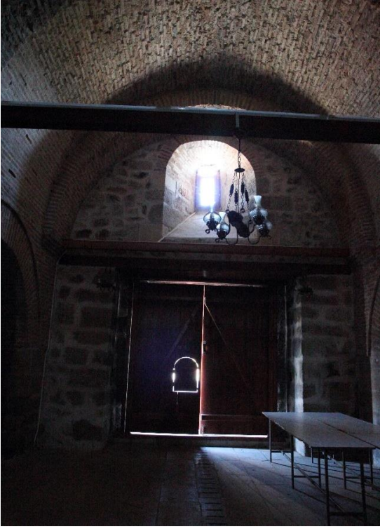
Resim 101. Ezişehir Hanı Orta Sahın, Giriş Orta Kapısı Üstündeki Mazgal Pencere
