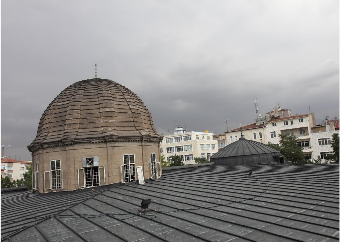
Resim 26. Mahperi Huand Hatun Camii Çatısı
