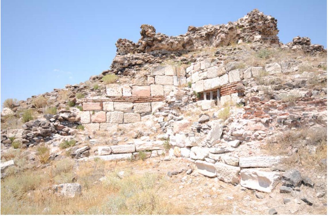
Resim 59. Giriş Cephesi Güney Burç 2014
