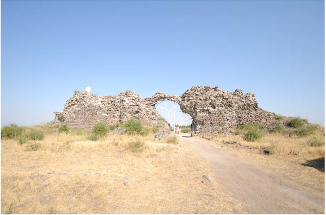
Resim 58. Giriş Duvarı İç Yüzü 2014
