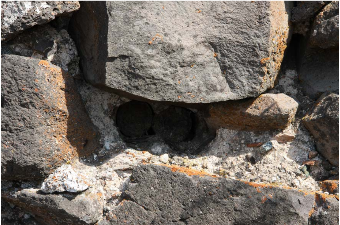
Resim 50. Kalenin Batı Yönü Sur Duvarındaki Ahşap Hatıllar 2014
