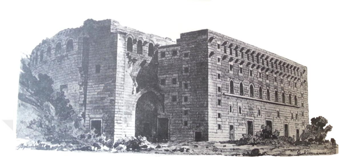
Resim 5: Aspendos Tiyatrosu Sahne Binası'nın Arkasındaki Konsollar.
