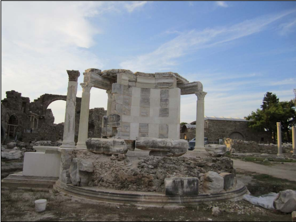
2. Tykhe Tapınağı Ayağa Kaldırma Uygulaması
