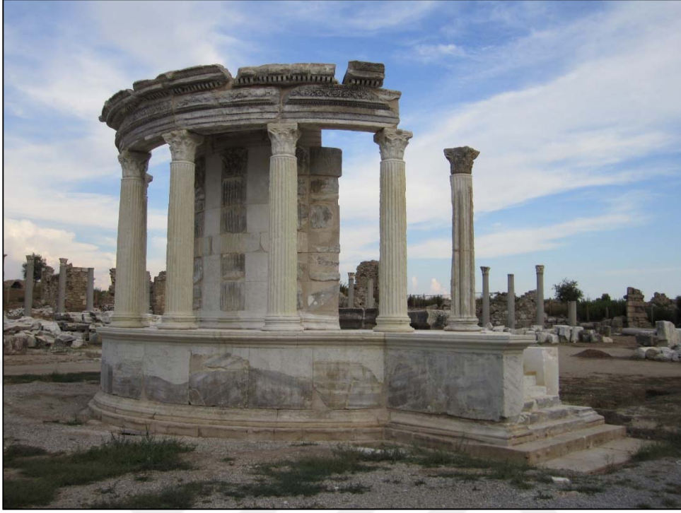
1. Tykhe Tapınağı Ayağa Kaldırma Uygulaması
