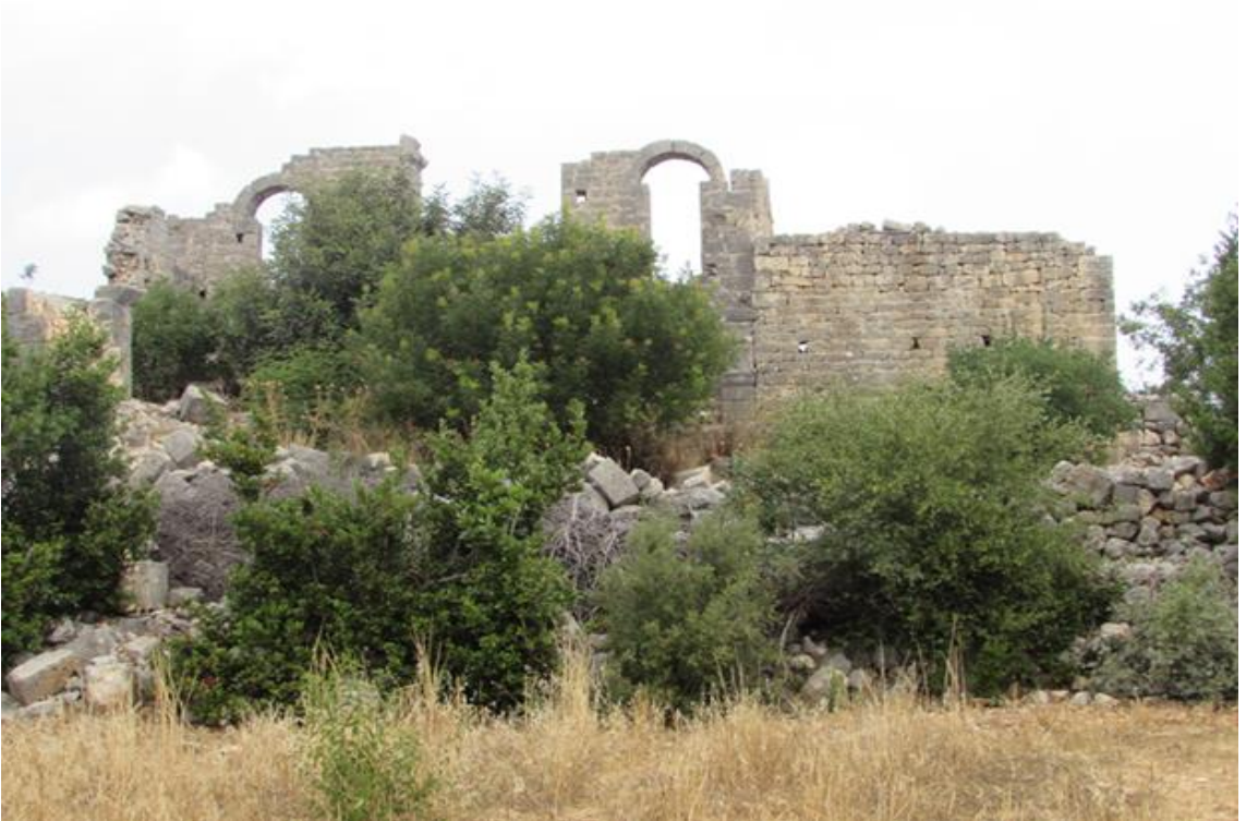
Resim 23. Işıkkale Kilisesi Batı Cepheden Genel Görünüş
