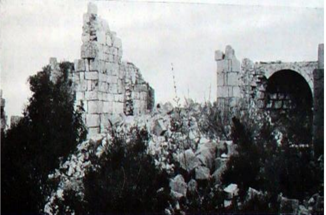
Resim 31. Korykos G (Transeptli Kilise) Kilisesi Genel Görünüş (E. Herzfeld - S.Guyer 1930)
