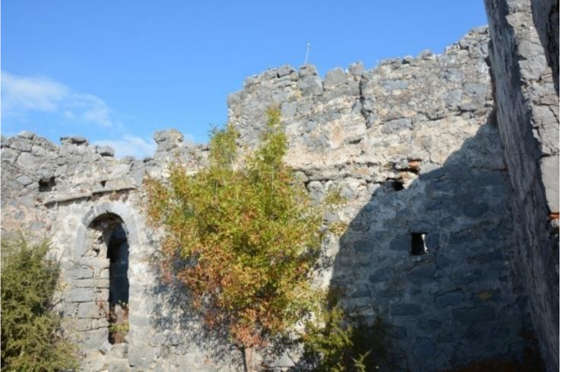
Resim 72. Karacaören Bazilikası Vaftizhanesi, Güneybatı duvar ve olası su sistemi
