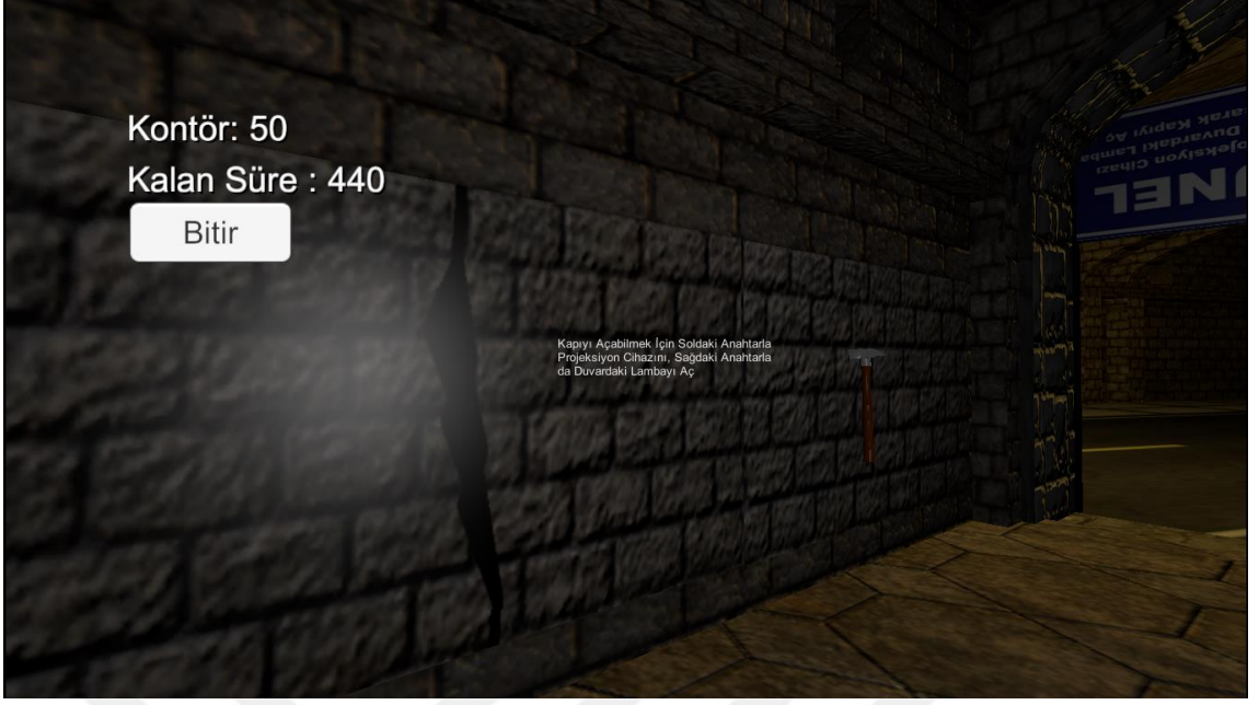
Görsel 2.12. Depremde çatlayan duvar
