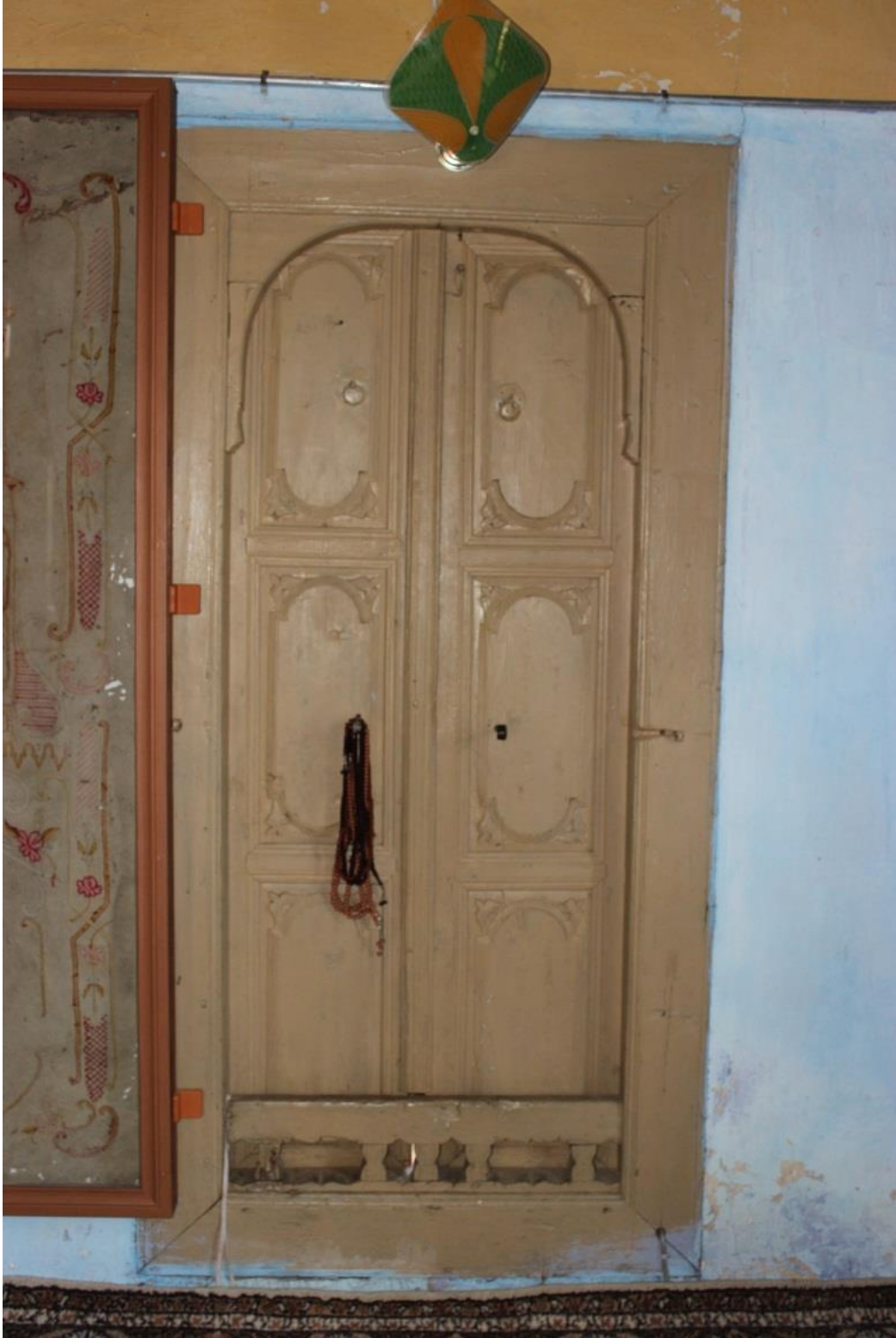
Fotoğraf 3. 191 Sarıhaçlar Köyü Camisi doğu duvarının güney yönünde yer alan pencere
