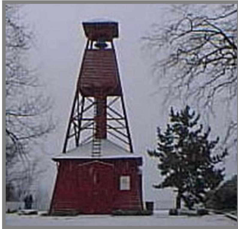
Resim 20: Yangın Çan Kulesi Washington
