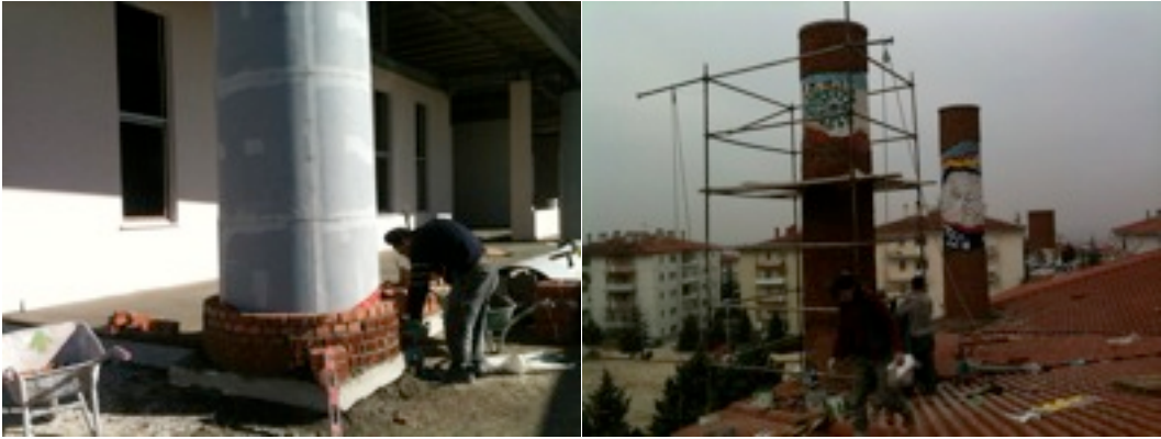
Görsel 99. Müze binası bacalarının inşasından görüntü.
