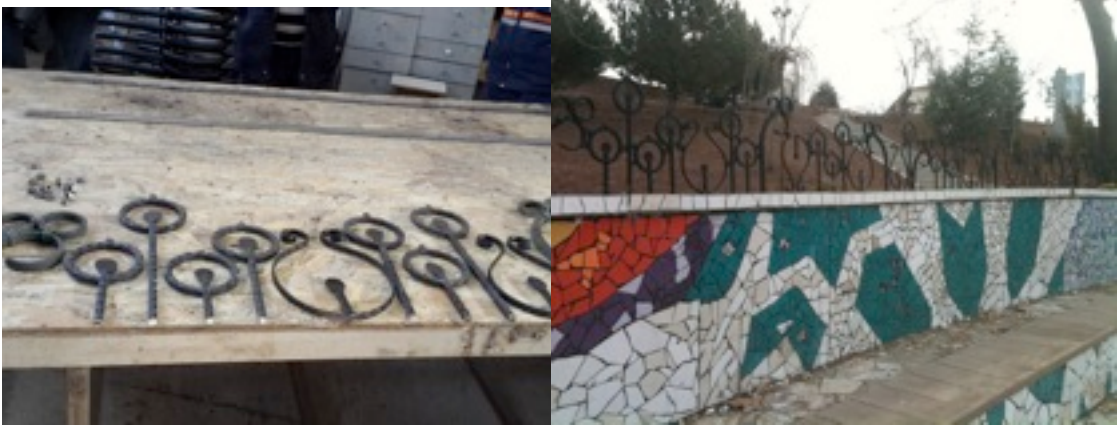
Görsel 96. Ferforje korkulukların tamamlanması.
