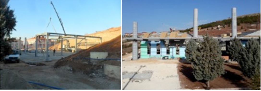
Görsel 98. Müze binasının inşa çalışmalarından görüntü.
