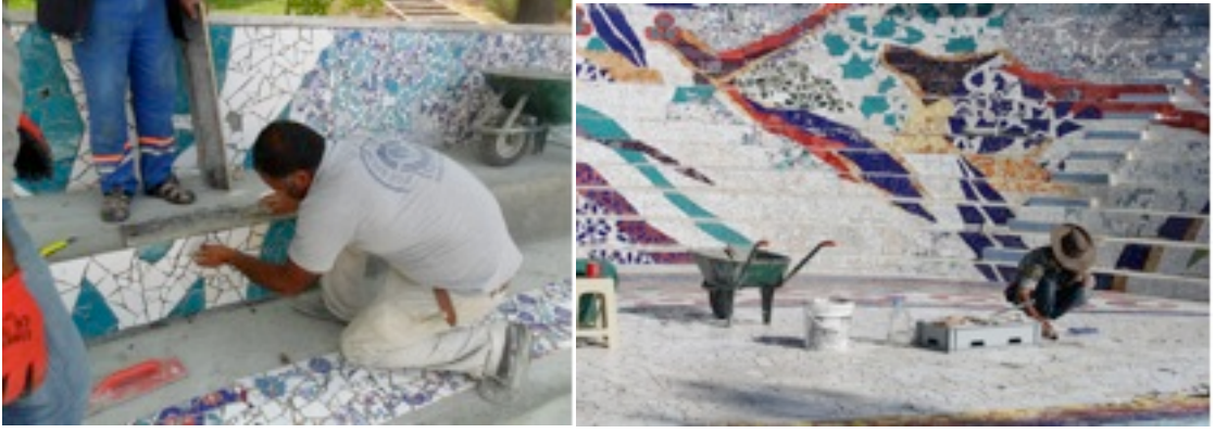
Görsel 94. Amfinin derz dolgusunun yapılması.
