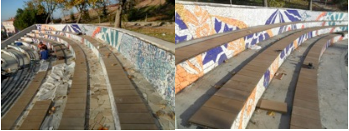
Görsel 95. Oturma elemanlarının yerleştirilmesi
