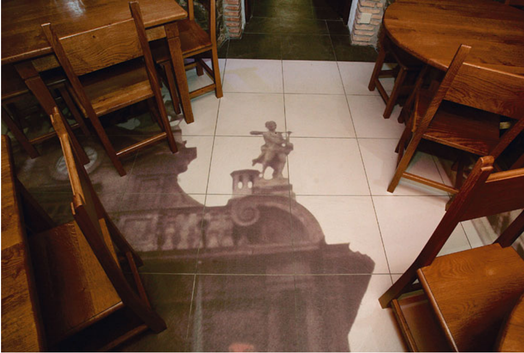
Grsel 2.24. La Mandarra de la Ramos restoranı zemin detayı; inkjet teknolojisiyle baskı uygulaması yapılmıř karo dřemesi, Pamplona ispanya
