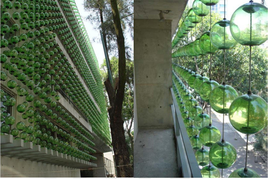
Görsel 2.9. Herve Diseñería, tamamı üfleme birimlerden oluşturulmuş cam cephe örneği Mexico City
