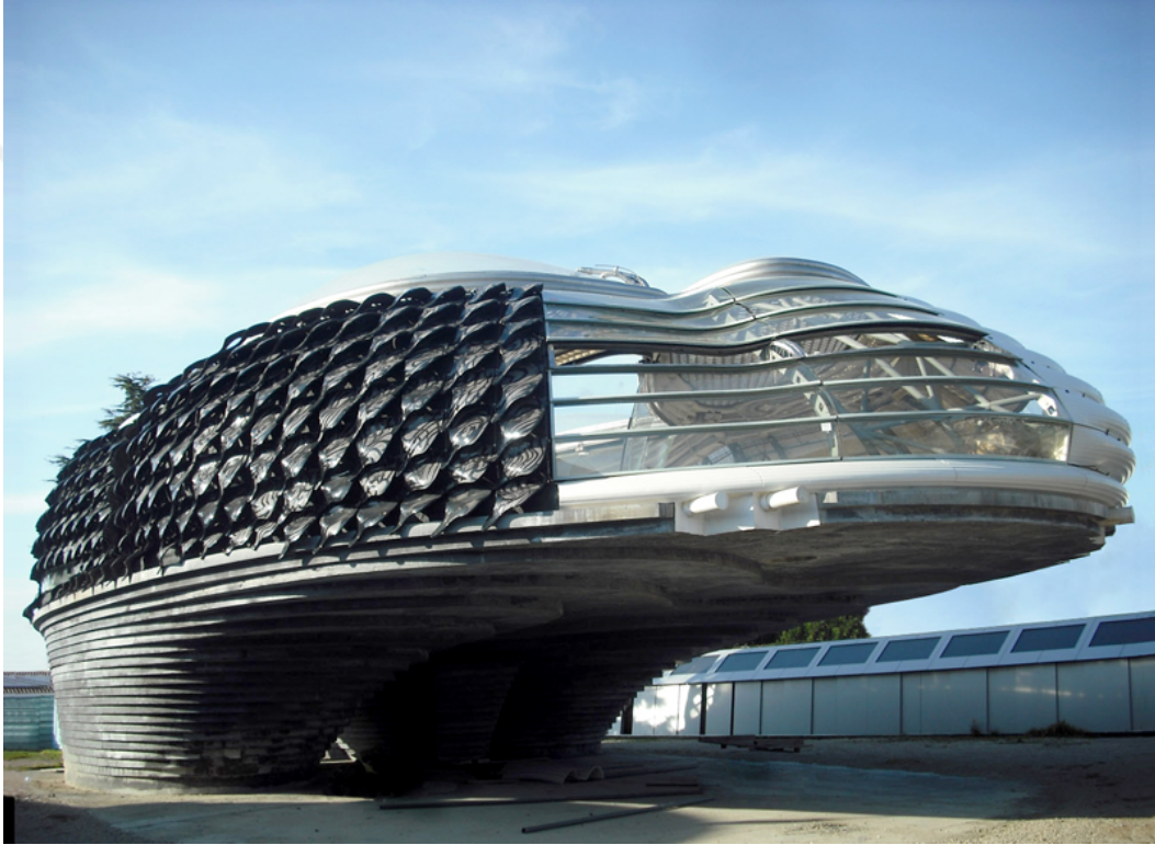
Görsel 2.28. Villa Nurbs cephe görüntüsü,2009,İspanya
