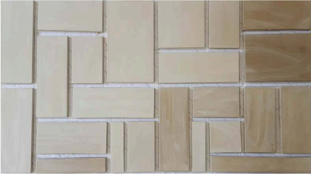
Görsel 3.13. Tasarıma uygun şekilde kesilen farklı ebatlarda ve 1cm et kalınlığına sahip plakalar
