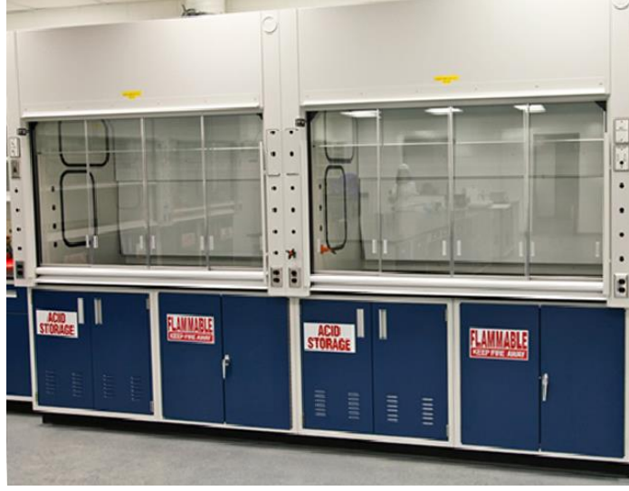
Görsel 2.46. Asitle çalışmak için çekerocek havalandırma sistemleri
