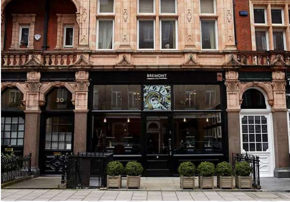
Görsel 3.35. Bremont mağazası cephe görüntüsü (http-54)
