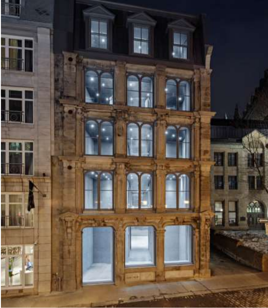
Görsel 3.40. Ssense cephe görüntüsü (http-56)
