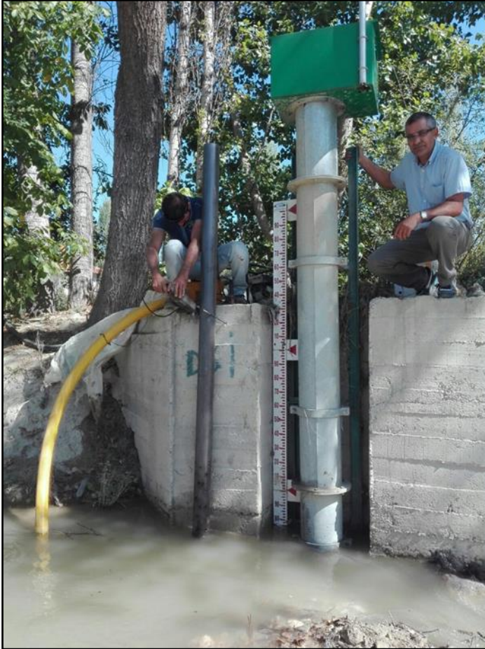
Fotoğraf 3.2 Daldırma Tip Seviye Sensörünün Kontrol Kesite Kurulum ve Sabitlenme Aşaması
