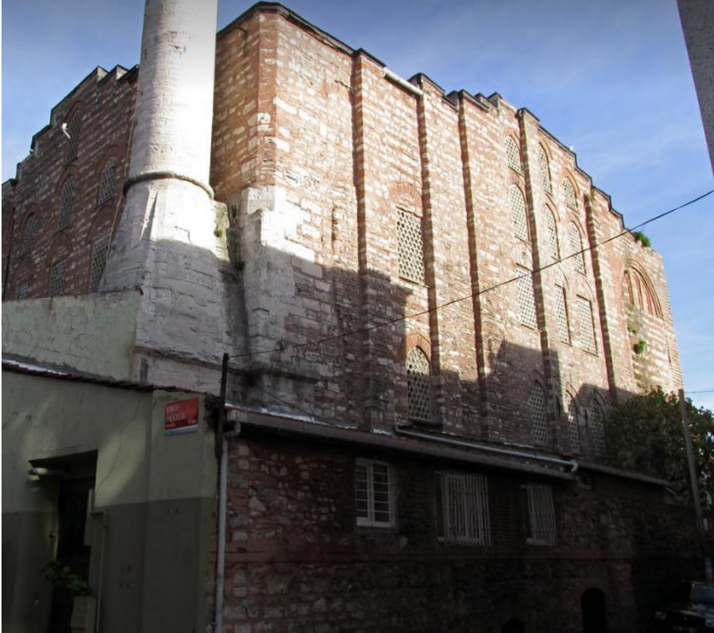
Levha 39.b Khristos Evergetis Manastırı Kilisesi Güney Cephe
