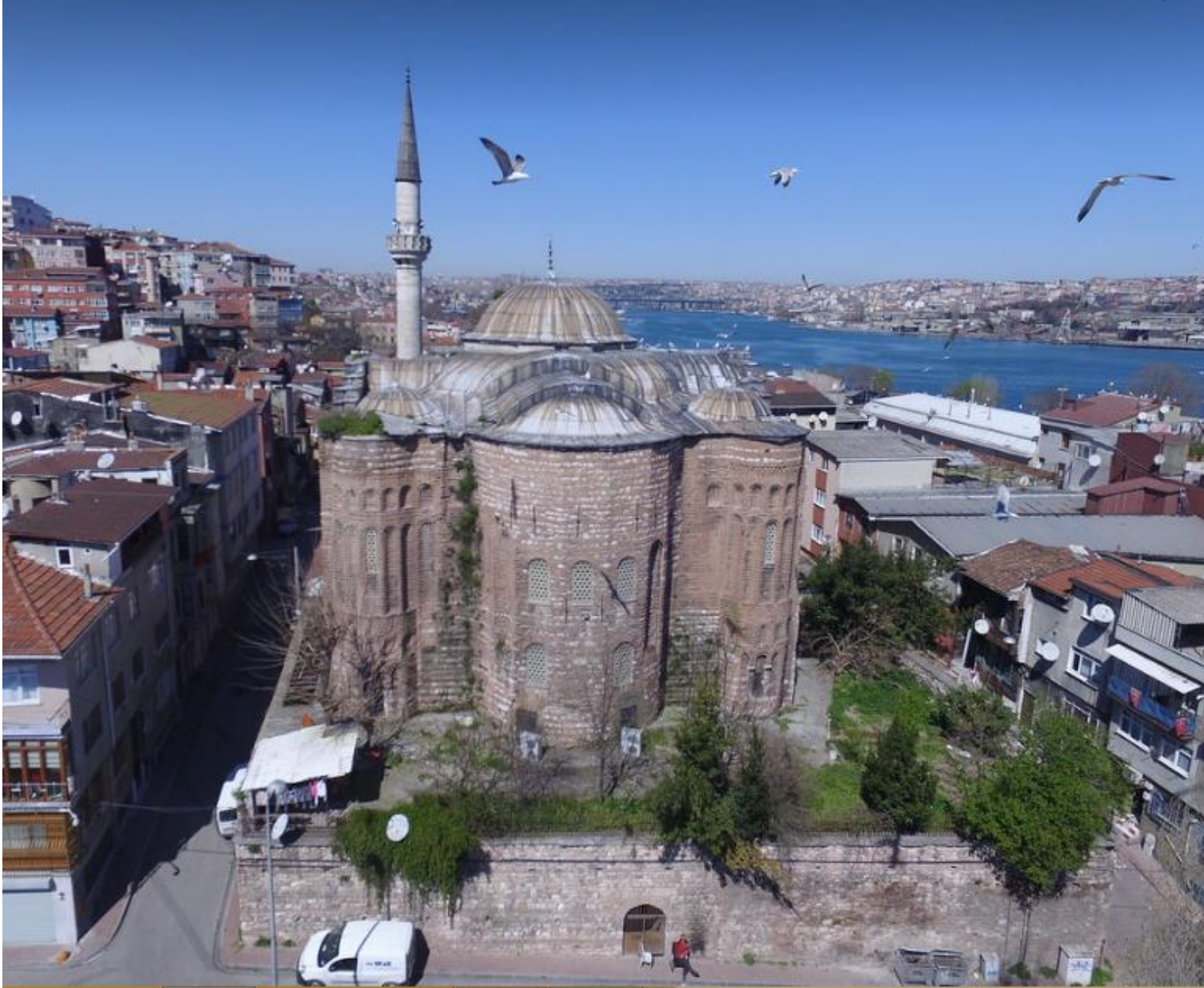
Levha 38.a Khristos Evergetis Manastırı Kilisesi Doğu Cephe
