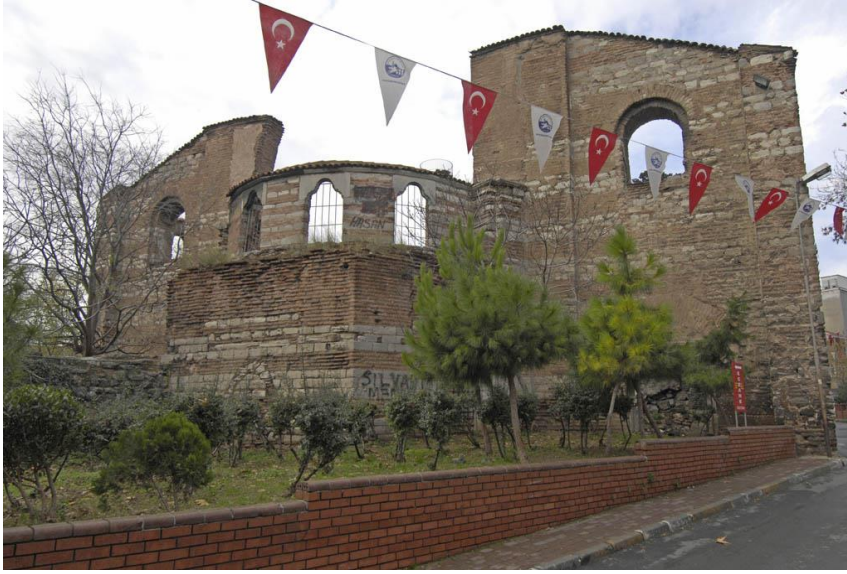
Levha 50 Aziz Ioannes Stoudios Manastır Kilisesi Doğu Cephe
