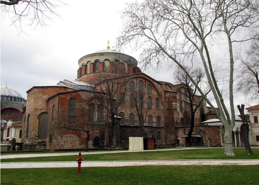
Levha 51.c Aya İrini Kilisesi Kuzeyden Görünüm
