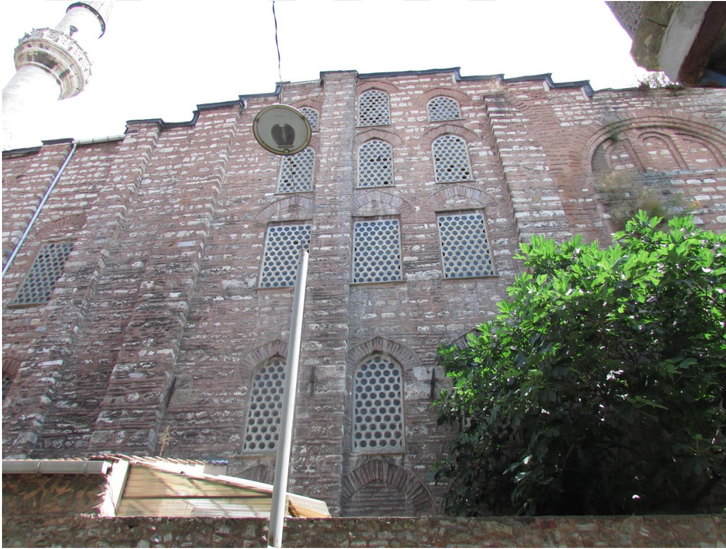
Levha 39.c Khristos Evergetis Manastırı Kilisesi Güney Cephe
