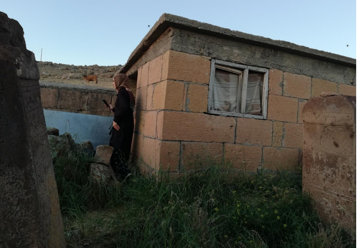
Fotoğraf 8 3.5.1.9. Numaralı Efsanede Bahsi Geçen Aynü'l- Melek'in Türbesi
