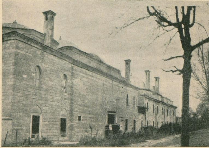
Şekil: 23 — Fatih Tabhane medresesi belediye tarafından benzin ve malzeme deposu olarak kullanılmaktadır. Binaın yan cephe duvarına yeniden bir kapı açılmak suretiyle de duvar tahribedilmiştir.
