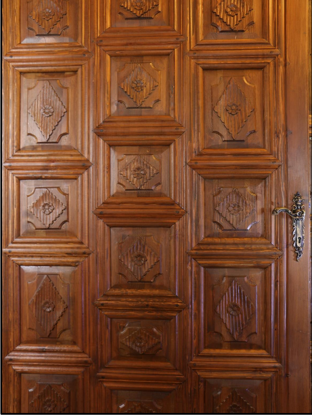
Resim- 16 Giriş kat (Z02 numaralı) oda kapısı.
