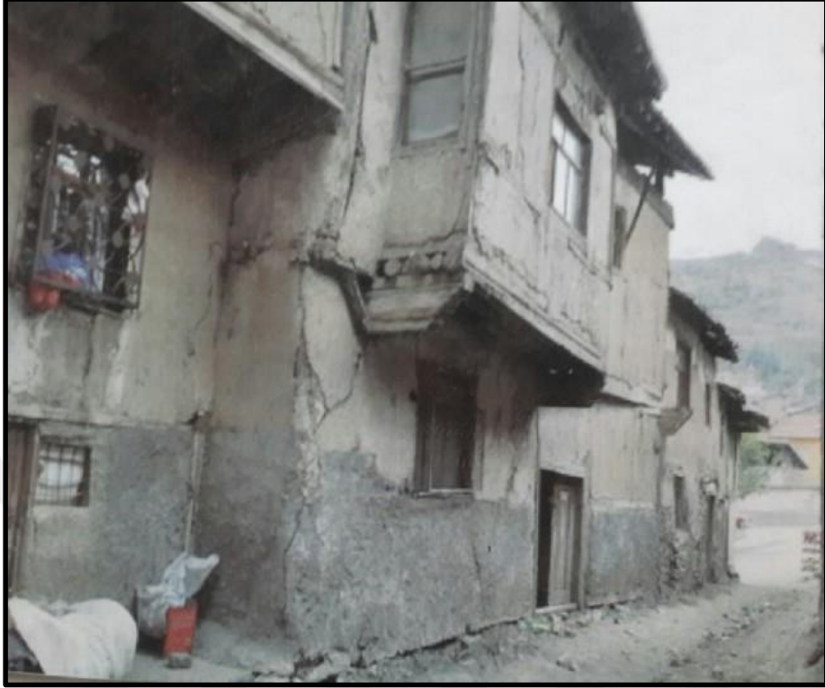
Resim- 2 Kltr Evi n cephe ve sokaktan ekilmiŖ baŖka bir grnm.
