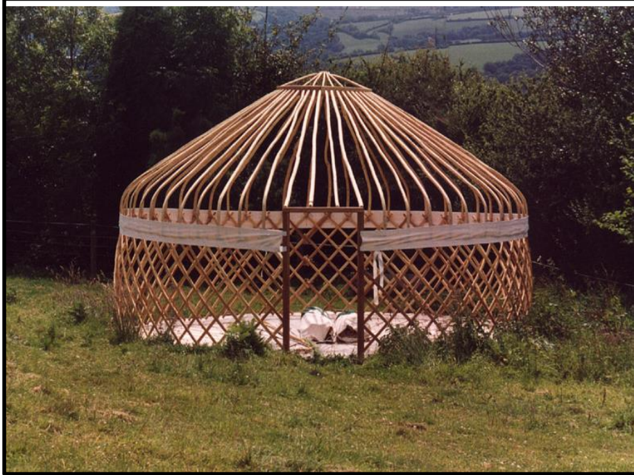
Fotoğraf- 6 Çatı ve Duvar İskeleti Görünümü
