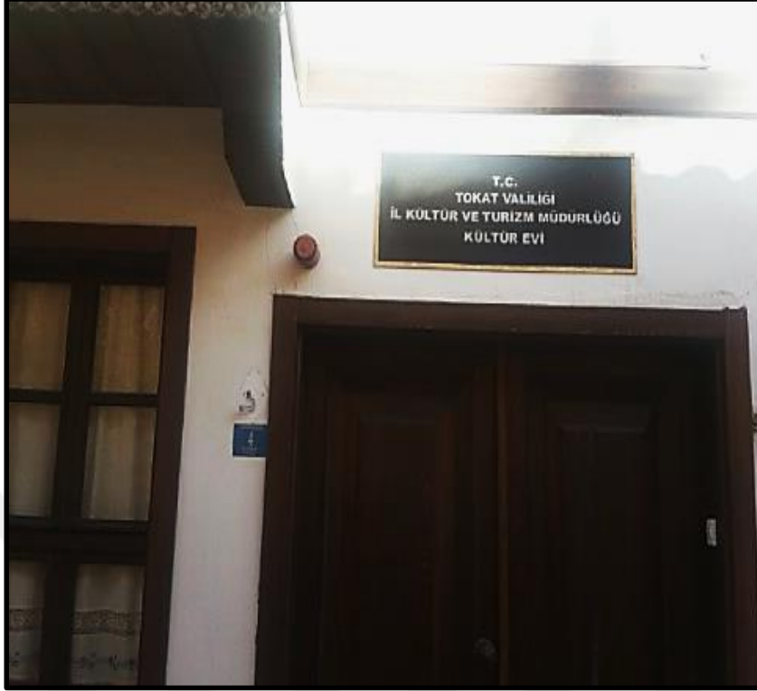
Resim- 6 Restorasyon sonrası kapı girişi.
