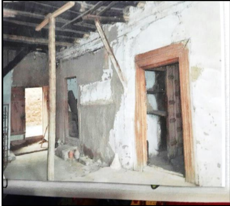
Fotoğraf- 15 Restorasyon Öncesi Giriş Kat
