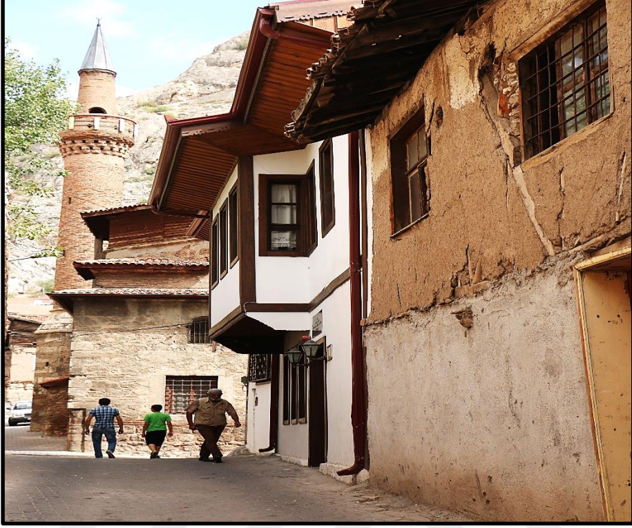
Resim- 8 Restorasyon sonrası ön cephe ve sokak.
