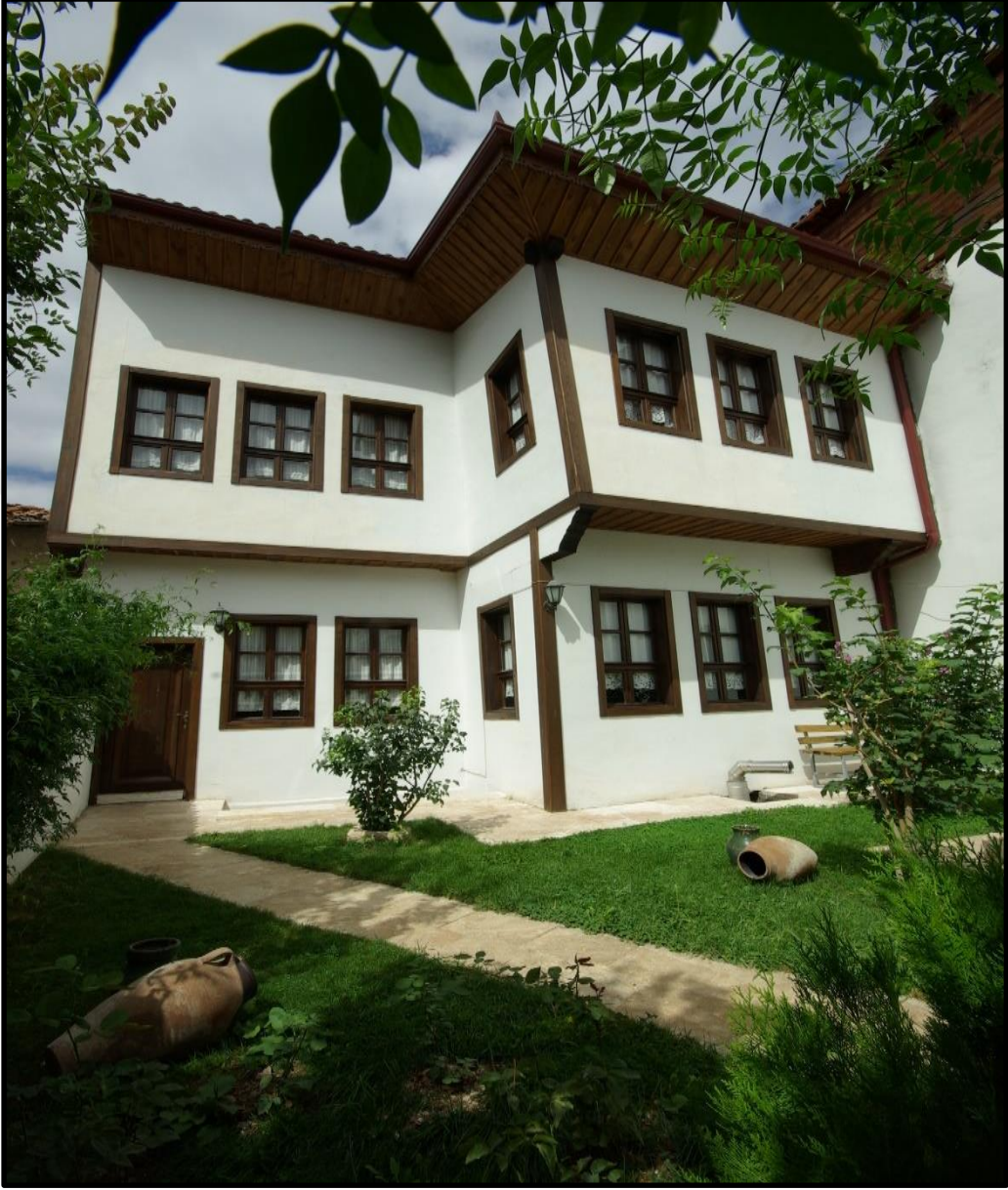
Resim- 10 Bahe ve arka cephe.
