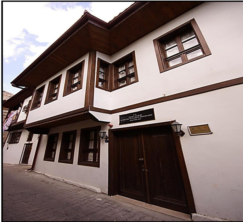
Resim- 7 Restorasyon sonrası ön cephe.
