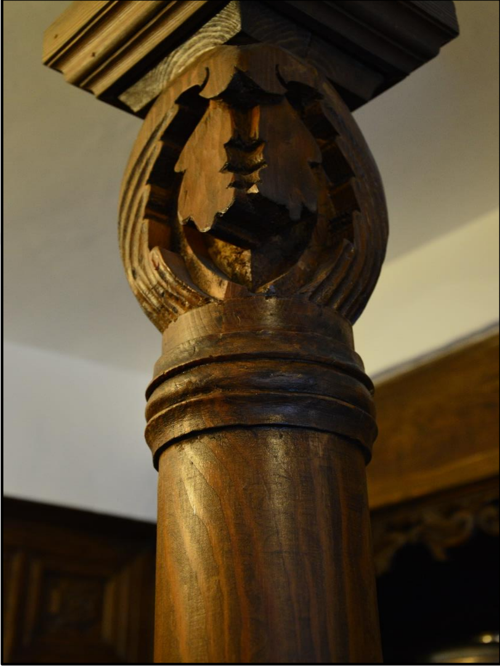
Resim- 28 Giriş kat (Z02 numaralı) oda ahşap kolonu.
