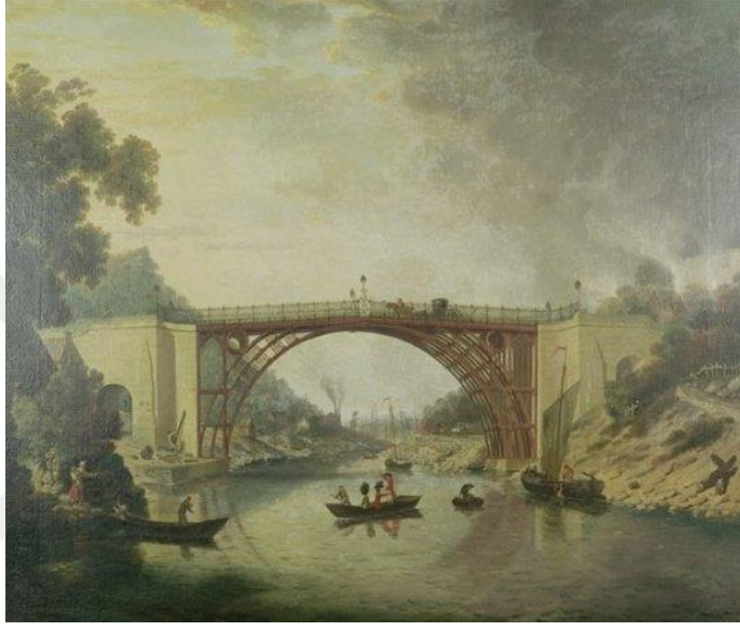
Resim. 1. 1778 yılında tamamlandığı tahmin edilen İngiltere'nin, Severn nehri üzerindeki Coalbrookdale Köprüsü.
