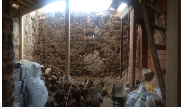
Görsel.106: Alt Kat Yapım Aşamaları
