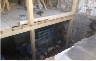
Görsel.107: Yapım Aşamaları
