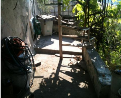
Görsel.113: Yapım Aşamaları
