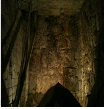
Görsel.105: Alt Kat Yapım Aşamaları
