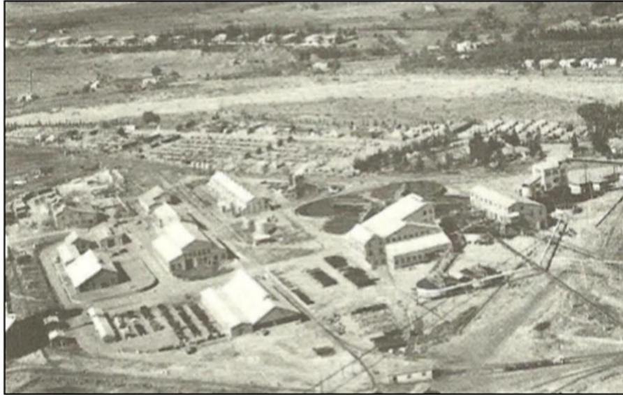
Görsel 4.5: Gemikonağı, dükkânlar, depolar, enerji santrali ve değirmen tesisleri (Lavender,1962, s.342).
