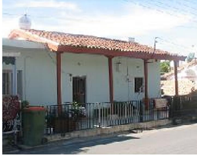
Görsel 4.17: Gemikonağı ustabaşı lojmanları görünüşü (Güç,2015).
