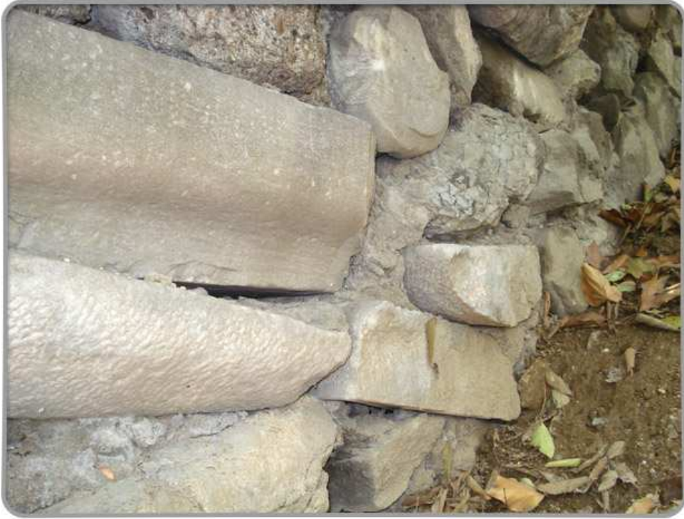
Resim 343 (Mezar Taşları İle Yapılmış Duvar)
