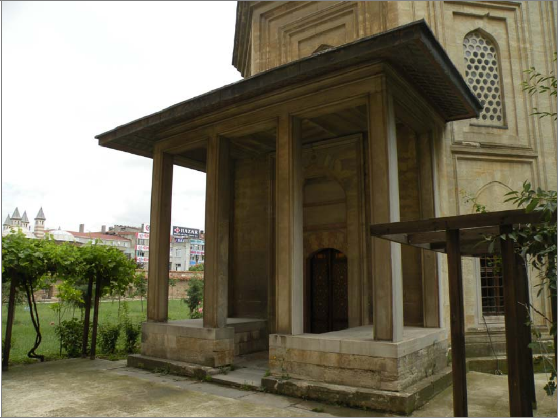
Fotoğraf 234: Türbe önündeki revak kısmı.
