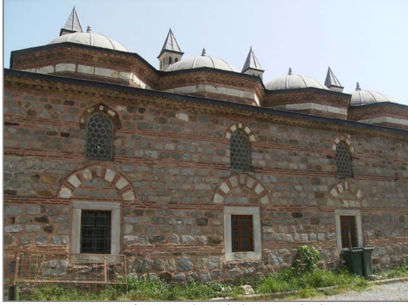
Fotoğraf 228: Medresenin kuzey cephesi.
