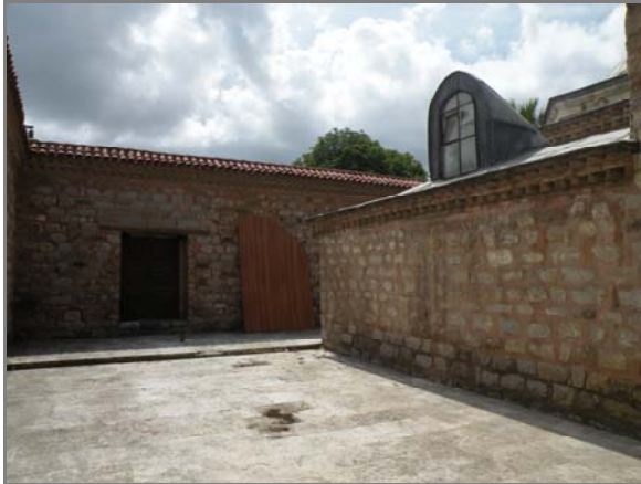
Fotoğraf 31: Servis kapısının açıldığı iç bahçe.
