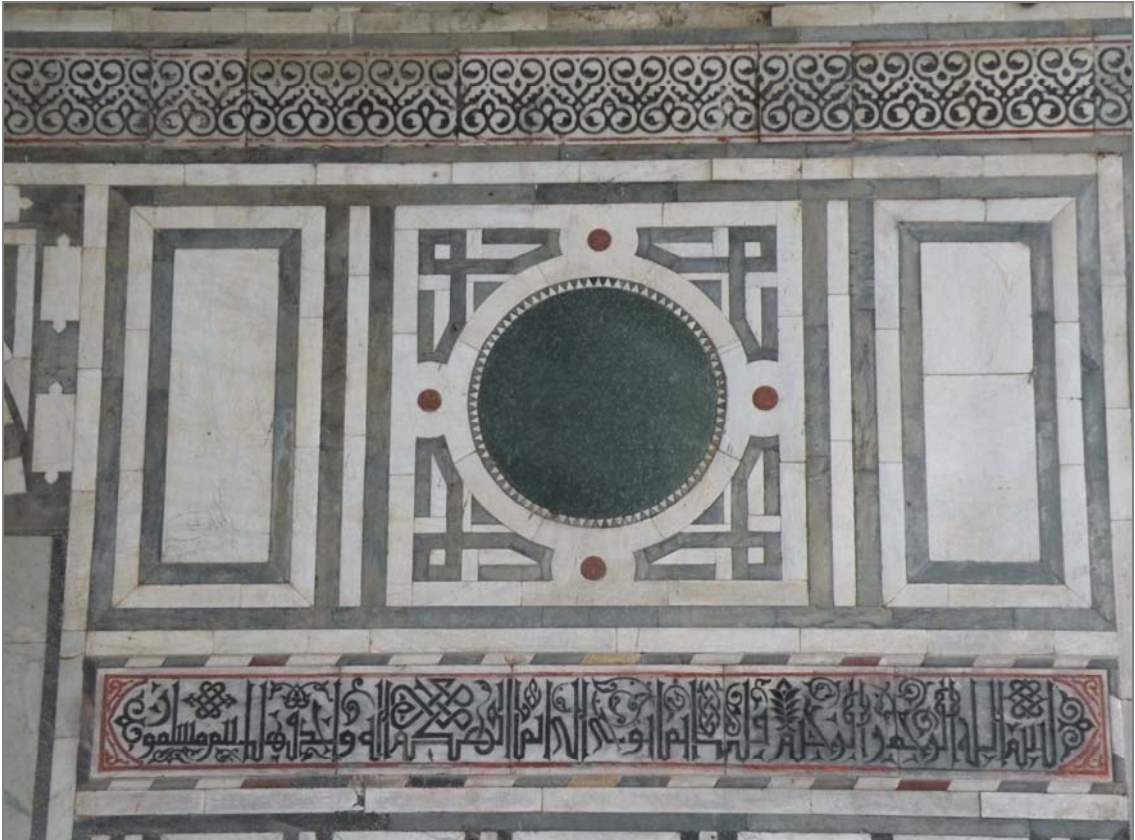
Fotoğraf 108: Son cemaat yeri batı bölüm, minare kapısı-niş arası üst kısım düzenlemesi.
