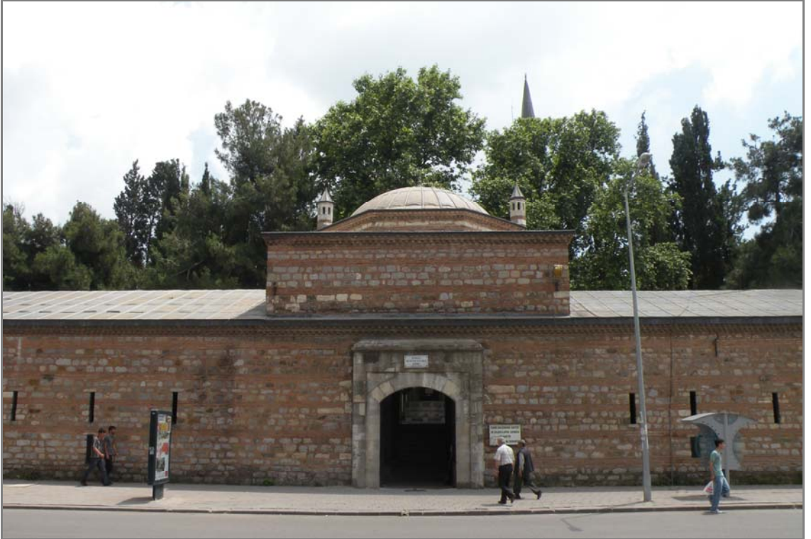
Fotoğraf 21: Kervansaray, kuzey giriş kapısı.
