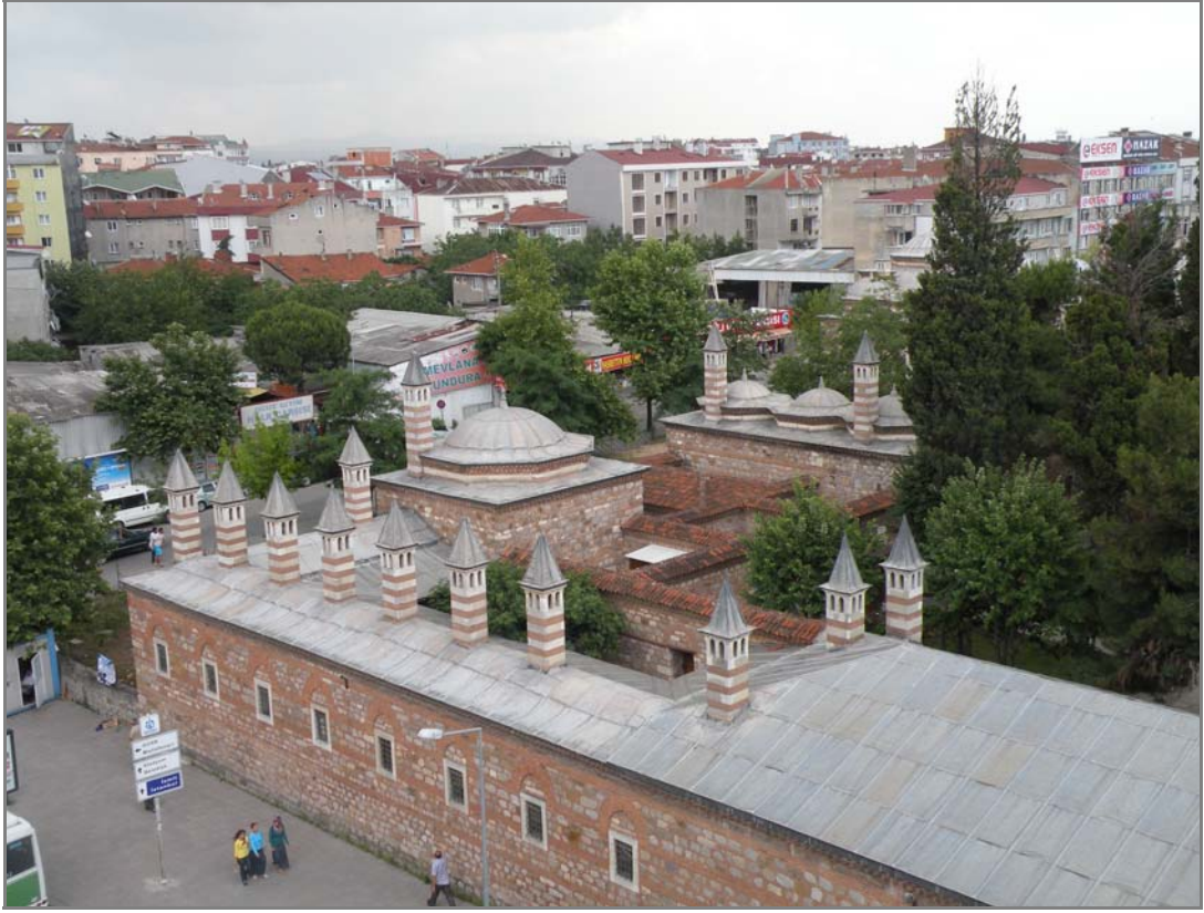
Fotoğraf 280: Zâviye, külliye'nin kuzeydoğu bölümü.
