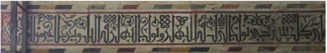
Fotoğraf 198: Kuzey duvar, kuzeydoğu köşe.
