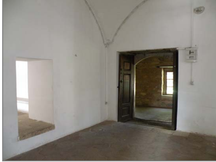
Fotoğraf 321: Mutfak giriş kapısı ve servis penceresi.
