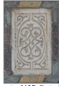
Fotoğraf 127: Doğu bölüm, cephe sonundaki motif.
