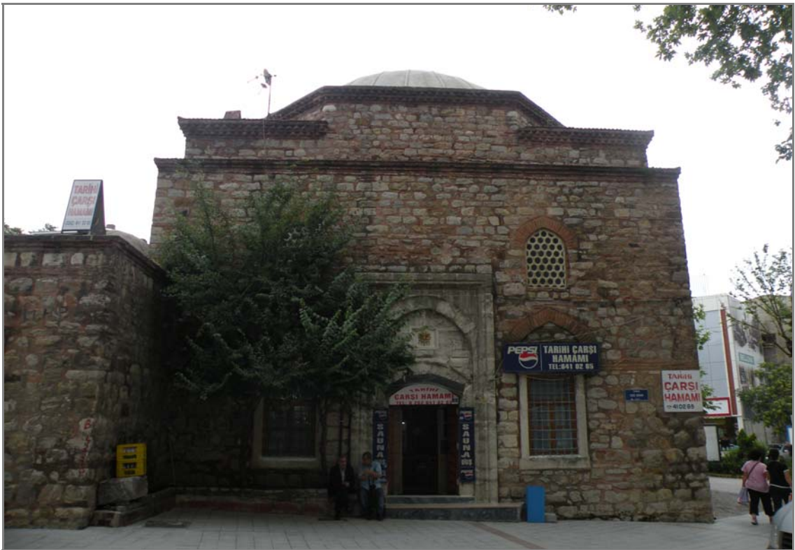
Fotoğraf 336: Erkekler kısmı giriş cephesi.
