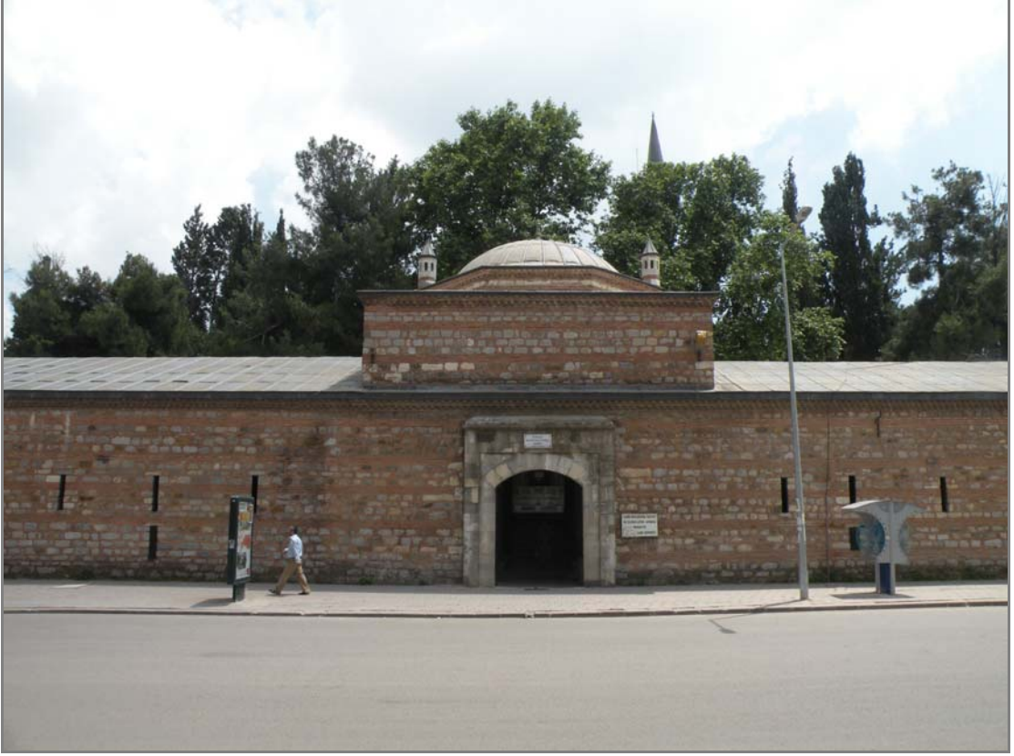
Fotoğraf 292: Kervansaray giriş cephesi.
