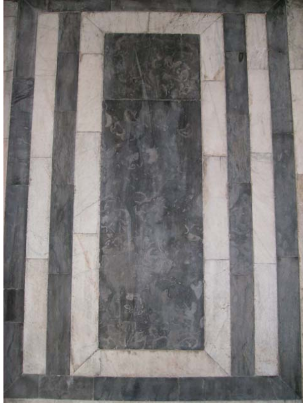
Fotoğraf 56: Doğu ve batı cephedeki pencere nişi duvarları.
