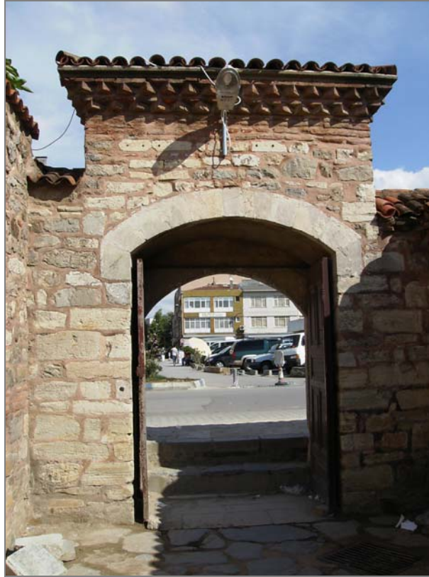
Fotoğraf 25: Güney giriş kapısı, arka cephe.
