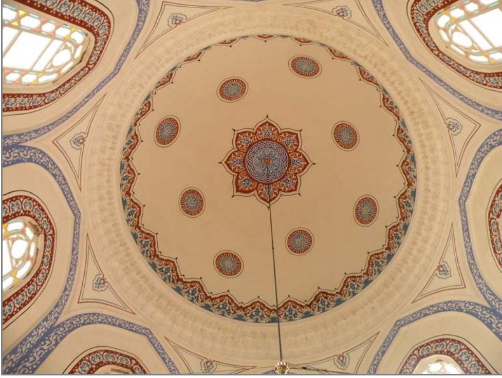
Fotoğraf 239: Türbe, kubbe ve kubbeye geçiş sistemi.
