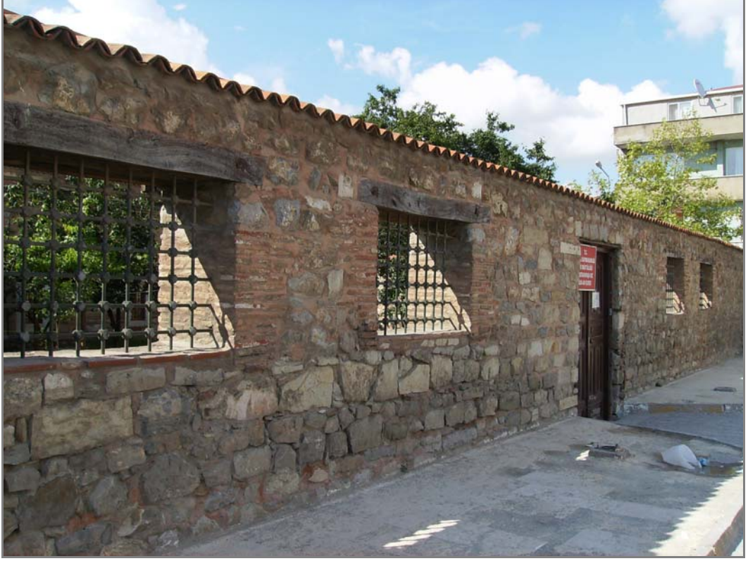
Fotoğraf 202: Medrese dış bahçe duvarı.
