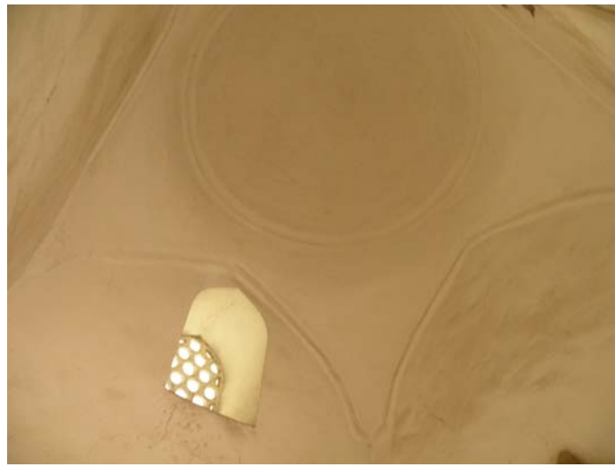
Fotoğraf 273: Odaların kubbe ve kubbe geçişleri.
