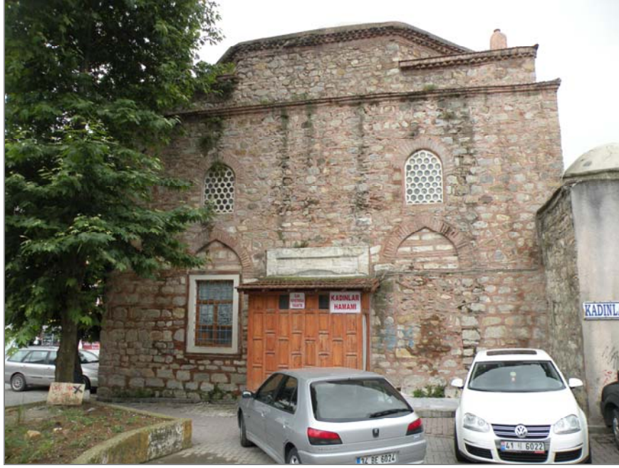
Fotoğraf 337: Bayanlar kısmı giriş cephesi.
