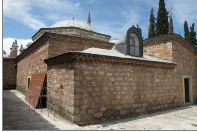
Fotoğraf 332: İmaretin güneyindeki iç bahçe.
