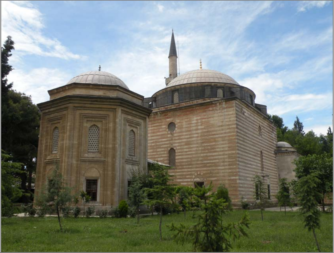
Fotoğraf 232: Cami ve türbe, güneydoğudan.
