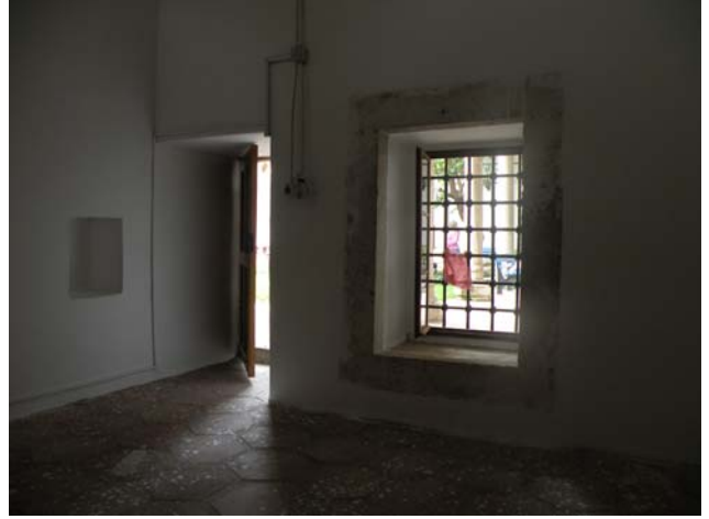
Fotoğraf 219: Tuvalet yanındaki oda, kapı ve pencere.
