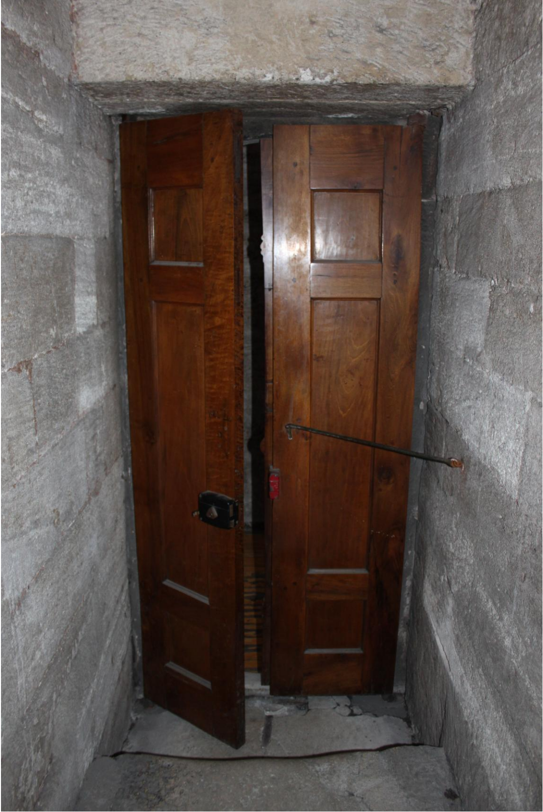
Fotoğraf 31: Rüstem Paşa Camii Sol Mahfil Merdivenleri Avlu Kapısı İçten Görünüm
