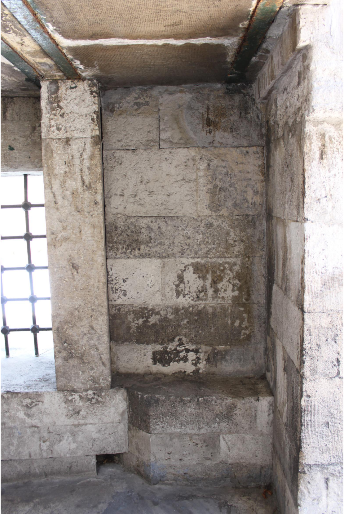
Fotoğraf 18: Rüstem Paşa Camii 2. Giriş Solunda Buluna Niş
