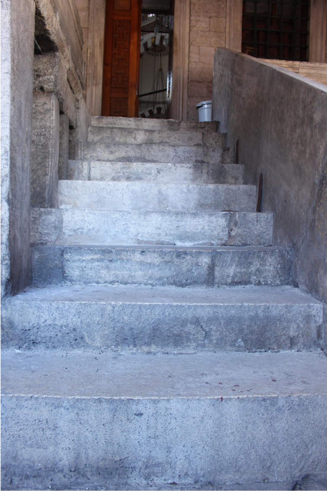
Fotoğraf 36: Rüstem Paşa Camii Sol Mahfil Merdiveni, 2. Merdiven Kolu
