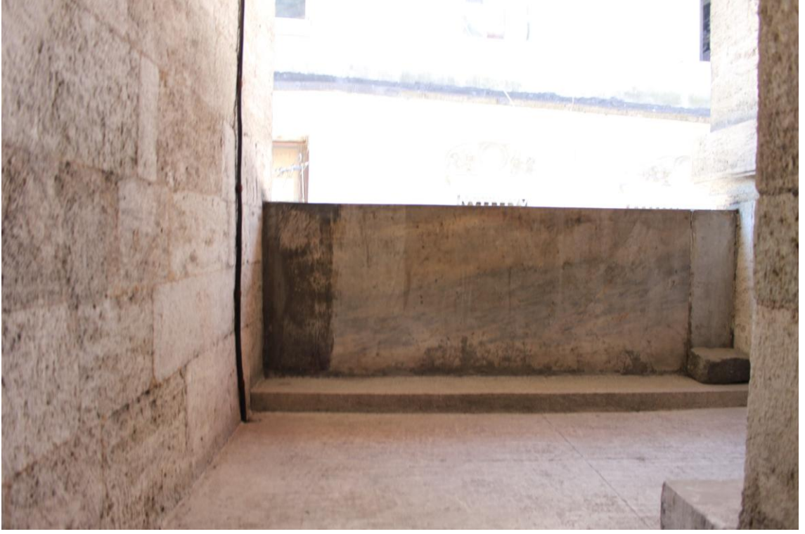
Fotoğraf 49: Rüstem Paşa Camii Sağ Mahfil Merdiveni Köşe Sahanlığı
