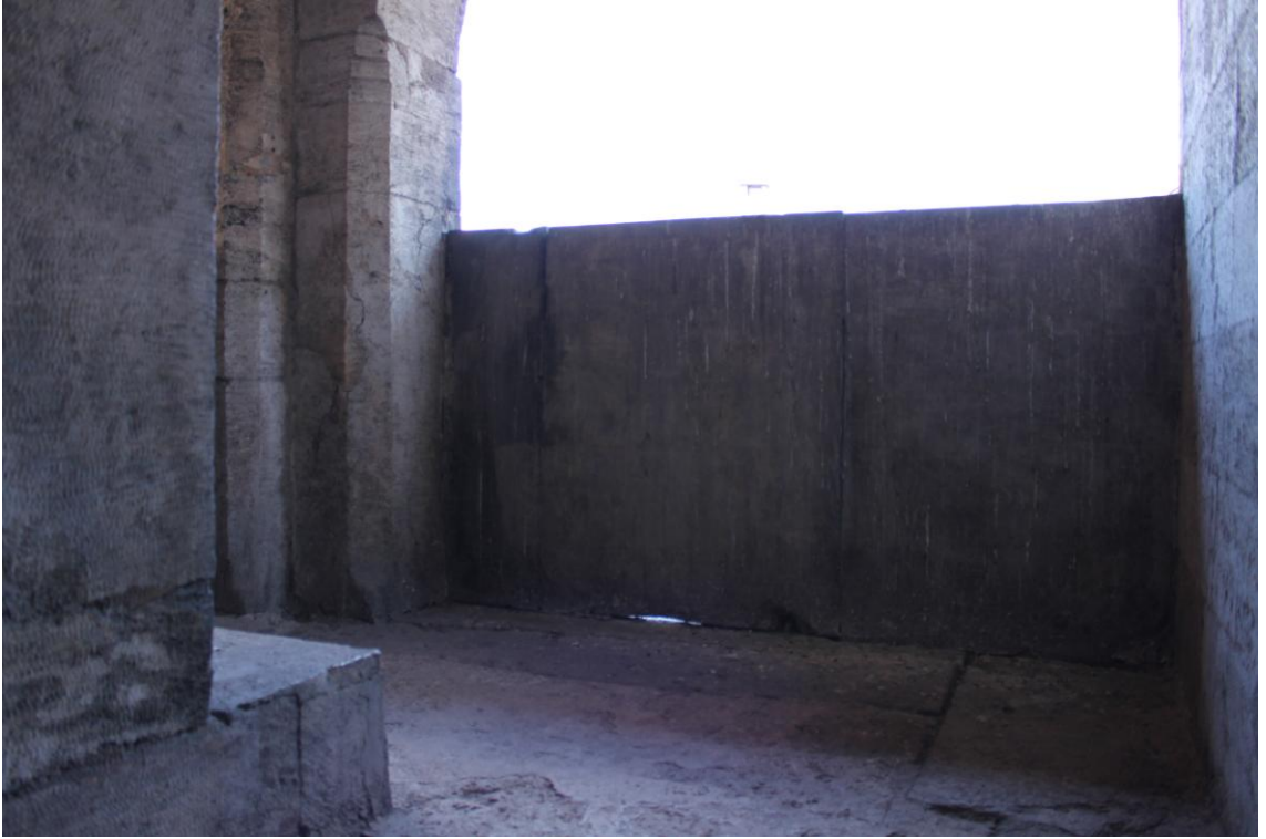
Fotoğraf 35: Rüstem Paşa Camii Sol Mahfil Merdiveni Köşe Sahanlığı
