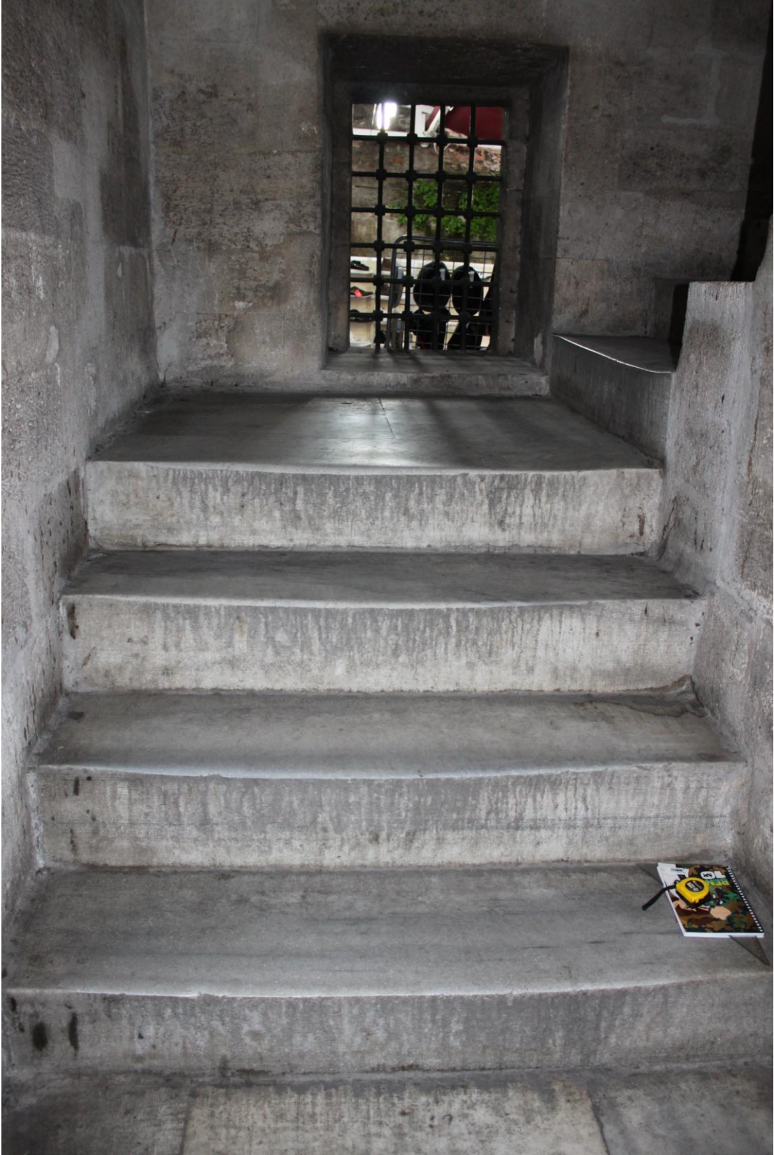
Fotoğraf 13: Rüstem Paşa Camii 2. Giriş, 1 Merdiven Kolu
