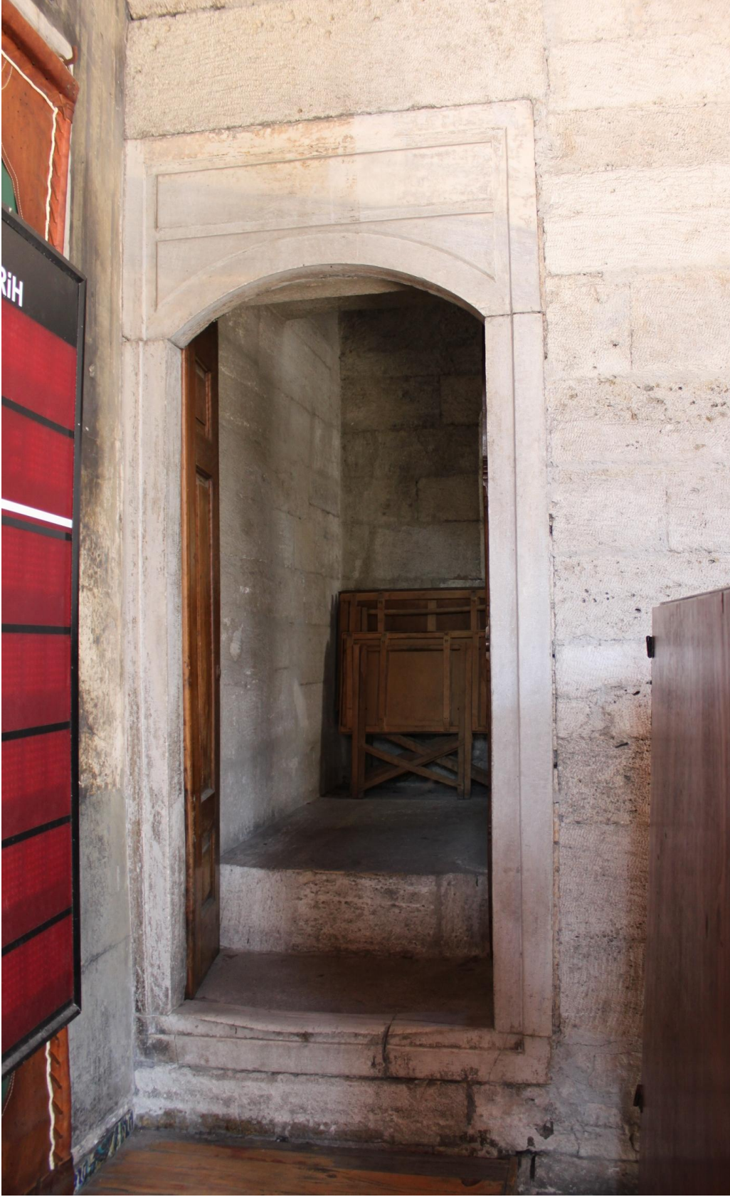
Fotoğraf 43: Rüstem Paşa Camii Sağ Mahfil Avlu Kapısı ve Giriş Sahanlığı
