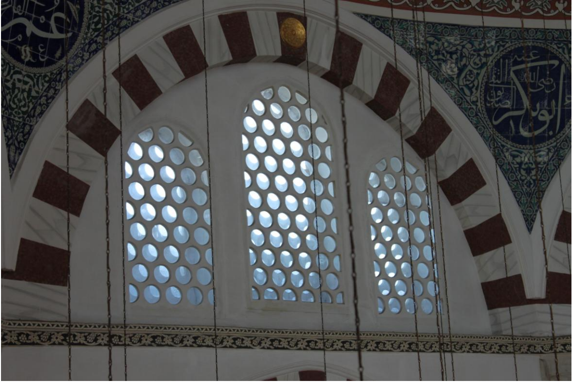
Fotoğraf 93: Rüstem Paşa Camii Sol Cephe Üçlü Pencere Dizisi
