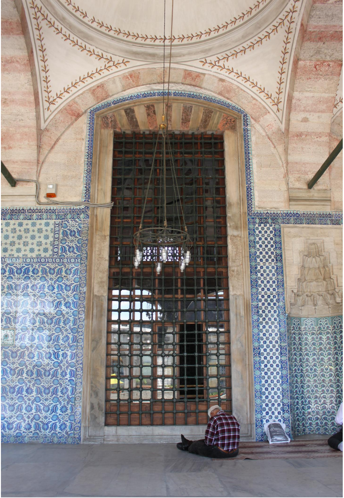
Fotoğraf 74: Rüstem Paşa Camii Cümle Kapısı Sağında Bulunan Büyük Pencere (Dıştan Görünüm)
