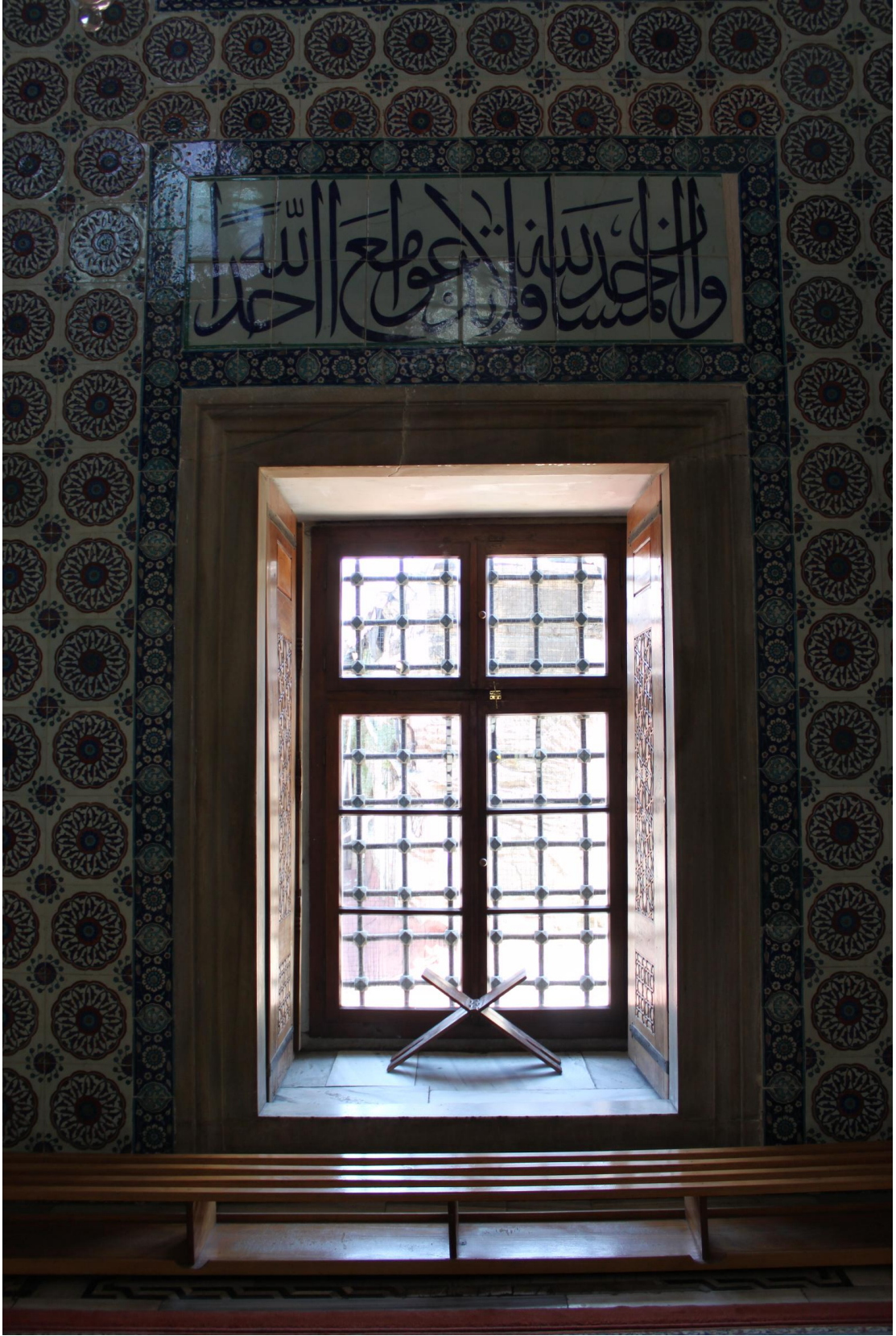
Fotoğraf 72: Rüstem Paşa Camii Harem Zemin Kat Mihrap Sağı Pencere (Açık)
