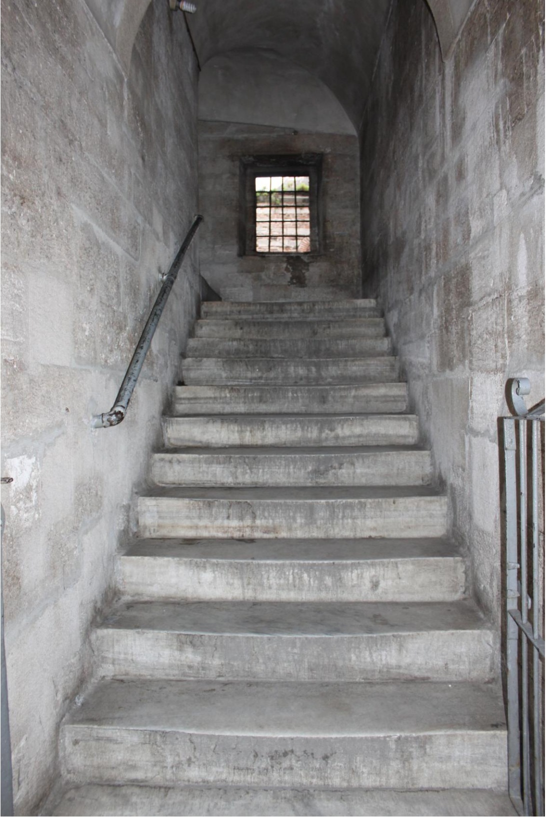
Fotoğraf 3: Rüstem Paşa Camii 1. Giriş, 1. Merdiven Kolu
