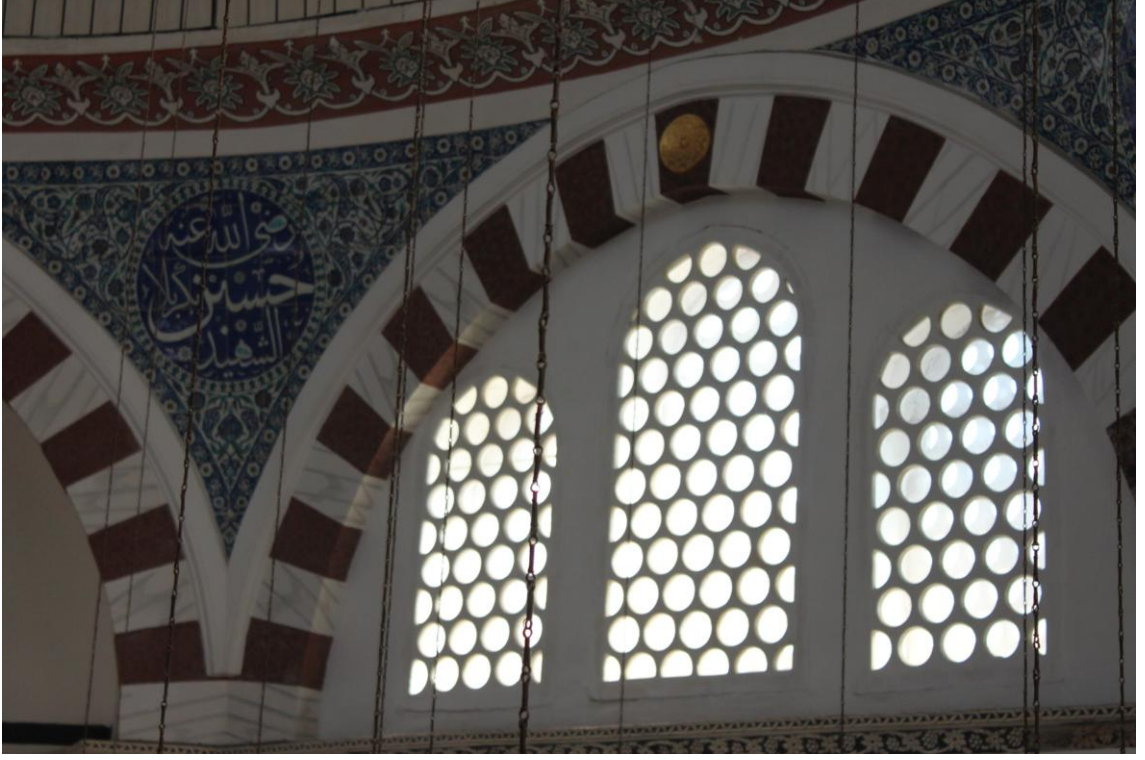
Fotoğraf 92: Rüstem Paşa Camii Sağ Cephe Üçlü Pencere Dizisi
