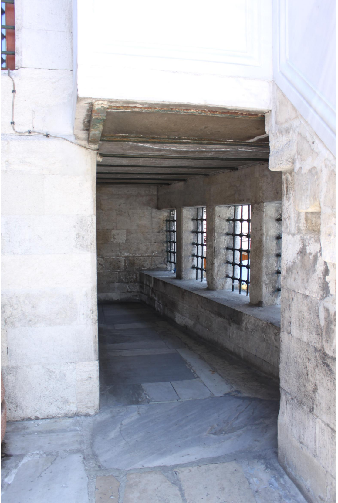
Fotoğraf 17: Rüstem Paşa Camii 2. Giriş, Avludan Görünüş
