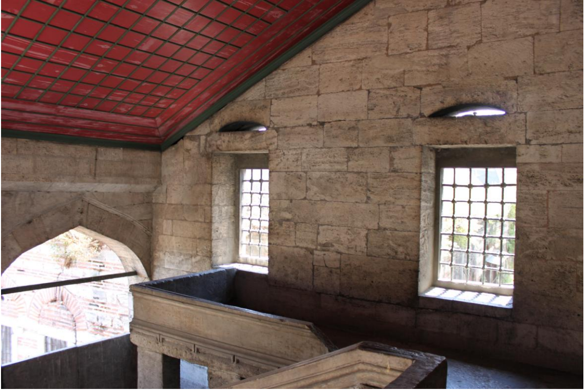
Fotoğraf 38: Rüstem Paşa Camii Sol Mahfil Merdiveni Mahfil Sahanlığı
