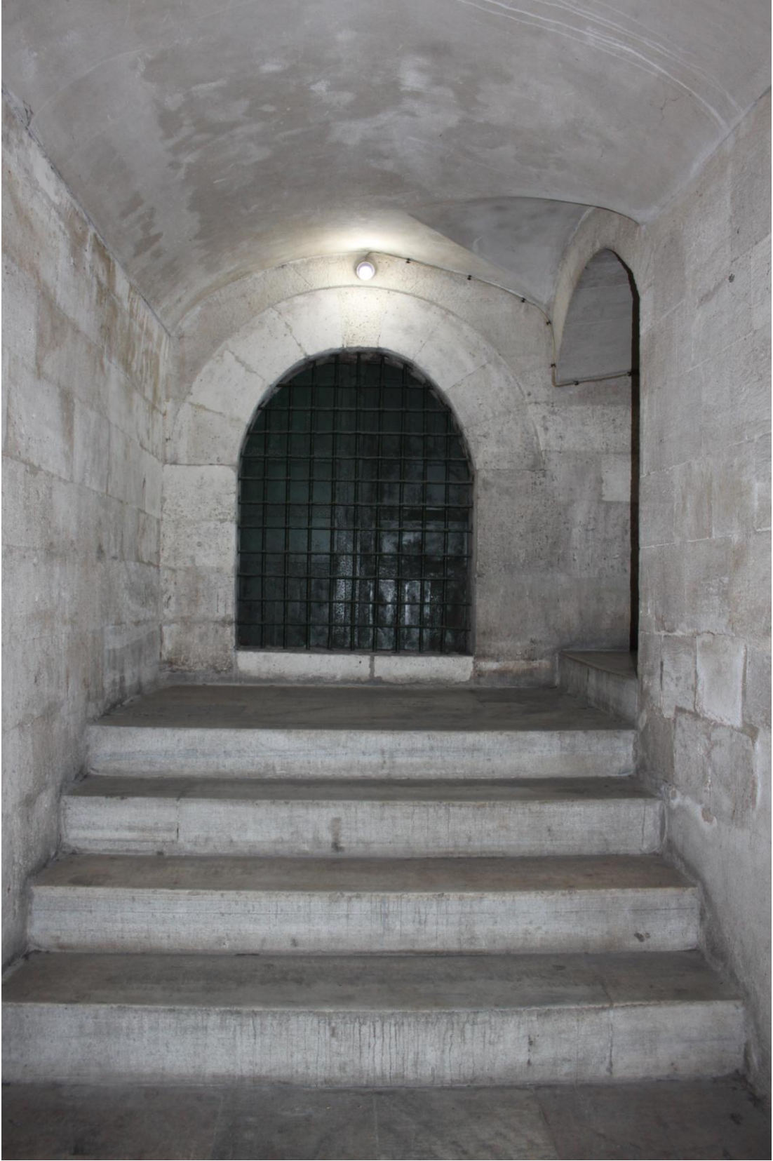
Fotoğraf 22: Rüstem Paşa Camii 3. Giriş, 1. Merdiven Kolu
