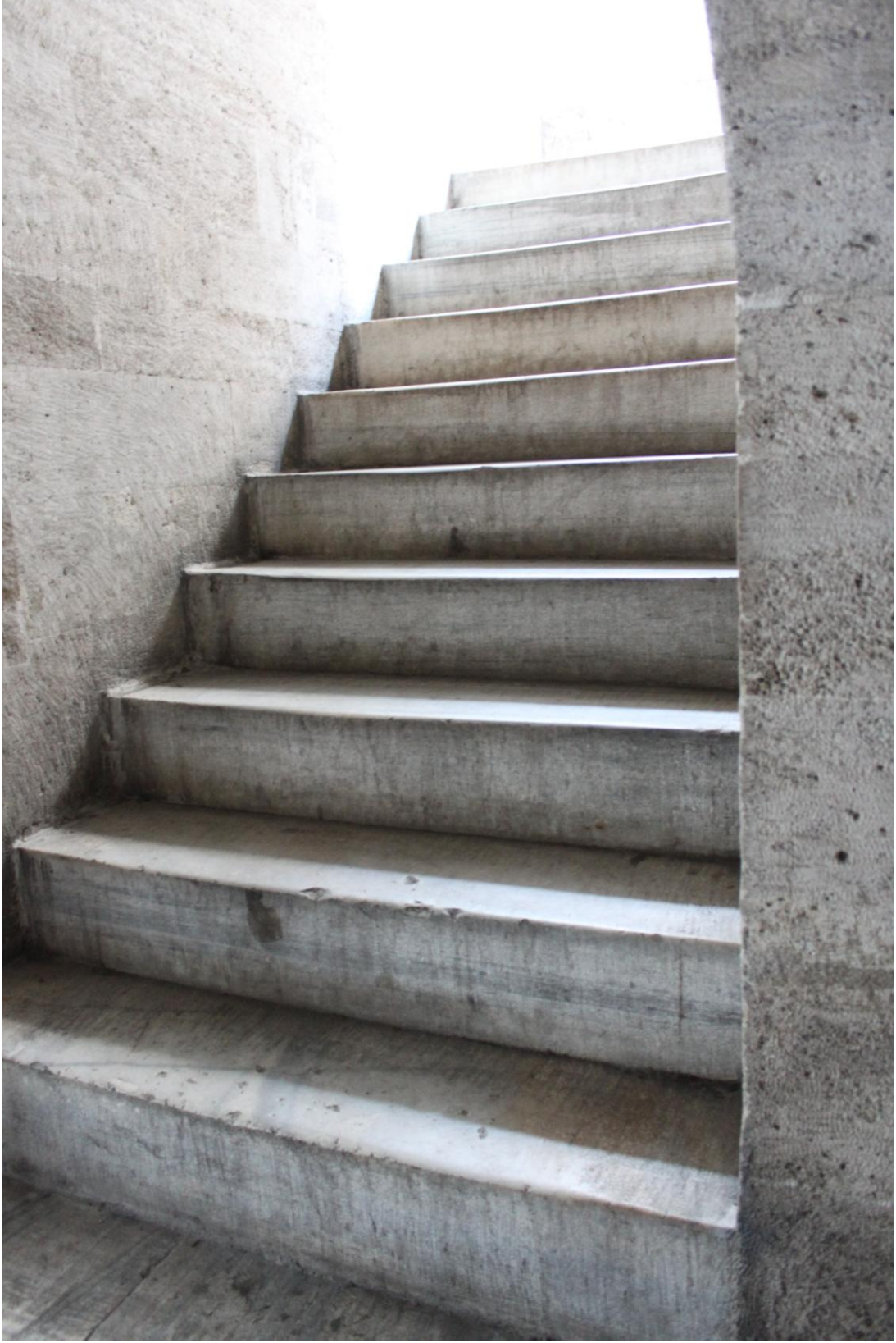
Fotoğraf 24: Rüstem Paşa Camii 3. Giriş, 3. Merdiven Kolu
