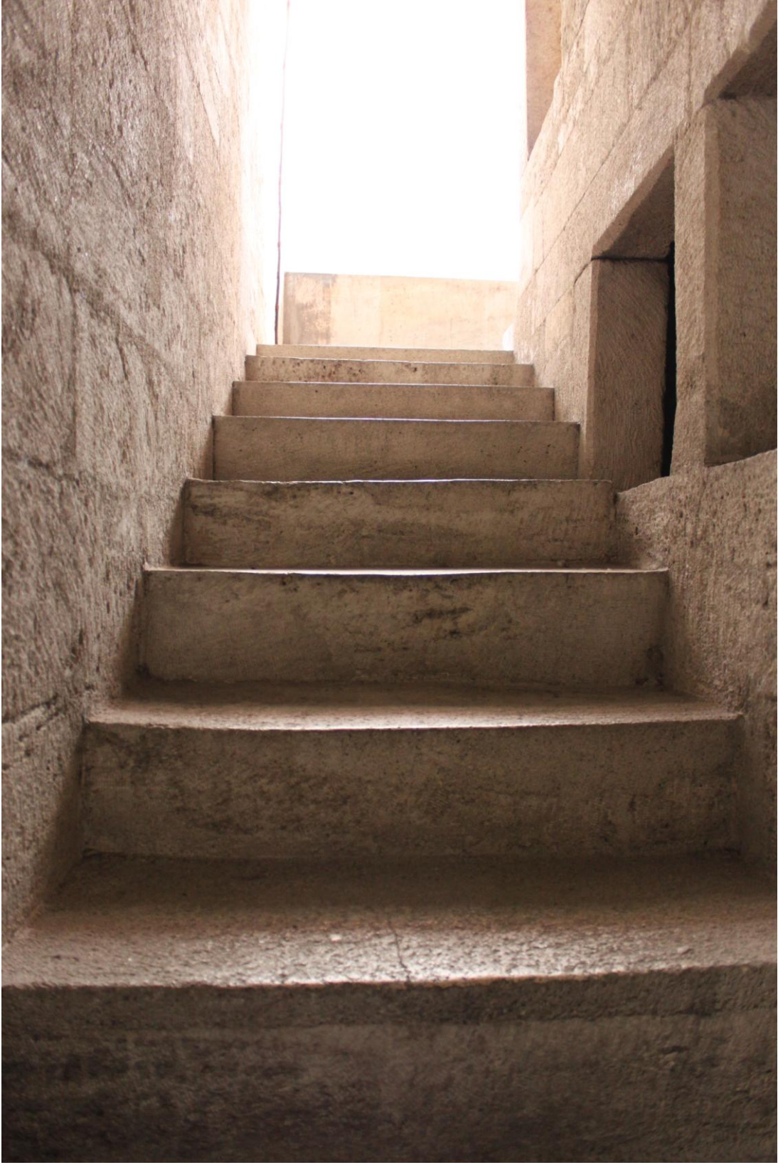
Fotoğraf 48: Rüstem Paşa Camii Sağ Mahfil Merdiveni, 1. Merdiven Kolu
