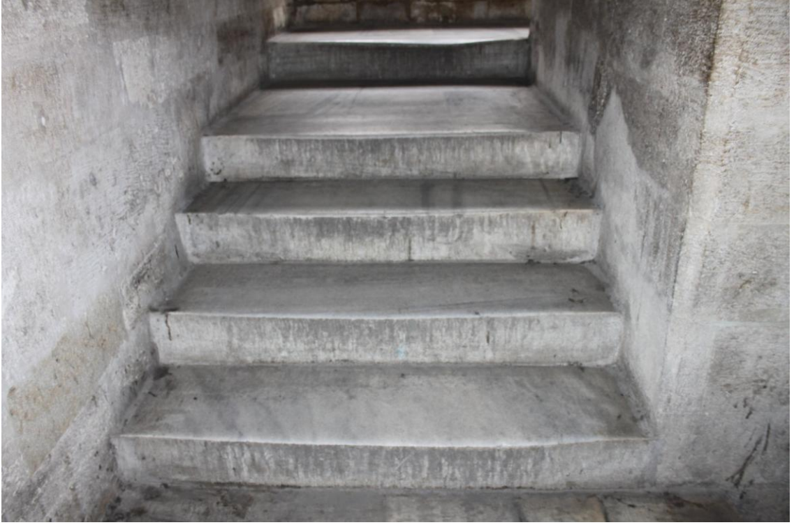
Fotoğraf 15: Rüstem Paşa Camii 3. Giriş, 3. Merdiven Kolu
