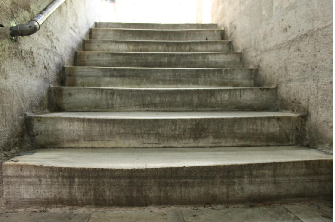
Fotoğraf 6: Rüstem Paşa Camii 1. Giriş, 3. Merdiven Kolu
