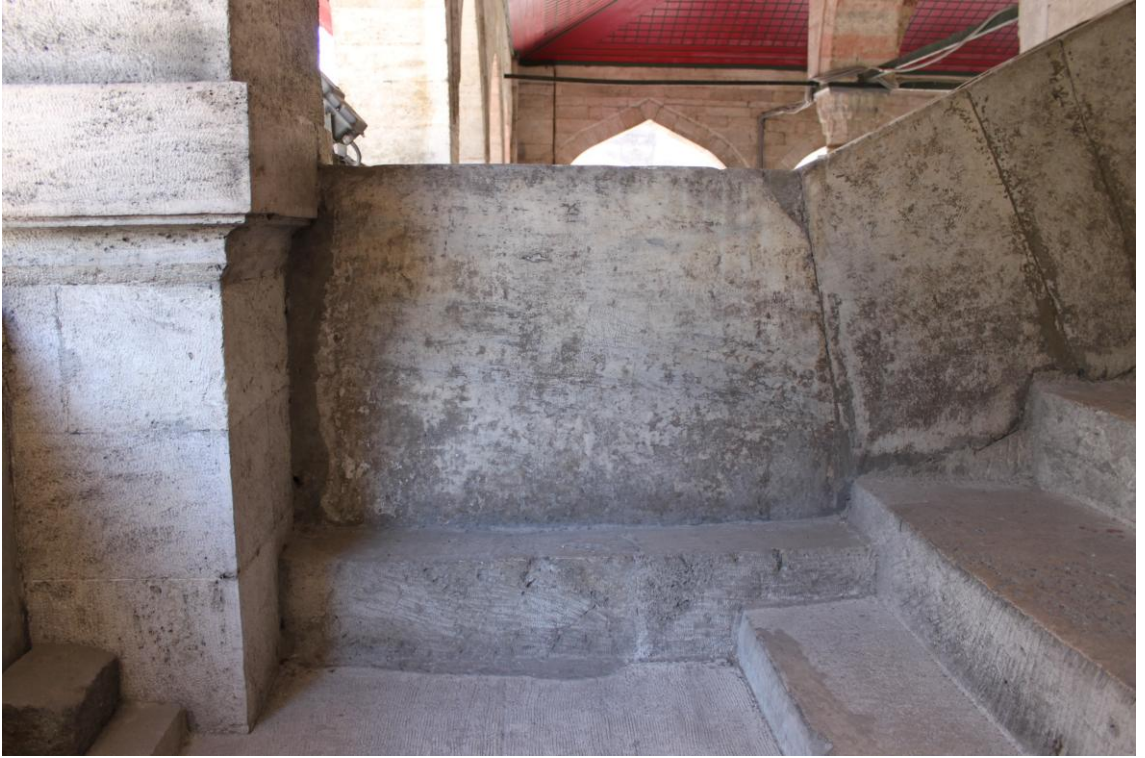
Fotoğraf 50: Rüstem Paşa Camii Sağ Mahfil Merdiveni Köşe Sahanlığı
