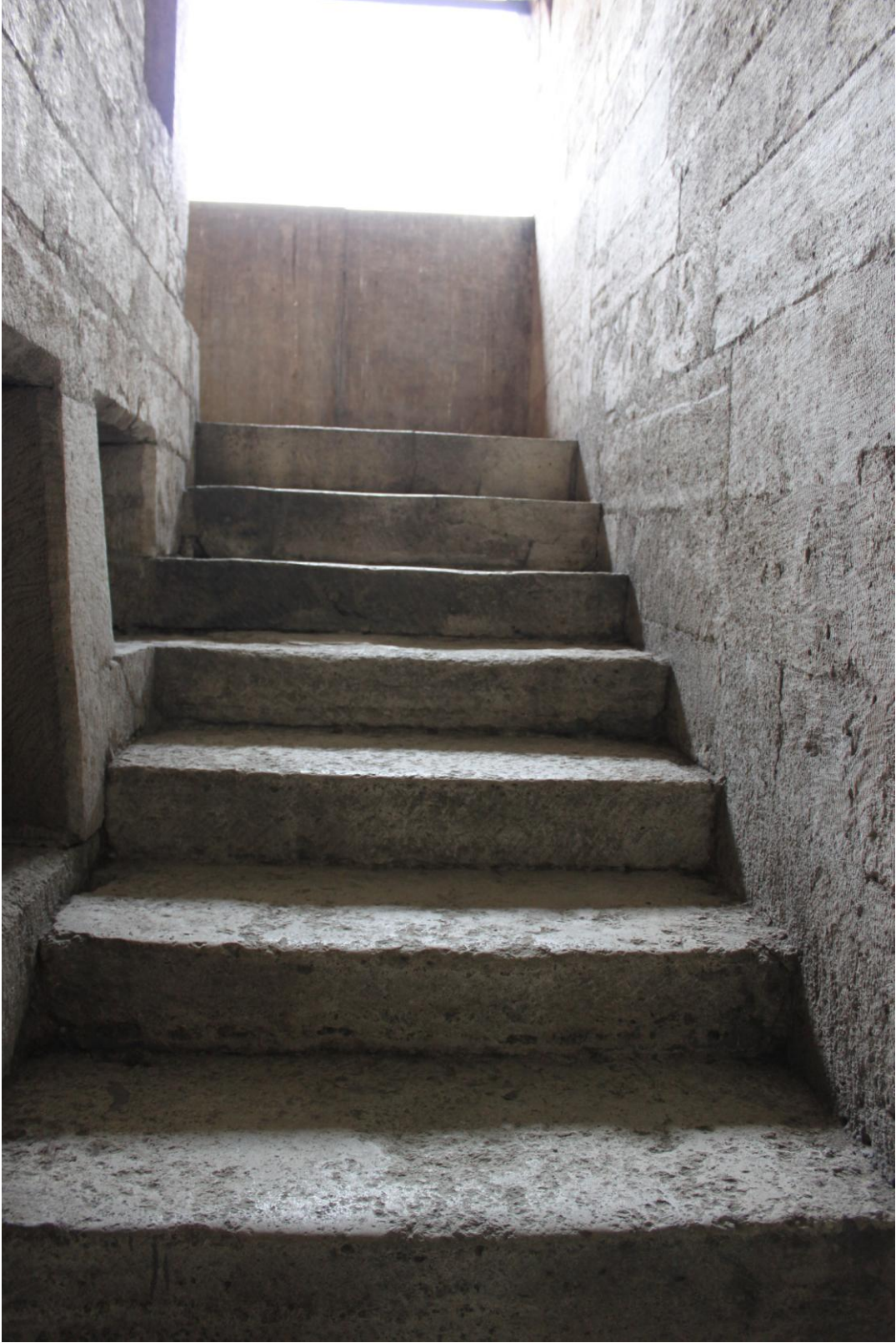
Fotoğraf 33: Rüstem Paşa Camii Sol Mahfil Merdiveni, 1. Merdiven Kolu
