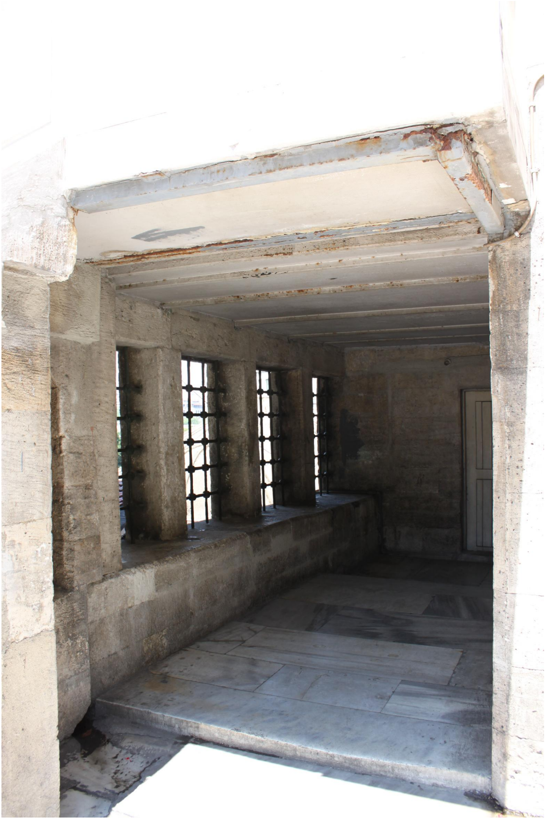
Fotoğraf 10: Rüstem Paşa Camii 1. Giriş, Kat Sahanlığı, Avludan Görünüm
