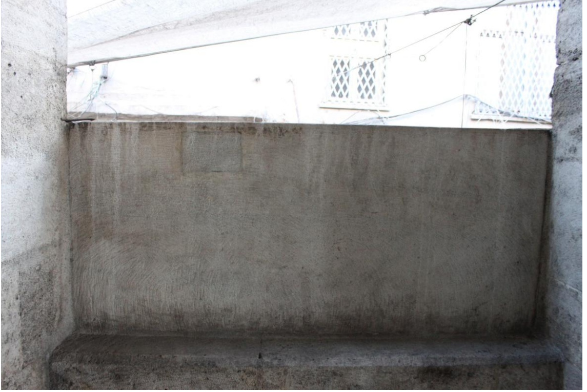
Fotoğraf 26: Rüstem Paşa Camii 3. Giriş, 3. Köşe Sahnlığı, Korkuluk
