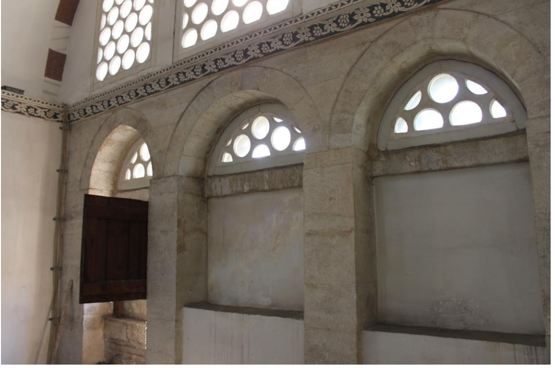
Fotoğraf 90: Rüstem Paşa Camii Kible Cephesi Üçlü Pencere Dizisi
