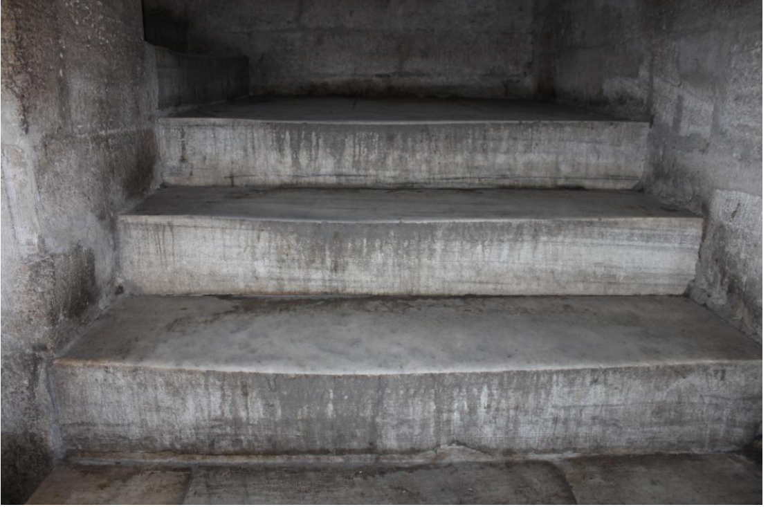
Fotoğraf 5: Rüstem Paşa Camii 1. Giriş, 2. Merdiven Kolu
