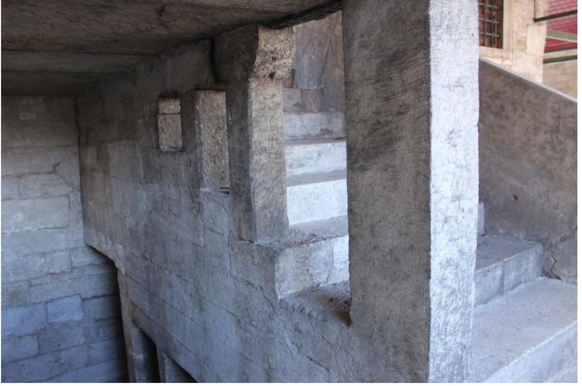
Fotoğraf 37: Rüstem Paşa Camii Sol Mahfil Merdiveni 2. Merdiven Kolu
