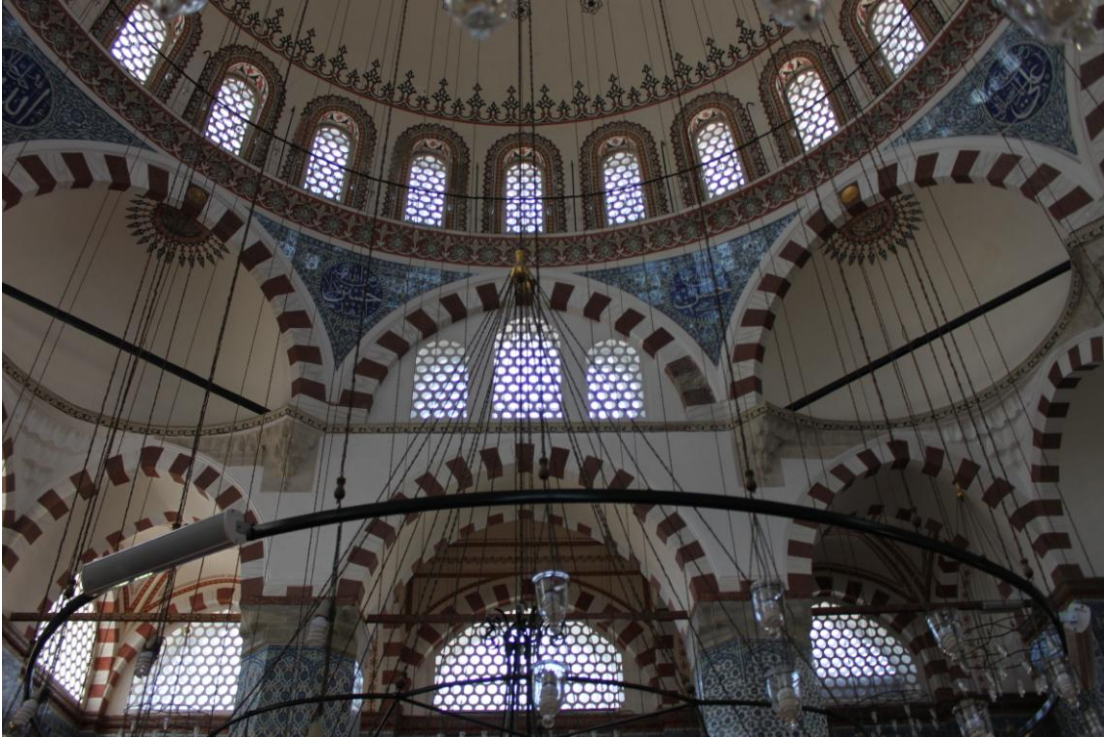
Fotoğraf 83: Rüstem Paşa Camii Sağ Cephe 1. ve 2. Korniş Üstü Pencereleeri
