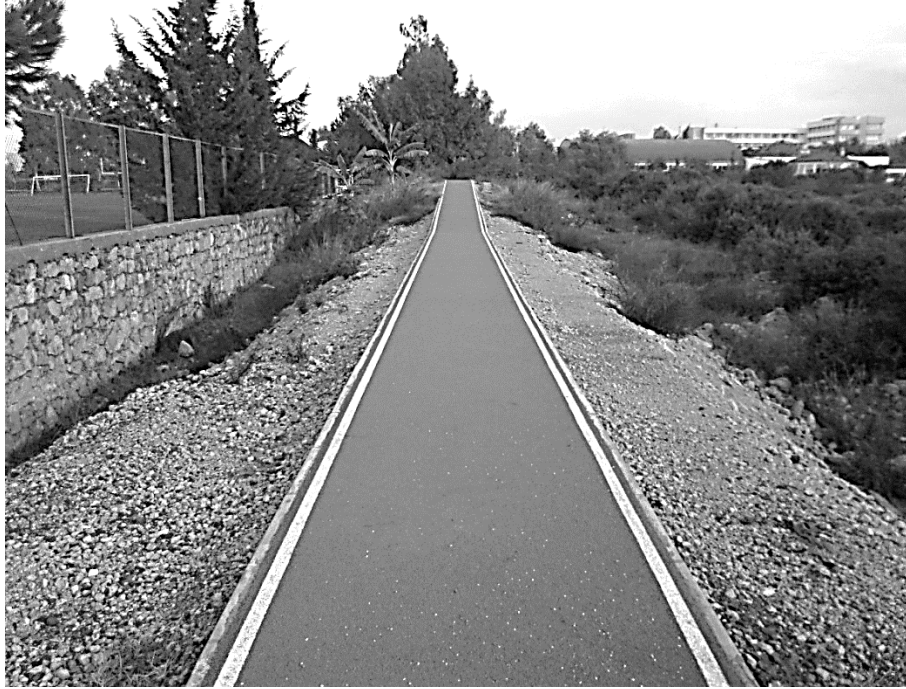
Şekil 0.13. Çalışma gruplarından Tç, Ti ve Ti+Tç gruplarının çalışma yaptığı alan
