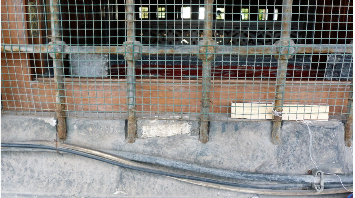
Resim 121. Sultan Ahmed Camii doğu cephesi üst sofasında çerçeve deformasyonu, pencere demirleri ve yerleşimi.
