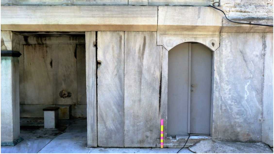
Resim 22. Sultan Ahmed Camii kuzeybatı minaresi girişi
