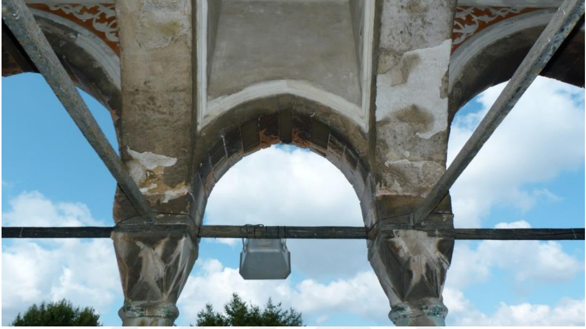
Resim 61. Sultan Ahmed Camii doğu cephesi üst sofa kemerleri
