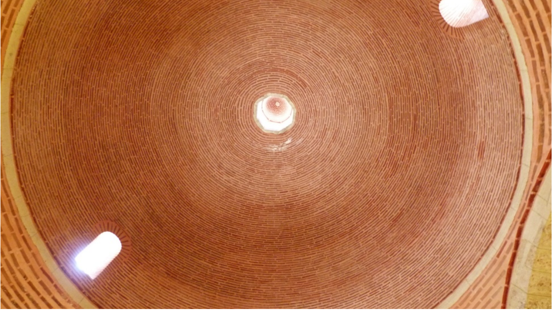
Resim 97. Sultan Ahmed Külliyesi imâret yapılarından matbah kubbesi.
