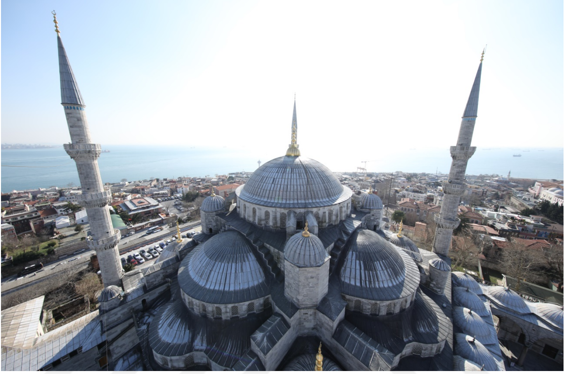
Resim 69. Sultan Ahmed Camii minaresinden örtü sistemi.
