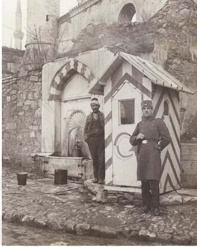
Resim 118. 1912-20 (?) Sultan Ahmed Külliyesi kuzeydoğu cephesi sebilinden kalan çeşme. Kaynak: https://tr.pinterest.com/pin/317433473717311065/ , (11.11.2016).
