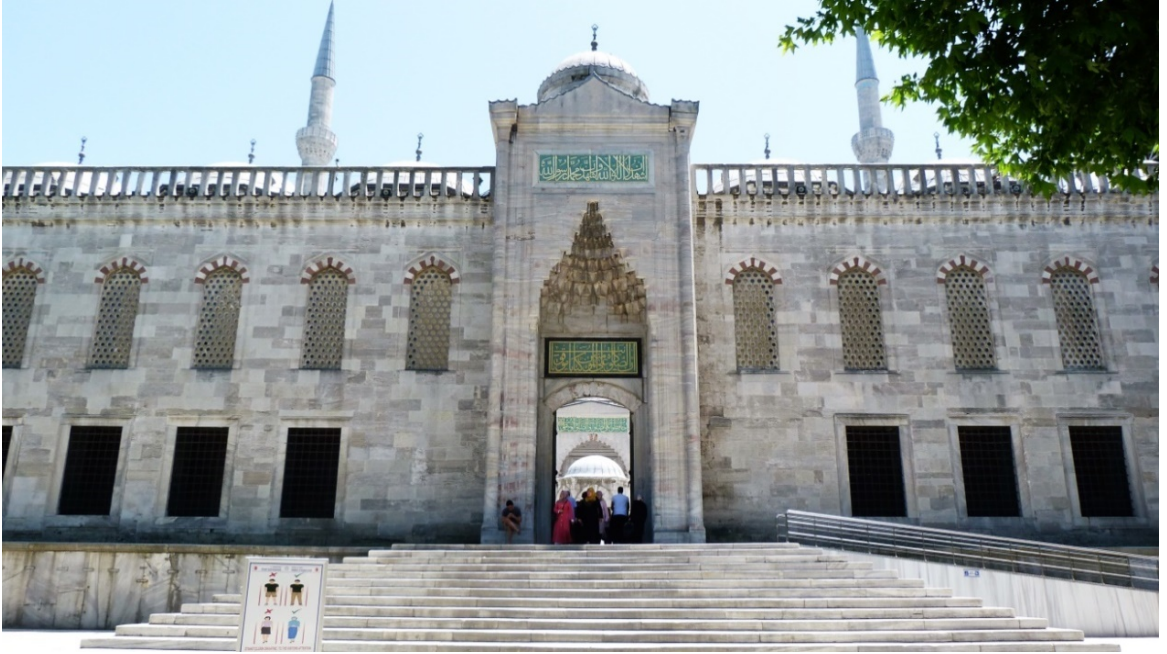
Resim 31. Sultan Ahmed Camii giriş cephesi ve avlu kapısı.
