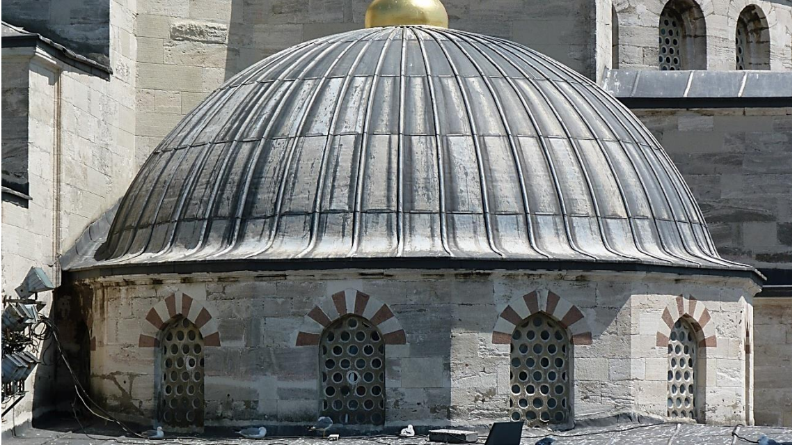
Resim 72. Sultan Ahmed Camii örtü sisteminde kasnak ve kasnak pencereleri ile köşe kubbelerinin dış görünümü.
