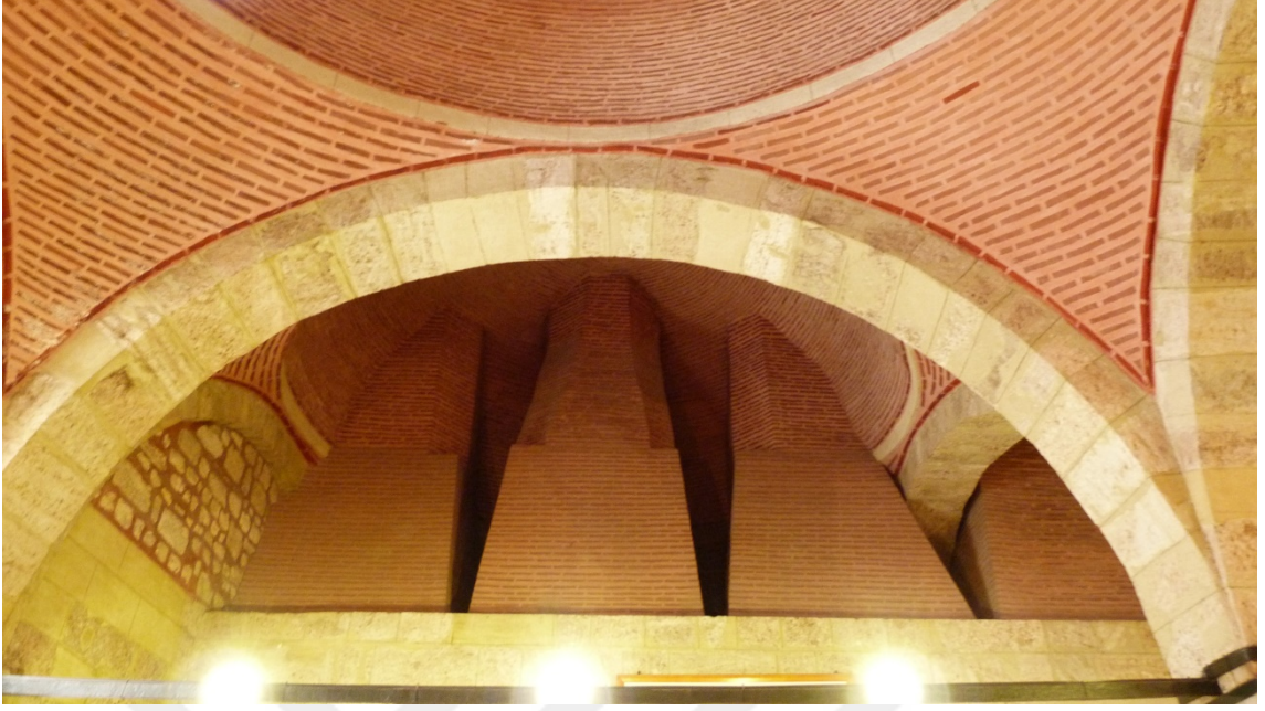
Resim 98. Sultan Ahmed Külliyesi imâret yapılarından matbah baca sistemi.
