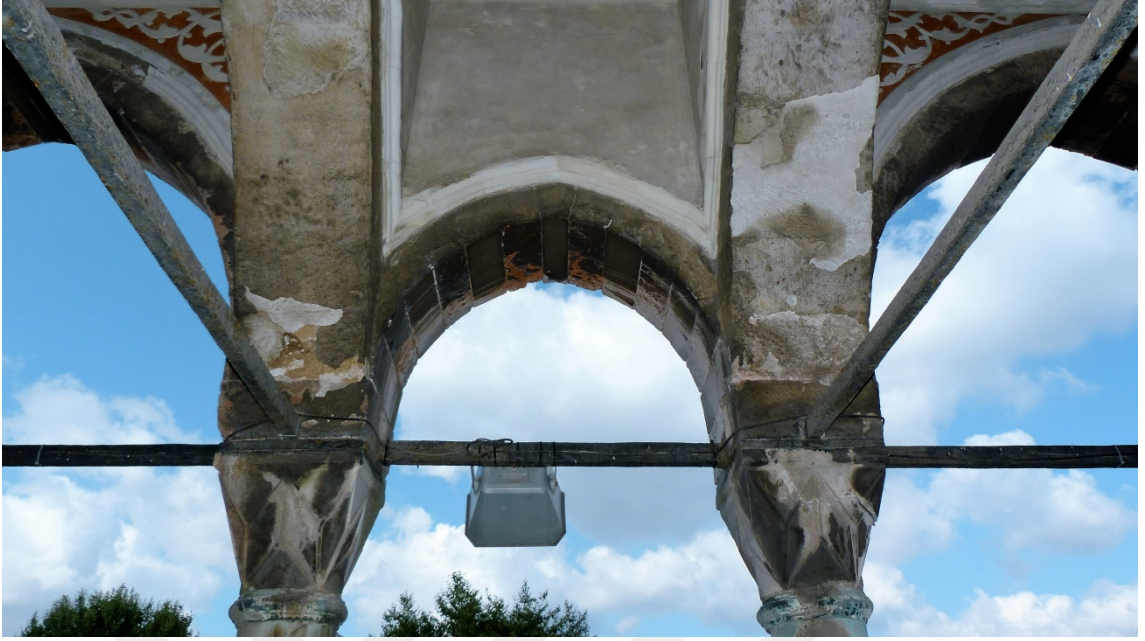
Resim 120. Sultan Ahmed Camii doğu cephesi üst mahfeli gergi ve bilezik ilişkisi.
