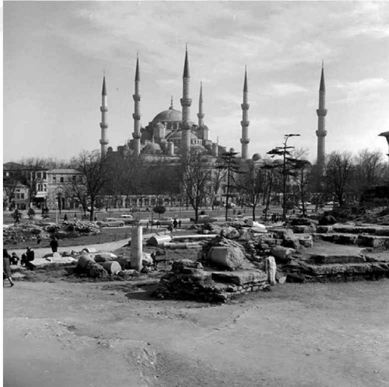
Resim 106. İbrahim Paşa Sarayı hizâsında hipodrom kalıntılarında Atmeydanı.
