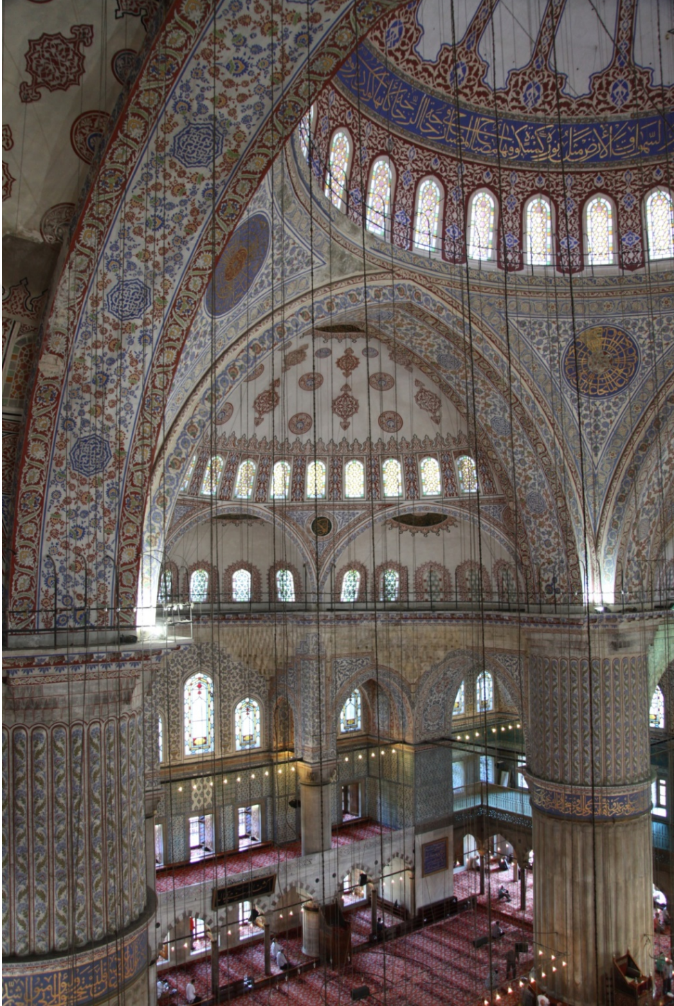
Resim 44. Sultan Ahmed Camii taşıyıcı sistem ve örtü sistemi arasındaki ilişkiyi gösterir. Kaynak: Aras Neftçi.
