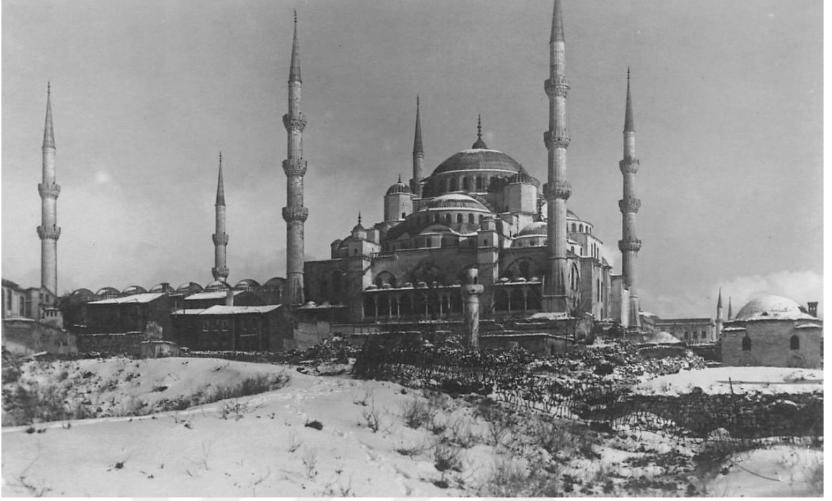
Resim 116. 29 Ocak 1928'de batı cephesinden Sultan Ahmed Camii ve önünde Kanlı Mescid minaresi ve bir kat seviyesinde mescid beden duvarları.
