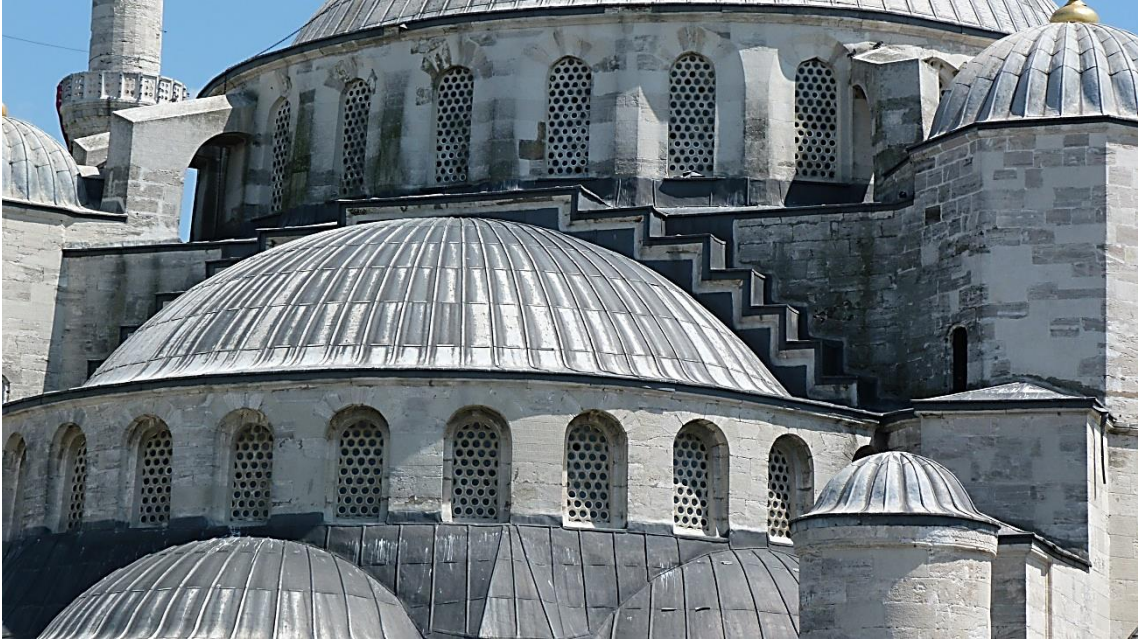
Resim 71. Sultan Ahmed Camii örtü sisteminde ana kubbenin hemen alt seviyesini oluşturan yarım kubbe ana kubbe ve kuleler ilişkisi.
