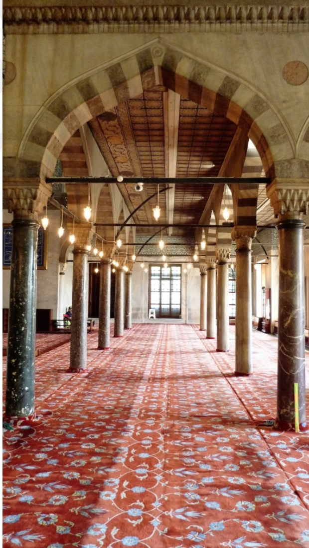
Resim 48. Hünkâr mahfilisütûnlarında breş ve koyu mermer.
