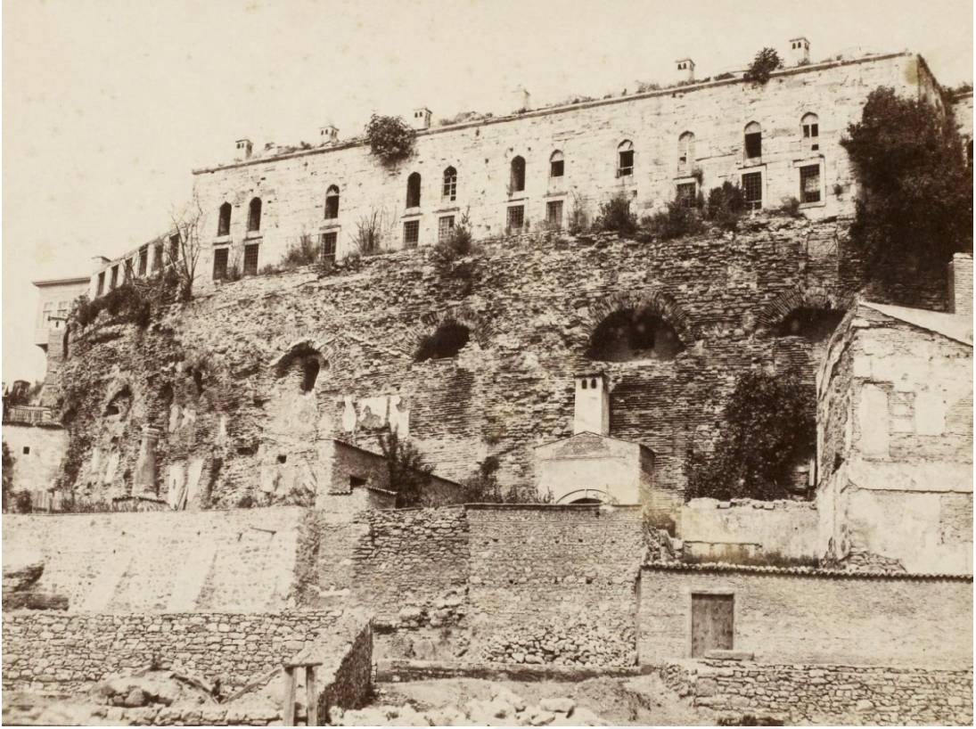
Resim 132. İmaret yapıları, Atmeydanı ve İbrahim Paşa Sarayı altındaki sekiyi oluşturan hipodrom sfendonuna ait kemer sistemi
