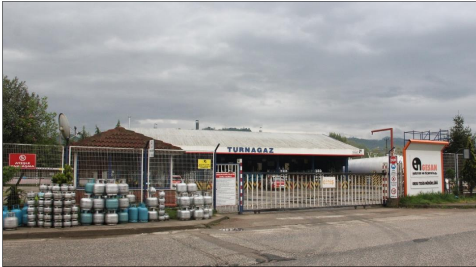
Foto 67: OSB İçerisinde Bulunan Tüp Dolum Tesisi.
