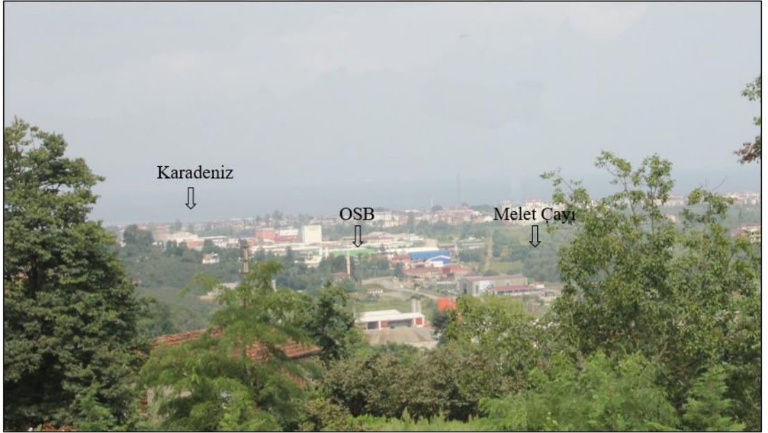
Foto 95: Tarım Alanı Üzerine Kurulan Organize Sanayi Bölgesi İçme Suyu Arıtma Tesisleri Üzerinden Genel Görünümü.
