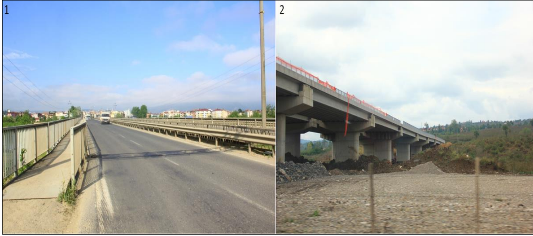
Foto 75: Havzadan Geçen Sahil Yolunu Birleştiren Köprü (1) ile Yeni Yapılan Çevreyolu Viyadüğü (2)
