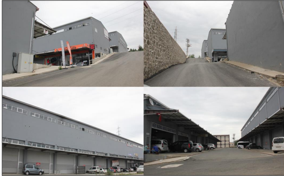
Foto 71: Yeni Yapılan Özel Sanayi Sitesi.
