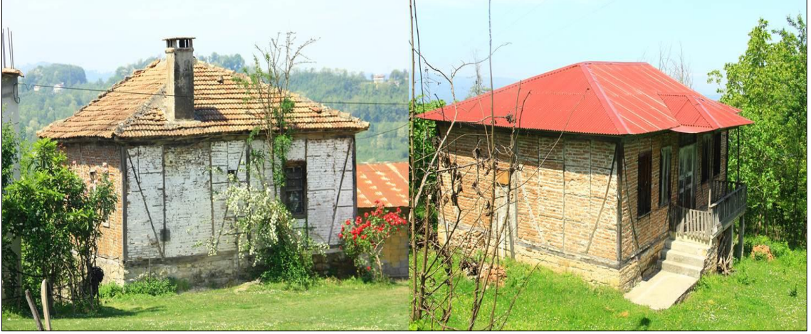
Foto 41: Arpaköy ve Kumrulu Mahallesiinde Havzanın Yöresel Mimari Özellğini Yansıtan Ahşap Destekli Tuğla Dolgulu ve Mesken Olarak Kullanılan Eski Yapılar.
