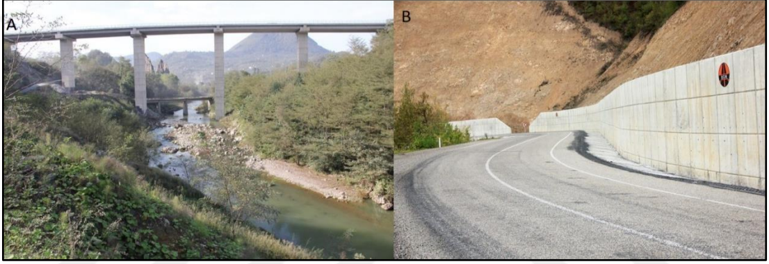
Foto 78: A) Eymür Mahallesi Yakınında Melet Çayı Üzerine İnşa Edilen Yeni ve Eski Köprü, B) Topçam- Mesudiye Yolunun Topçam Mevkiinde Yapımı Tamamlanmış Bölümü.
