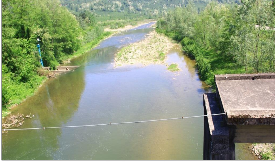
Foto 21: Melet Çayı'nın Gocallı Köprüsünde Akım Gözlem ve Ölçüm İstasyonu.
