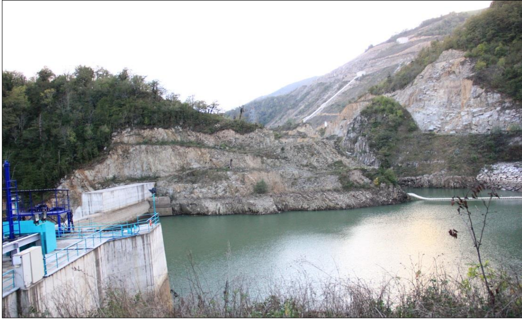
Foto 27: Darıca I HES Su Toplama Alanı (Pınarlı-Darıcabası Arası)
