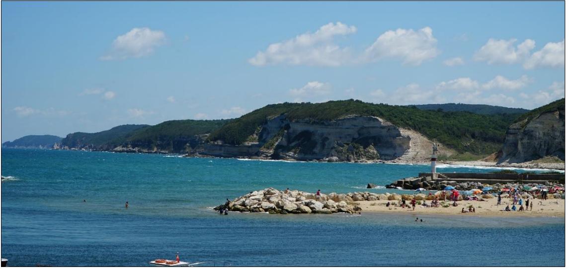
Fotoğraf 31: Kıyıköy Limanı'nda İnşa Edilen Dalgakıranla Dalga Ve Akıntılarının Etkilerinden Korunmaya Çalışılan Bir Kıyı Okunun Görünümü
