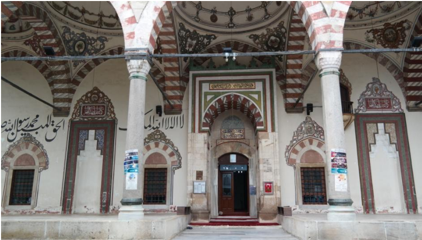
Foto 52 Manisa-Hafsa Sultan Camii Giriş Sofası
