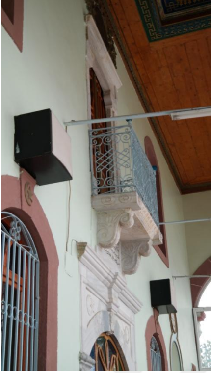
Foto 188 İzmir-Kınık-Poyracık Camii Mükebbiresi
