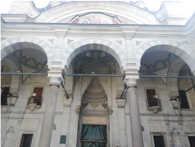
Foto 32 Nuruosmaniye Kuzey Cephesi
