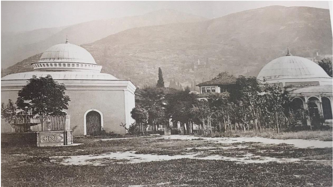
Şekil 20. Osman Gazi ve Orhan Gazi Türbelerinin Kuzeyden Görünümü, 1890 civarı.
