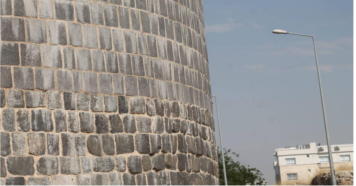
Foto 22; Yapımında bazalt kayalar ve kalkerlerin kullanıldığı Cizre Surları ( Bırca Belek ) – Cizre şehir merkezinin güneybatısı, Dicle Nehri kıyısı
