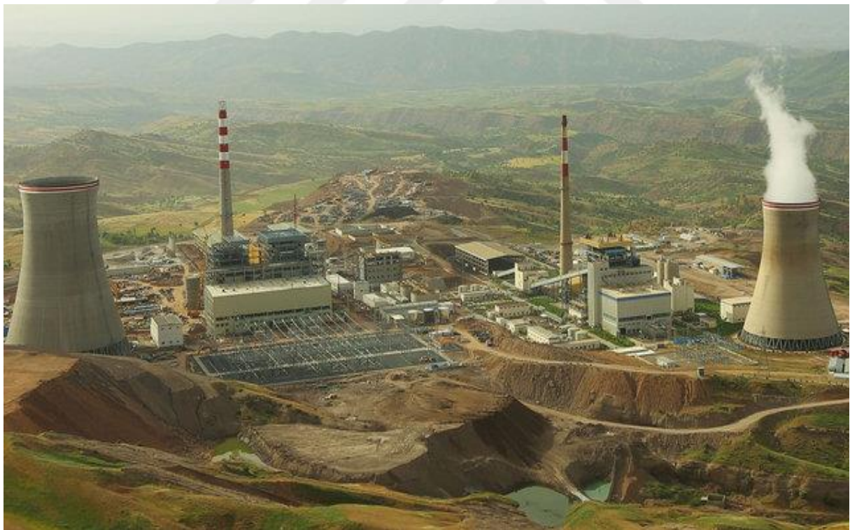
Foto 21; Silopi termik santrali
