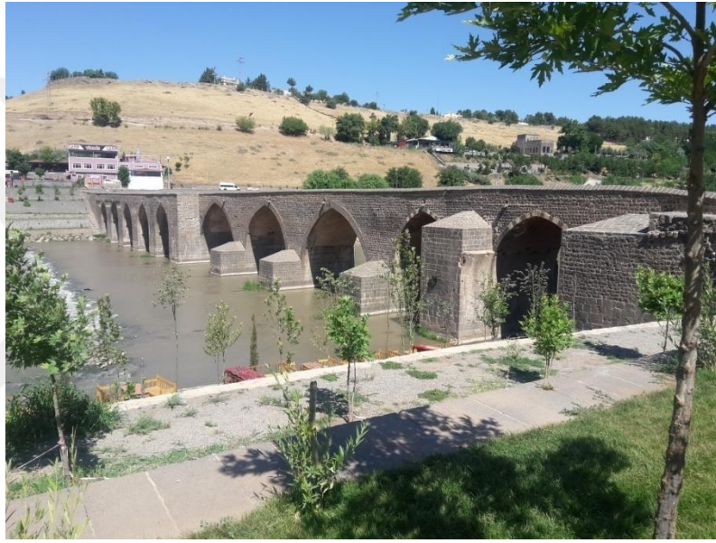
Foto 72: On Gözlü Köprü'nün güneydoğudan görünümü.
