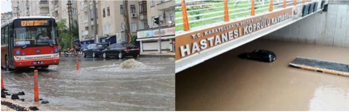
Foto 87: Yoğun yağışlardan sonra altyapı yeterli olmadığından altgeçitler su altında kalmakta ve kanalizasyon sistemi taşmaktadır.
