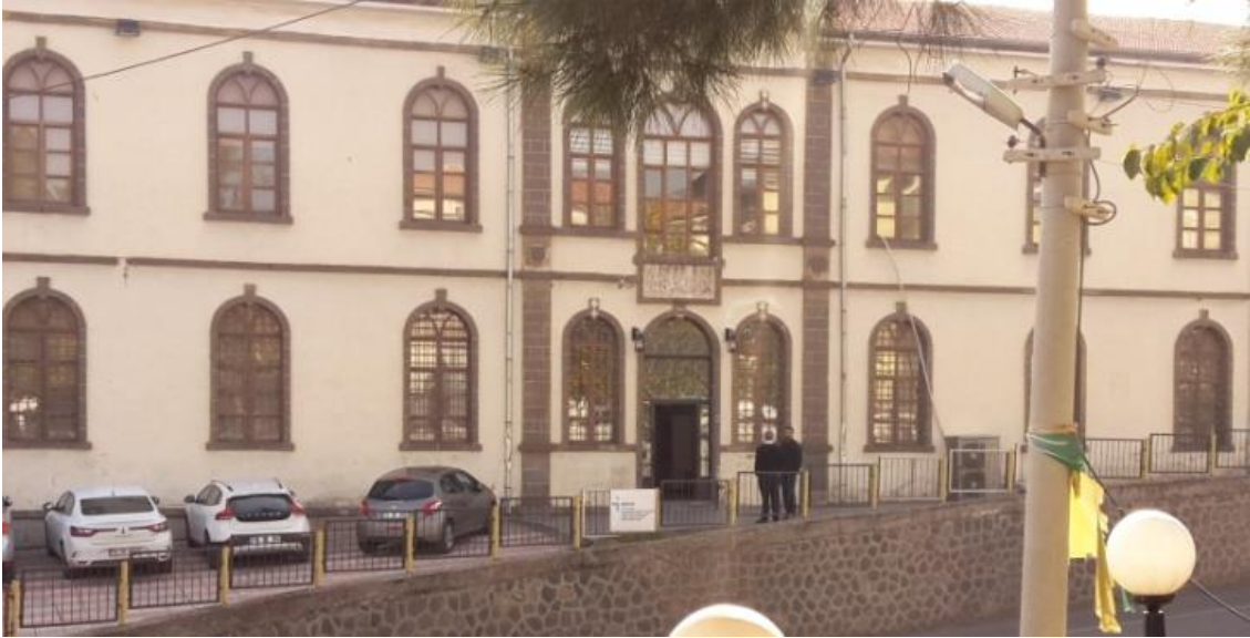
Foto 47: Fiskaya'da Bulunan Diyarbakır Ticaret ve Sanayi Odası'nın Tarihi Binası.
