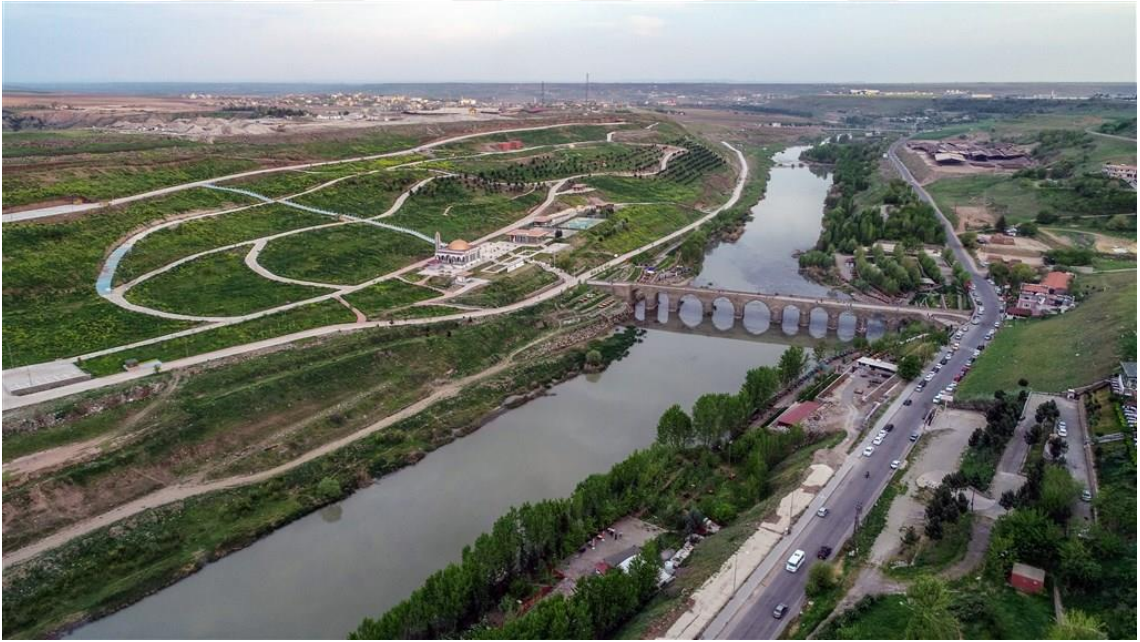
Foto 33: Dicle Vadisi Projesi'nin 1. Etabı Ongözlü Köprü çevresinde tamamlanarak hizmete girmiştir.
