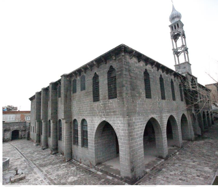
Foto 68: Suriçi’de Savaş Mahallesi Göçmen Sokak’ta bulunan Surp Giragos Ermeni Kilisesi.
