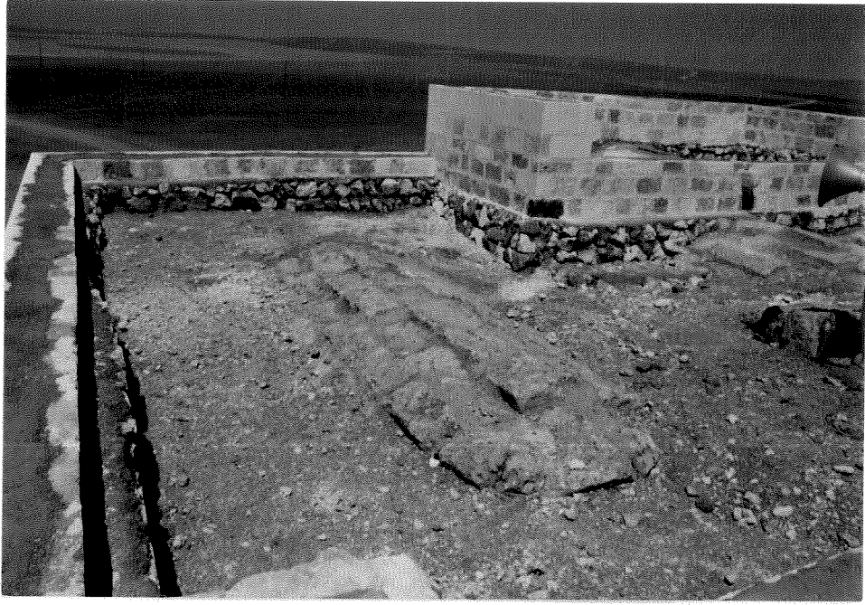
Şekil 4.3.c. Tamirat, giriş eyvanının damı
