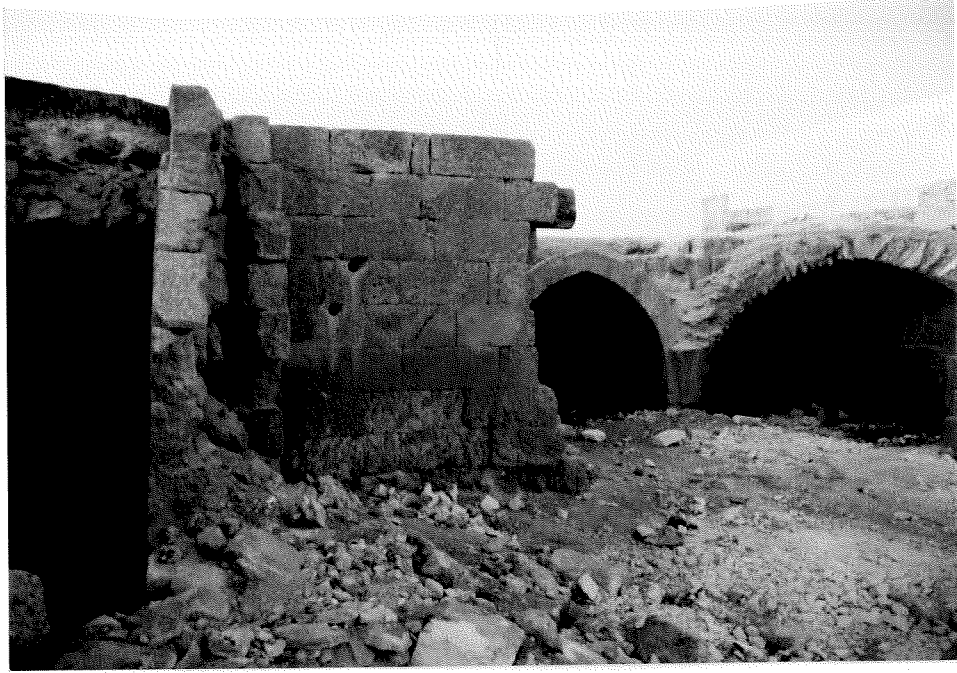
Şekil 3.21.a. Avlunun sağ tarafında bulunan koridor şeklindeki mekanlar
