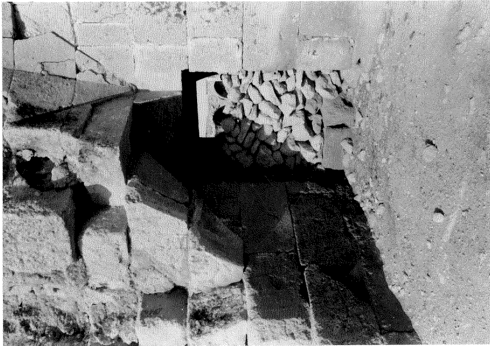
Şekil 3.34.b. Kuzeydoğu köşe mekanı
