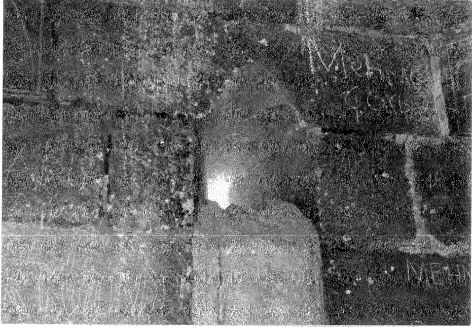
Şekil 3.62.a. Kuzeybatı köşe mekanındaki pencereler
