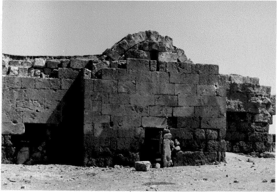
Şekil 3.38.d. Güney cephesi (eyvan)
