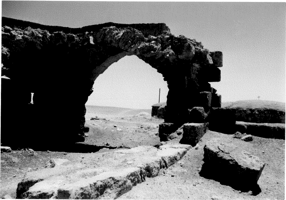
Şekil 3.23.f. Koridor şeklindeki mekanlar
