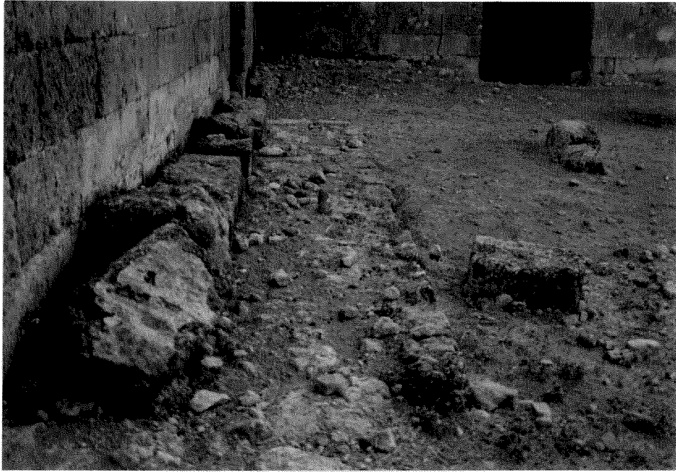
Şekil 3.17.a. Avlu, güneydoğu köşedeki sekiler
