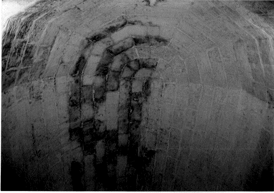
Şekil 3.10.a. Mescidin üst örtüsündeki yarım kubbe
