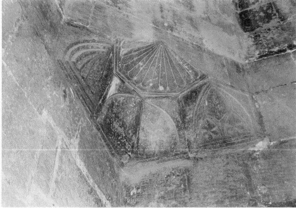
Şekil 3.33.d. Tromp
