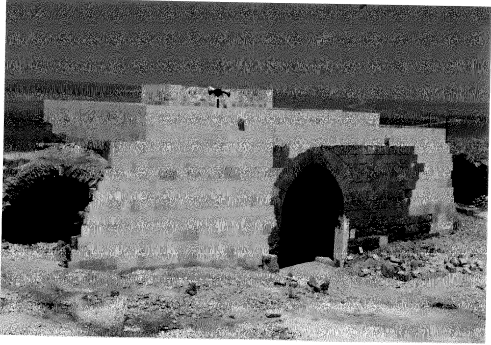
Şekil 4.3.a. Giriş eyvanı, mescid ve karşısındaki odanın avlu duvarlarındaki
