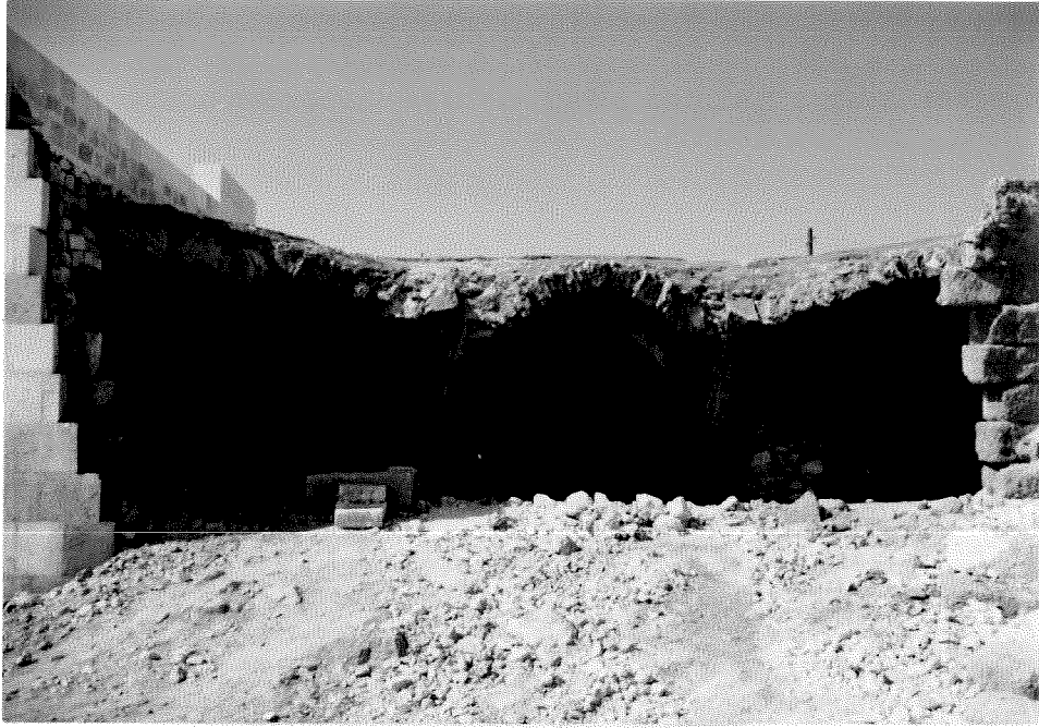
Şekil 3.27.c. Nişlere benzeyen mekanlar
