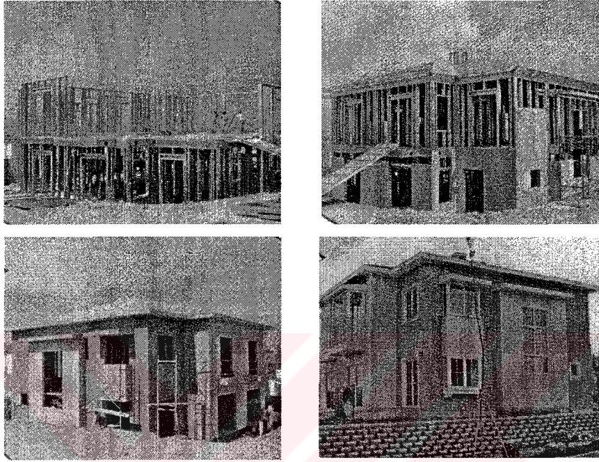
Şekil 2. 23. Hafif çelik yapı üretim aşamaları uygulama örneği (Akşan)
