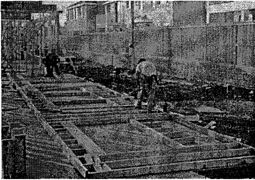
Şekil 2. 8. Subasman betonu üzerine döşeme elemanlarının tespiti (Hulka)
