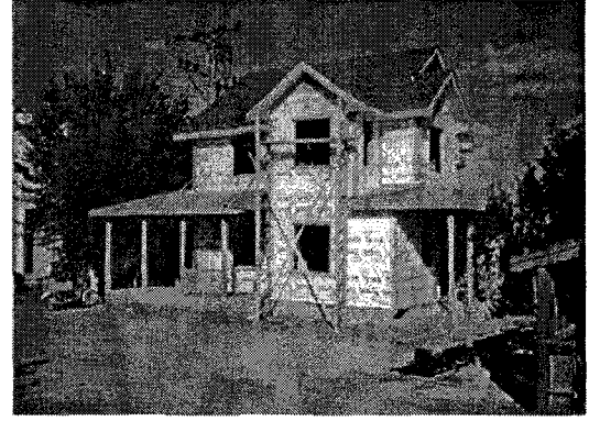
Şekil 2. 13. Montajı tamamlanmış ahşap karkas bina (Hamle)
