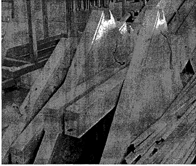
Şekil 2. 17. İçlerine taşıma kayışları yerleştirilmiş çatı panelleri (Konkur)
