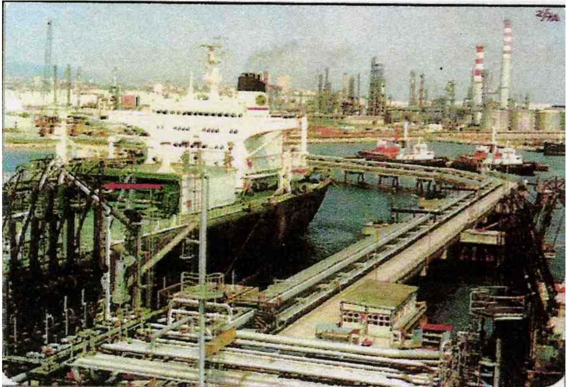
Resim 5.18. Dolum kolunun kırılması nedeniyle LPG kaçađı meydana gelmiřtir [15]
