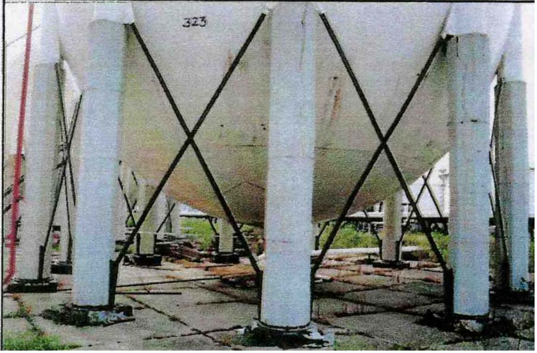
Resim 5.19. LPG küresinin bütün ayakları burulmuştur [15]
